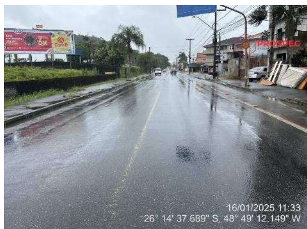
Figura 29: Condições da sinalização - Sinalização horizontal precária nas faixas de rolamento em frente ao imóvel.
