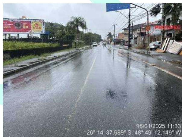
Figura 31: Condições da sinalização - Sinalização horiz. precária e/ou inexistente nas faixas de rolamento em frente ao imóvel.
