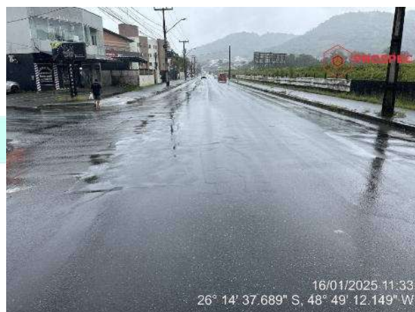
Figura 29: Condições da sinalização - Sinalização horizontal precária nas faixas de rolamento em frente ao imóvel.
