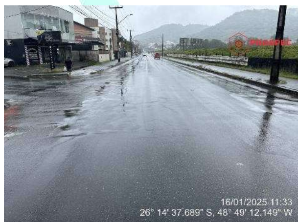
Figura 31: Condições da sinalização - Sinalização horiz. precária e/ou inexistente nas faixas de rolamento em frente ao imóvel.
