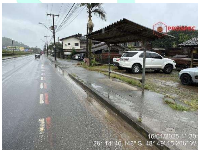
Figura 36: Abrigo de passageiro em frente ao imóvel – Sentido Centro
