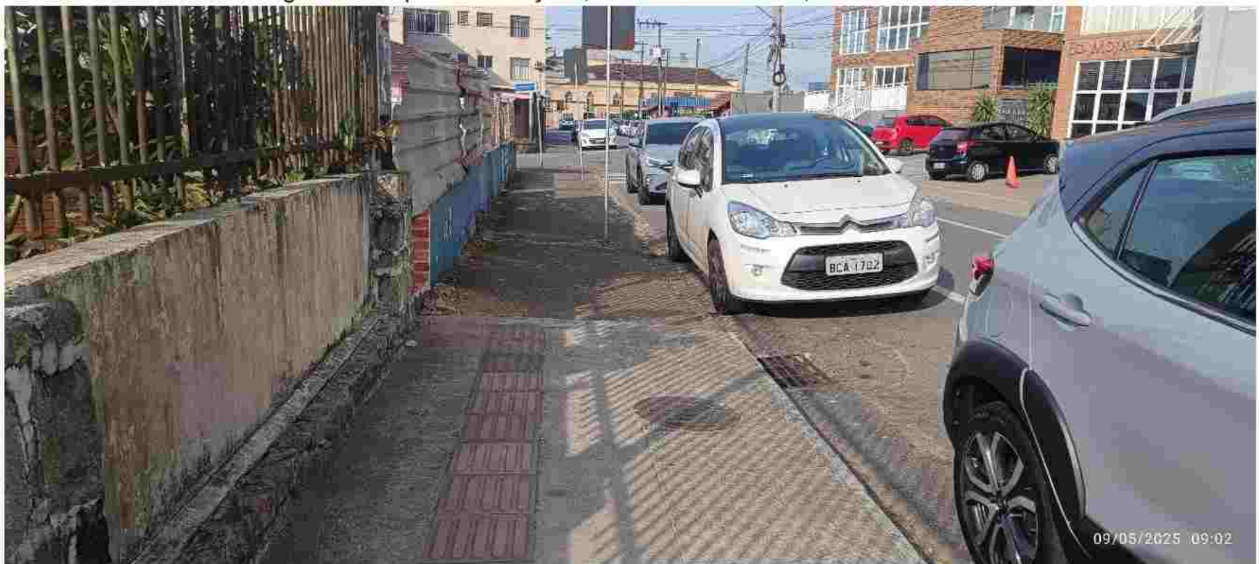
Figura 22: Aspecto da calçada, entorno do imóvel.
