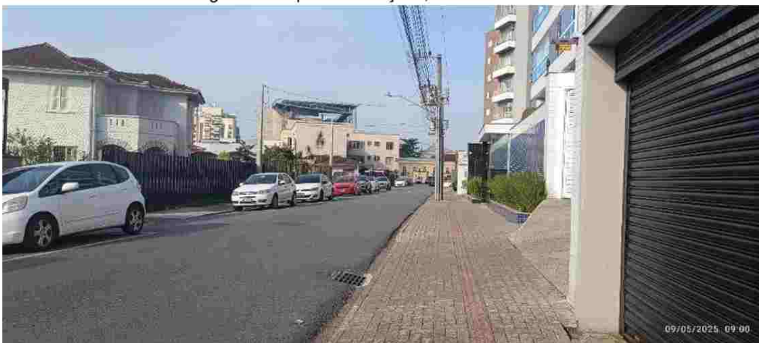
Figura 68: Aspecto da calçada, em frente ao imóvel.
