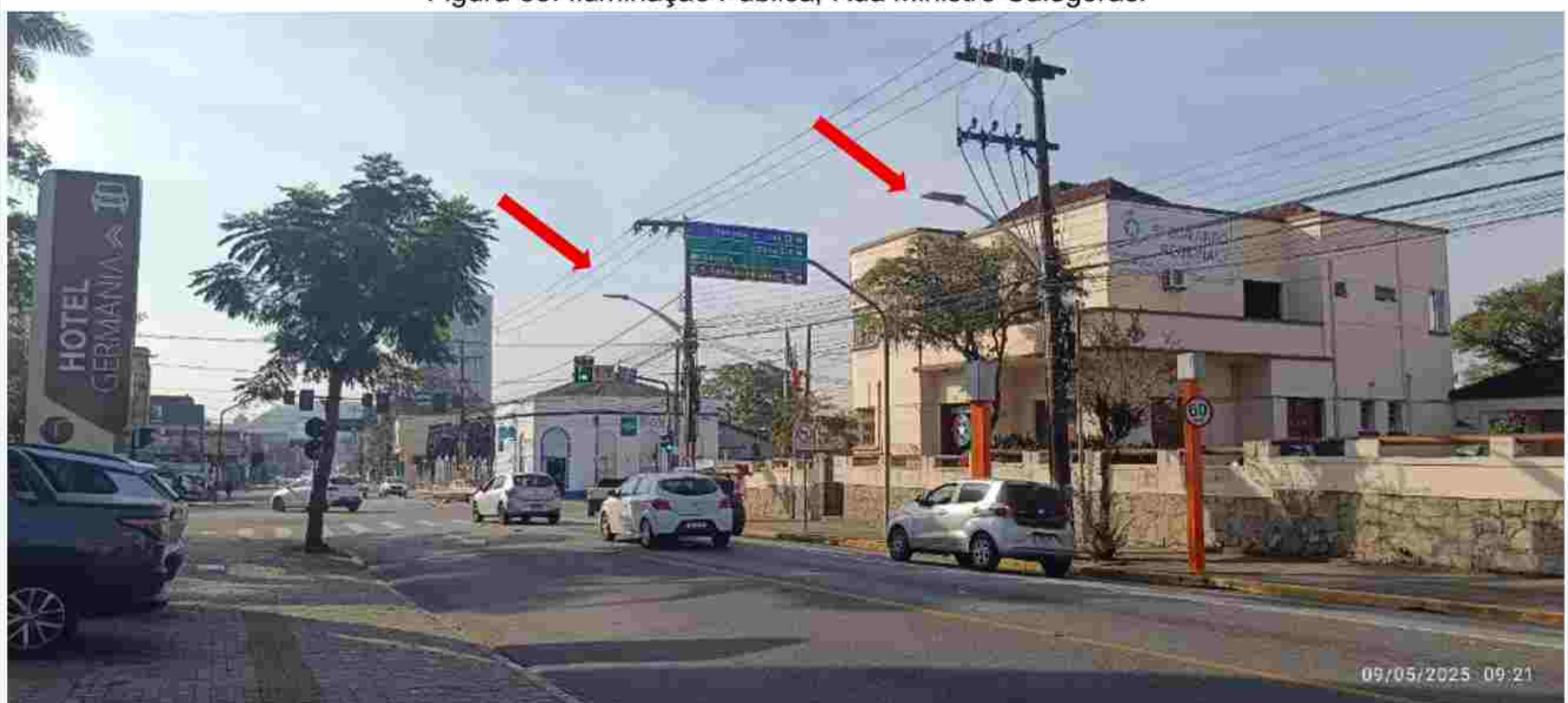
Figura 37: Iluminação Pública, Rua Ministro Calógeras.
