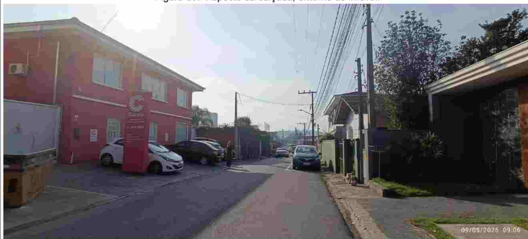
Figura 70: Aspecto da calçada, entorno do imóvel.
