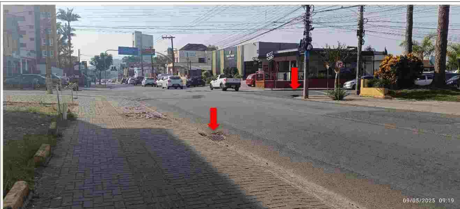
Ponto de Drenagem, Rua Ministro Calógeras.
