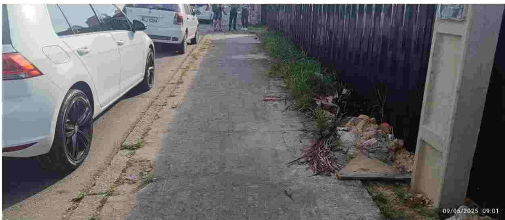
Figura 43: Calçada em frente ao imóvel em estudo.
