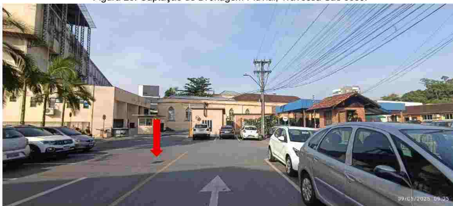
Figura 27: Captção de Drenagem Pluvial, Travessa São José.
