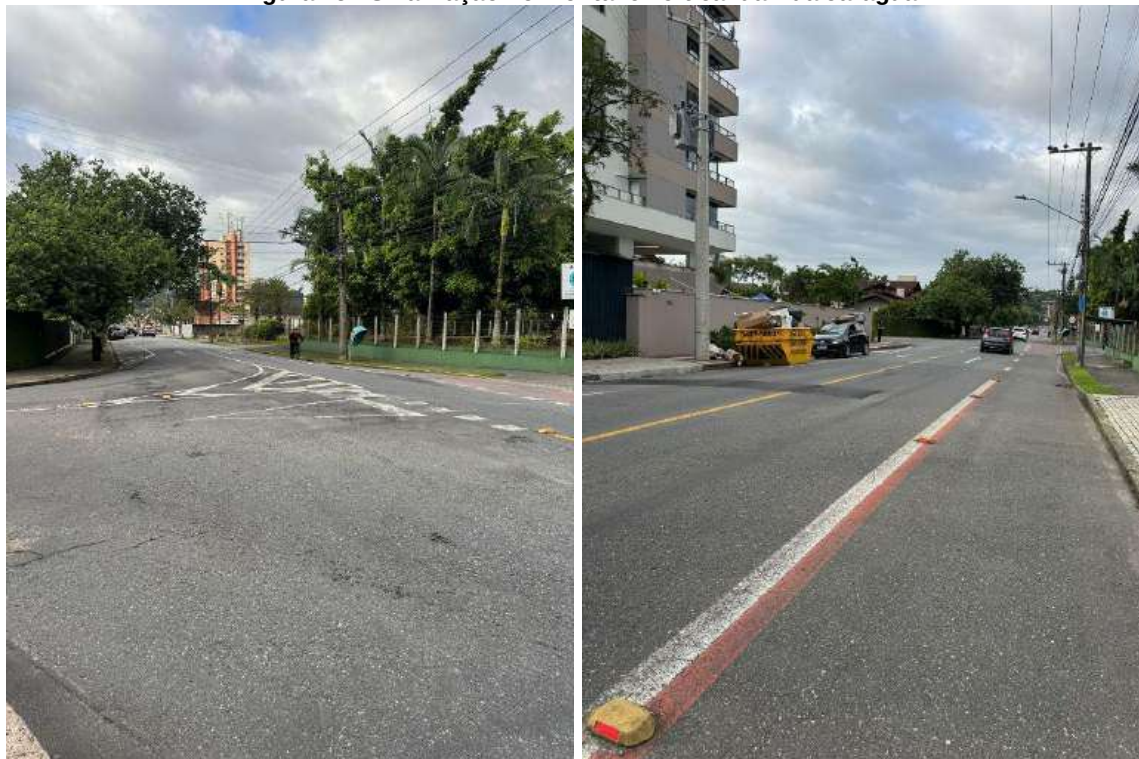
Figura 15 - Sinalização horizontal e vertical da Rua Jaraguá
