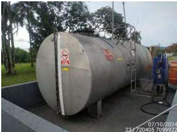
Figura 37 - Tanque de abastecimento de embarcações
