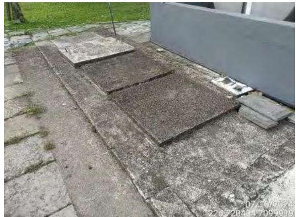
Figura 38 - Caixa de sedimentação de partículas e separador de água e óleo anexa ao tanque de abastecimento de embarcações.
