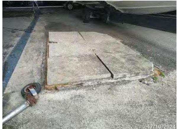
Figura 36 - Caixa de sedimentação de partículas e separador de água e óleo anexa ao Galpão 3.
