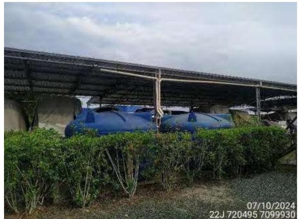
Figura 28 – Sistema de captação e reservação de água da chuva.
