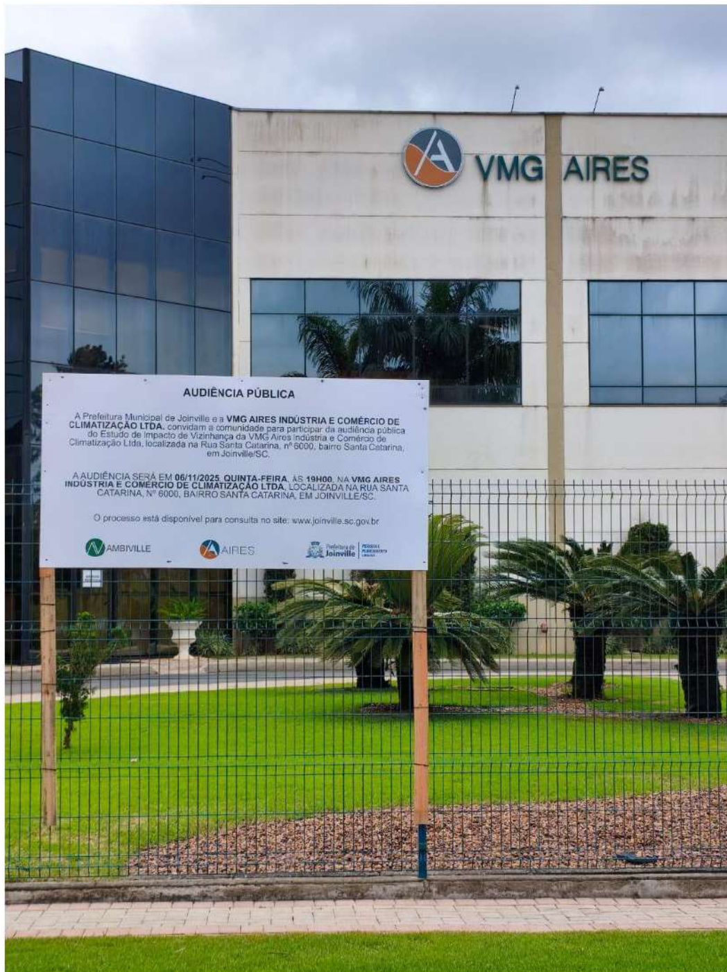
Figura 1: Placa instalada na testada do imóvel.
