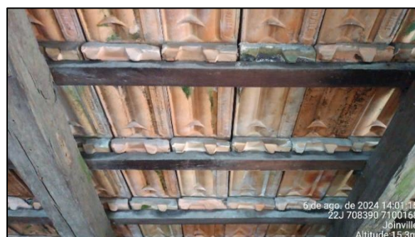
Detalhe das telhas encaixadas – Casa Kruger Localização: 22J 708412 7100166
