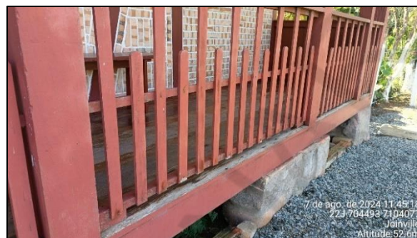
Estrutura elevada e parapeito– Casa Osni Fleith
