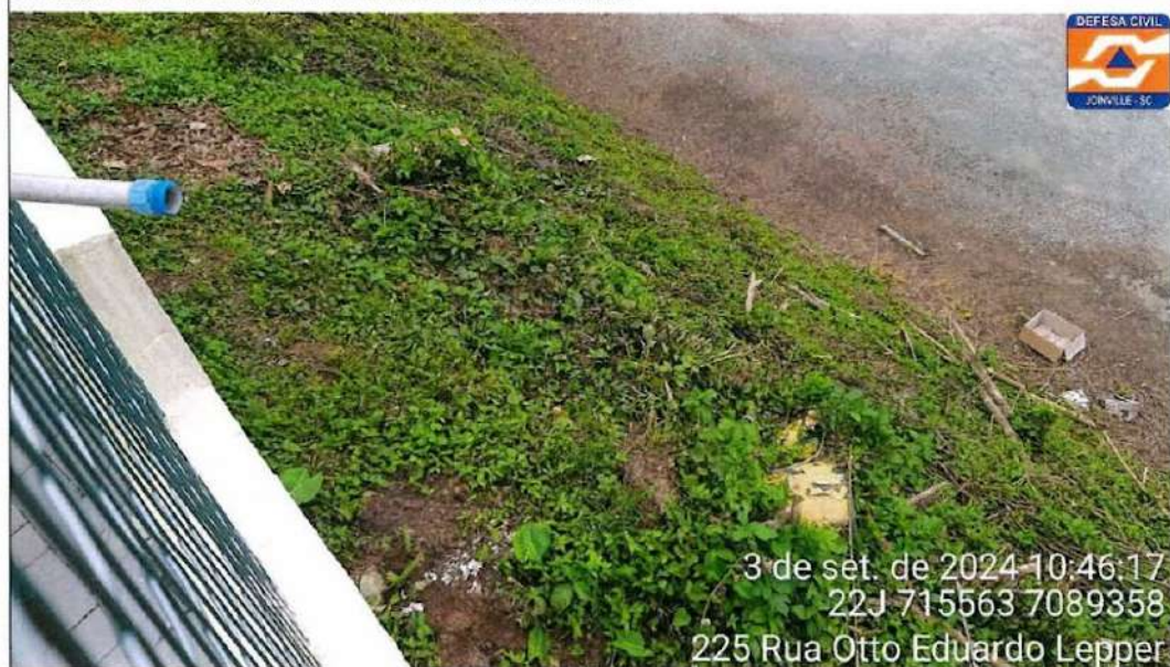
Degrau de abatimento indicando movimentação
