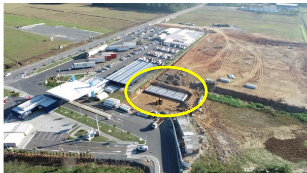
Bacia de retenção de águas pluviais – etapa 2
