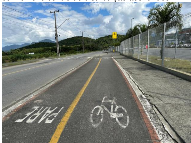
Sinalização da ciclofaixas em frente a Krona em direção à Rodovia Rodolfo Jahn
