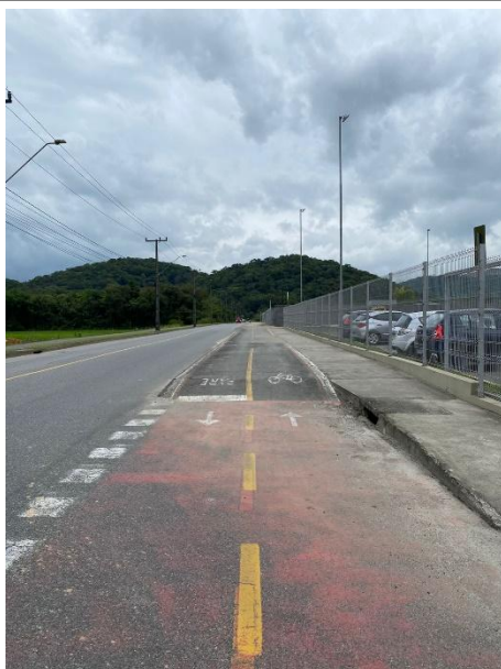
Iluminação do estacionamento da Krona
