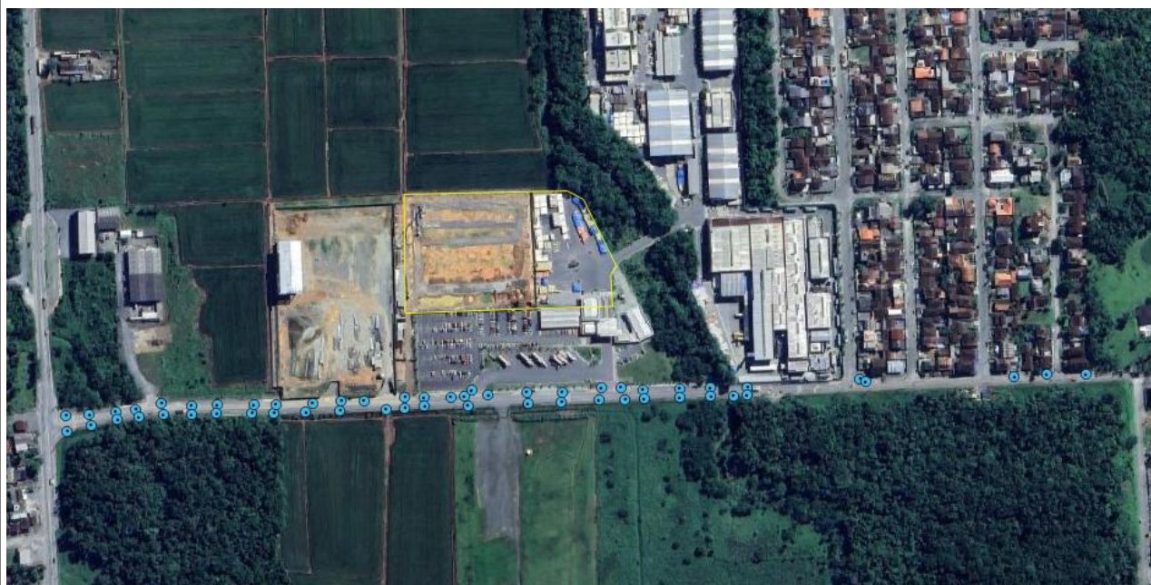
Dispositivos de drenagem.
