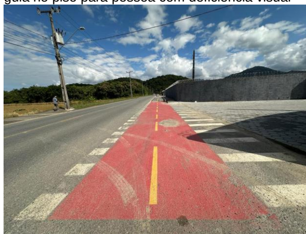
Ciclofaixa em bom estado de conservação em frente ao galpão objeto do EIV
