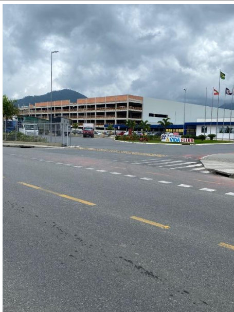
Pavimentação e faixa de pedestres em frente ao acesso à empresa
