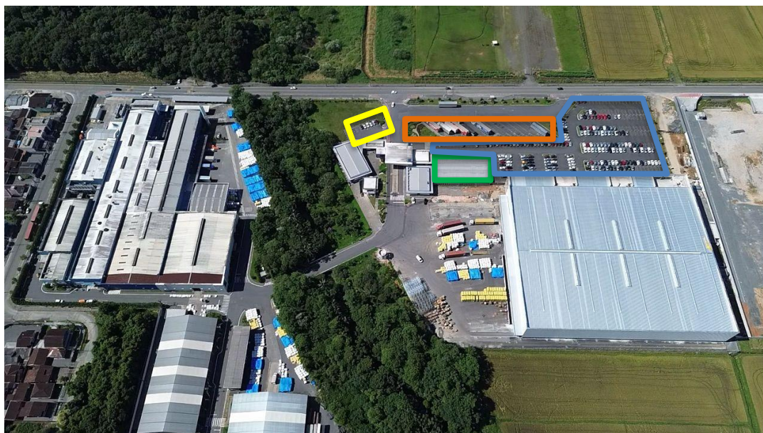
Estacionamento interno da Krona.
