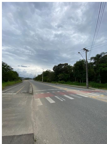
Calçada com acessibilidade e faixa de pedestres
