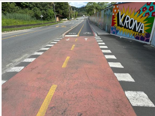
Início das ciclofaixas na esquina com a Rua Amadus Jacob em bom estado de conservação
