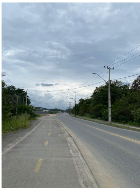
Calçada e ciclofaixa
