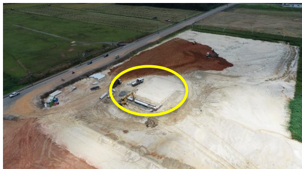
Bacia de retenção de águas pluviais – etapa 1
