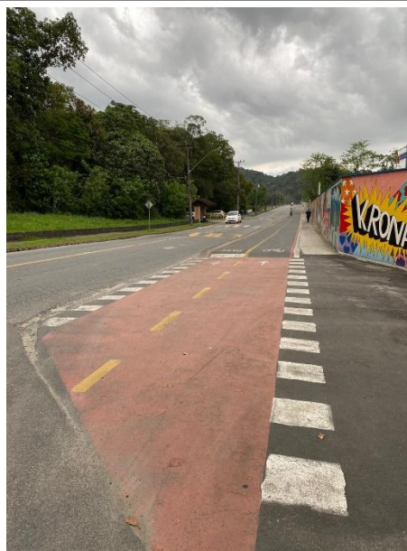
Ciclofaixa em bom estado de conservação
