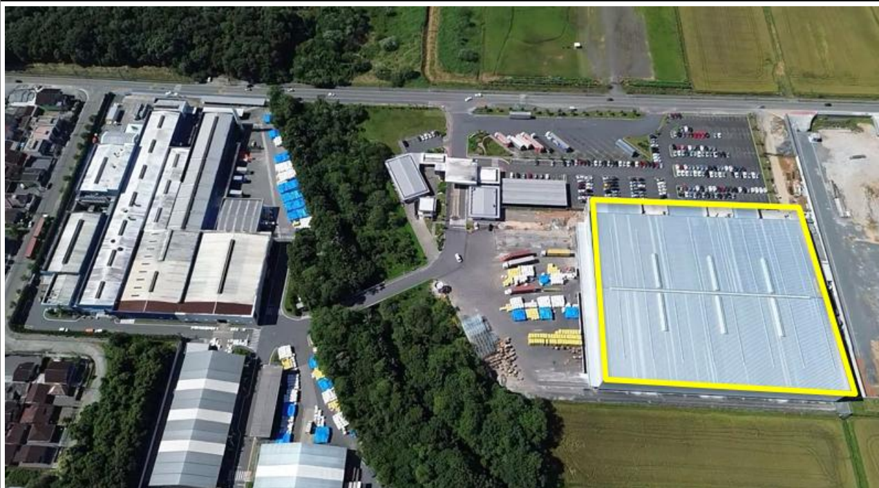
Galpão construído de 17.021,30 m²
