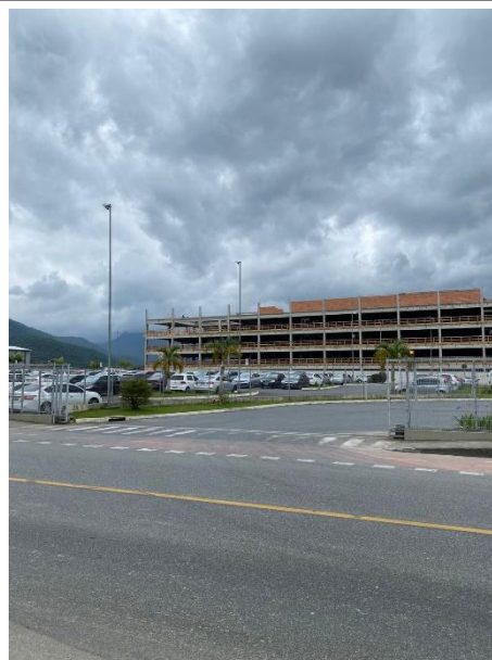
Iluminação do estacionamento da Krona
