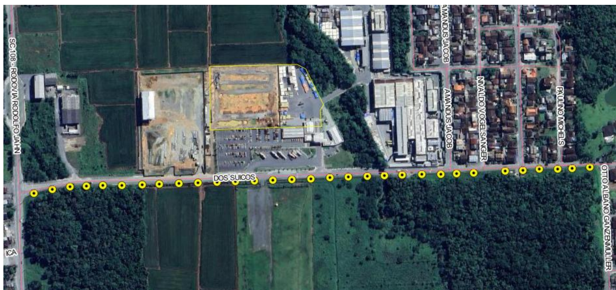
Postes de iluminação pública.
