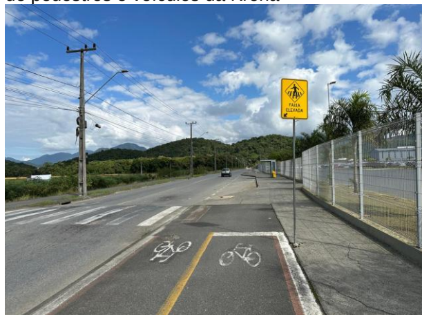
Faixa elevada com sinalização apagada em frente a Krona
