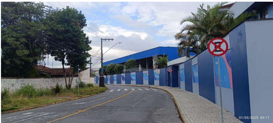
Figura 14: Rua Guaramirim, sentido Rua Dona Francisca.
