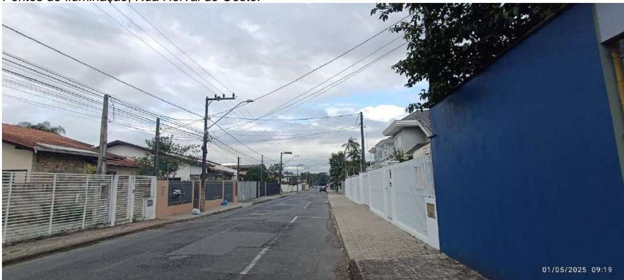
Pontos de Iluminação, Rua Guaramirim.
