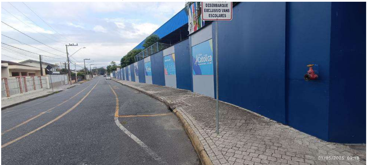
Figura 58: Aspecto calçada, Rua Guaramirim.
