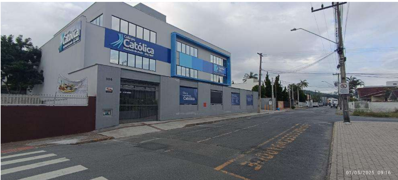
Figura 59: Aspectos da Calçada, Unidade Ensino Médio, lado esquerdo
