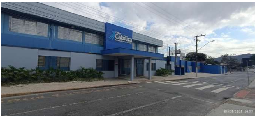
Figura 107: Fachada frontal, Unidade Educação Infantil.
