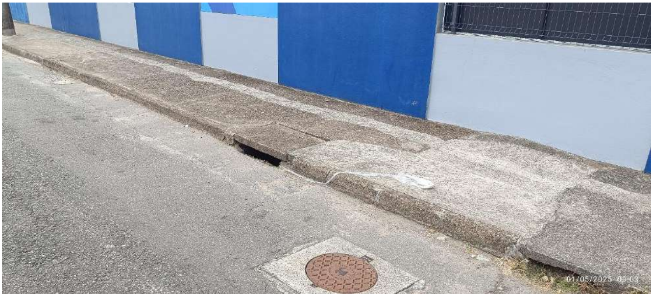
Ponto de Drenagem na Rua Saudades.
