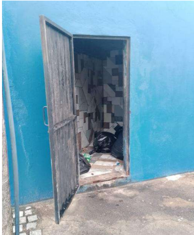
Figura 38: Lixeira para Armazenamento de Resíduo.
