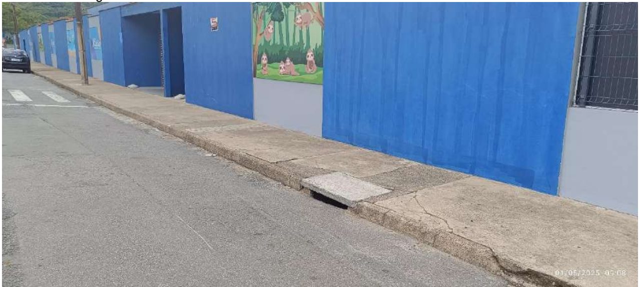
Ponto de Drenagem na Rua Saudades.
