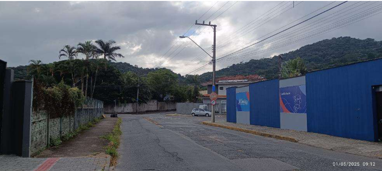
Figura 61: Aspecto calçada, Rua Saudades.
