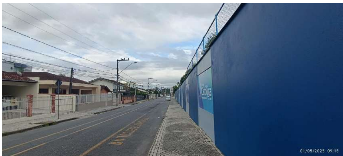
Figura 36: Iluminação Pública, Rua Guaramirim, sentido Dona Francisca.
