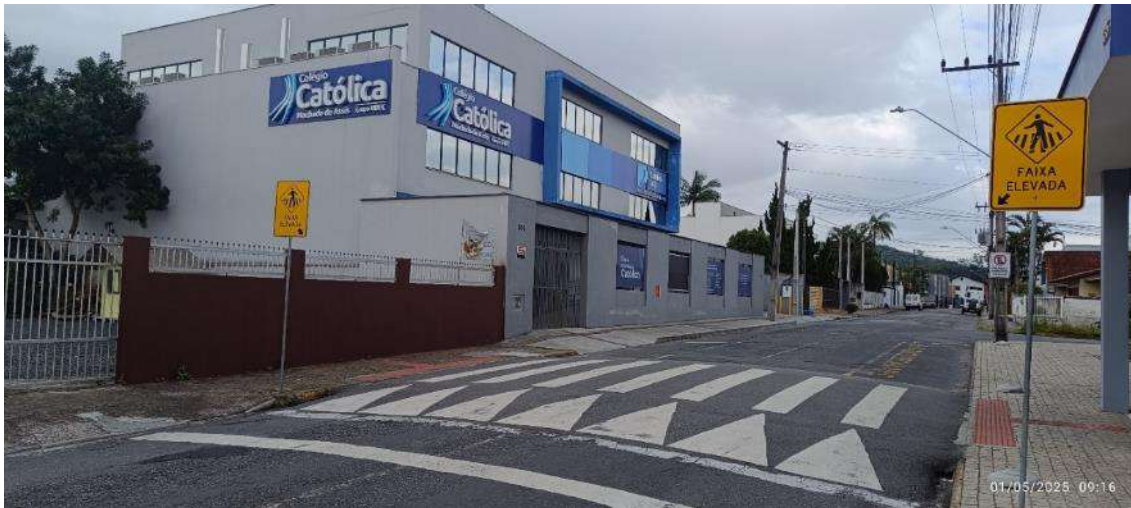
Figura 46: Sinalização horizontal e vertical para travessia de pedestres na rua Herval do Oeste, em frente ao imóvel em estudo.
