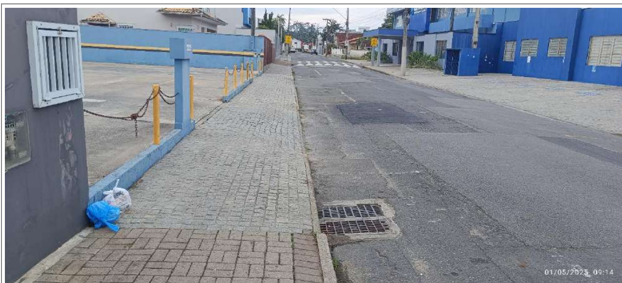
Ponto de Drenagem, Rua Herval do Oeste em frente ao empreendimento.
