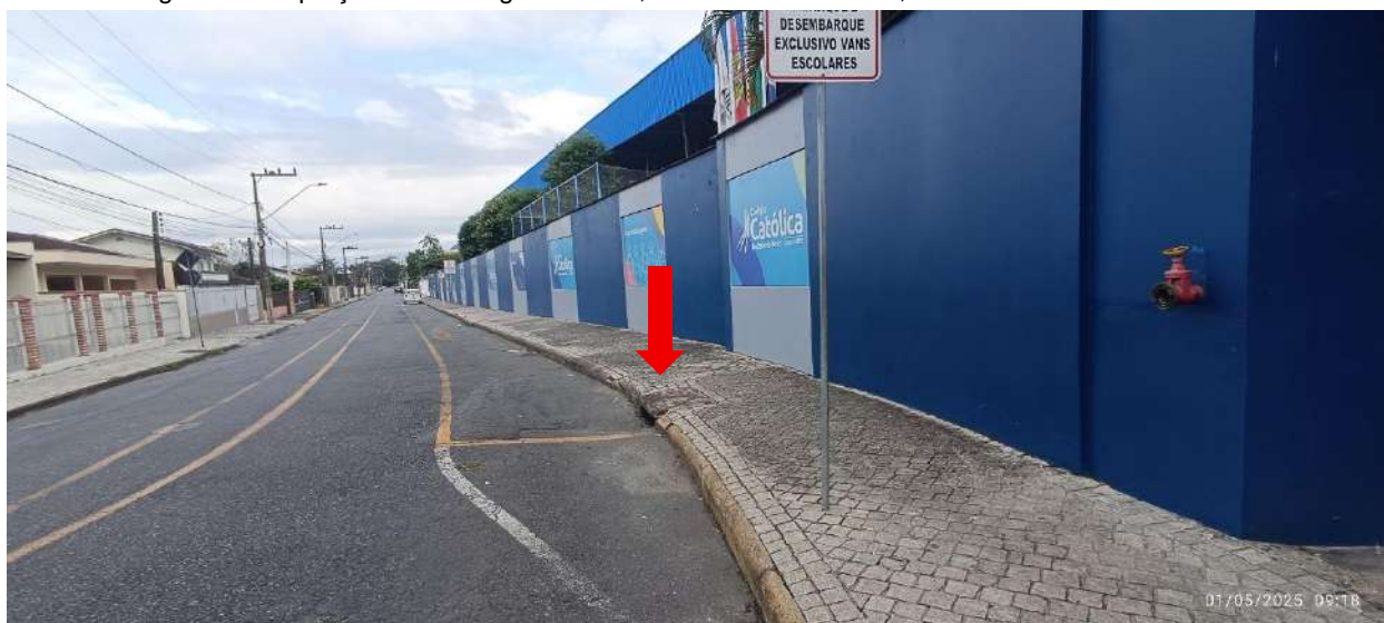
Figura 31: Captação de Drenagem Pluvial, Rua Guaramirim.
