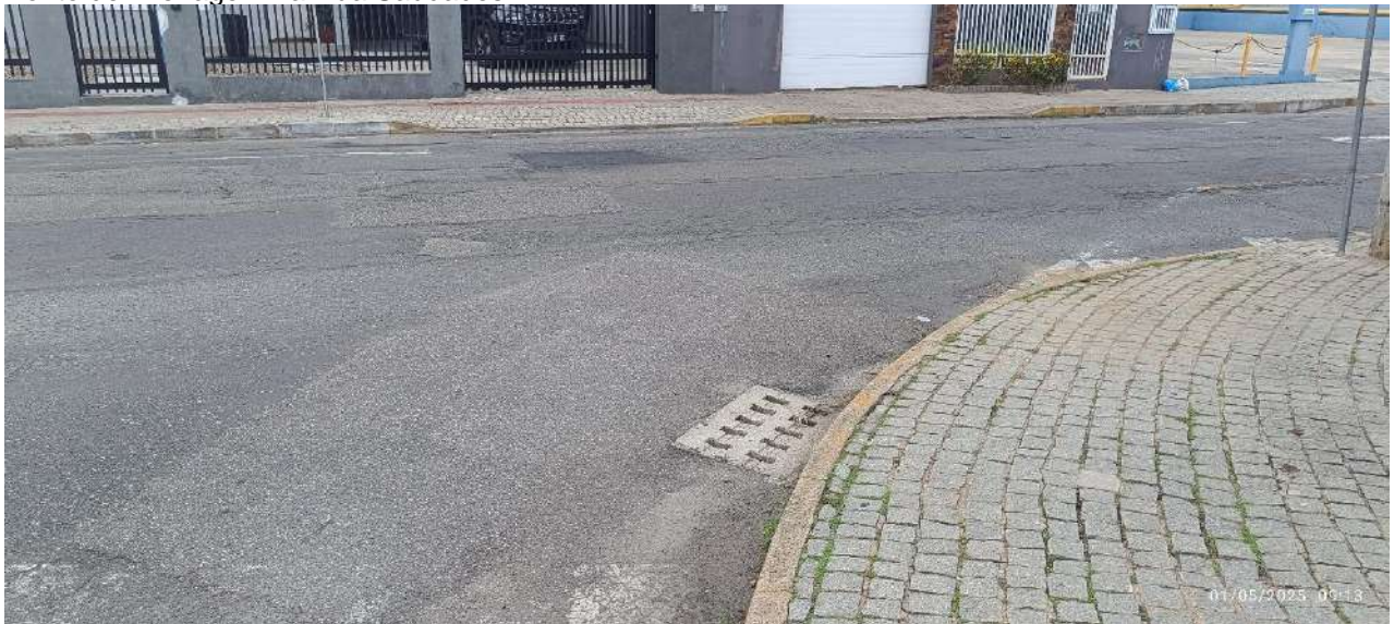
Ponto de Drenagem, Rua Herval do Oeste esquina com a Rua Saudades.
