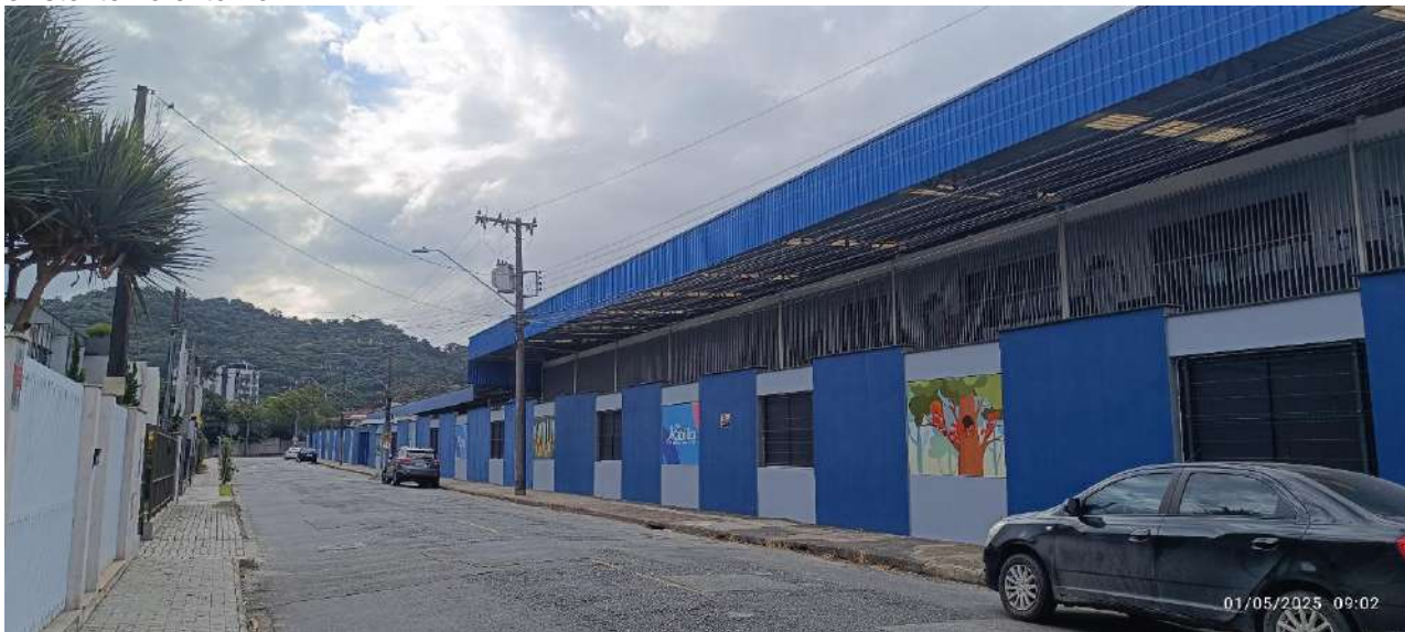
Pontos de Iluminação, Rua Saudades.
