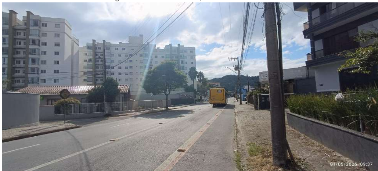
Figura 71: Faixa Exclusiva para Ônibus, Rua Carlos Benack.
