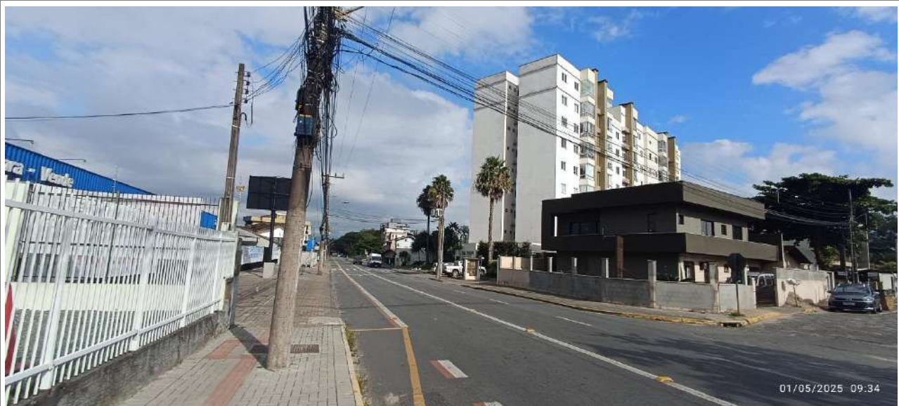
Figura 23: Aspecto das calçadas, Rua Carlos Benack.
