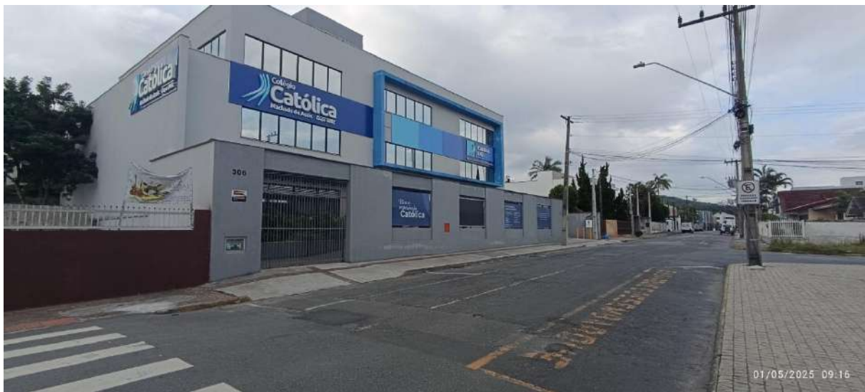
Figura 20: Aspecto da calçada, Unidade de Ensino Médio, lado esquerdo.
