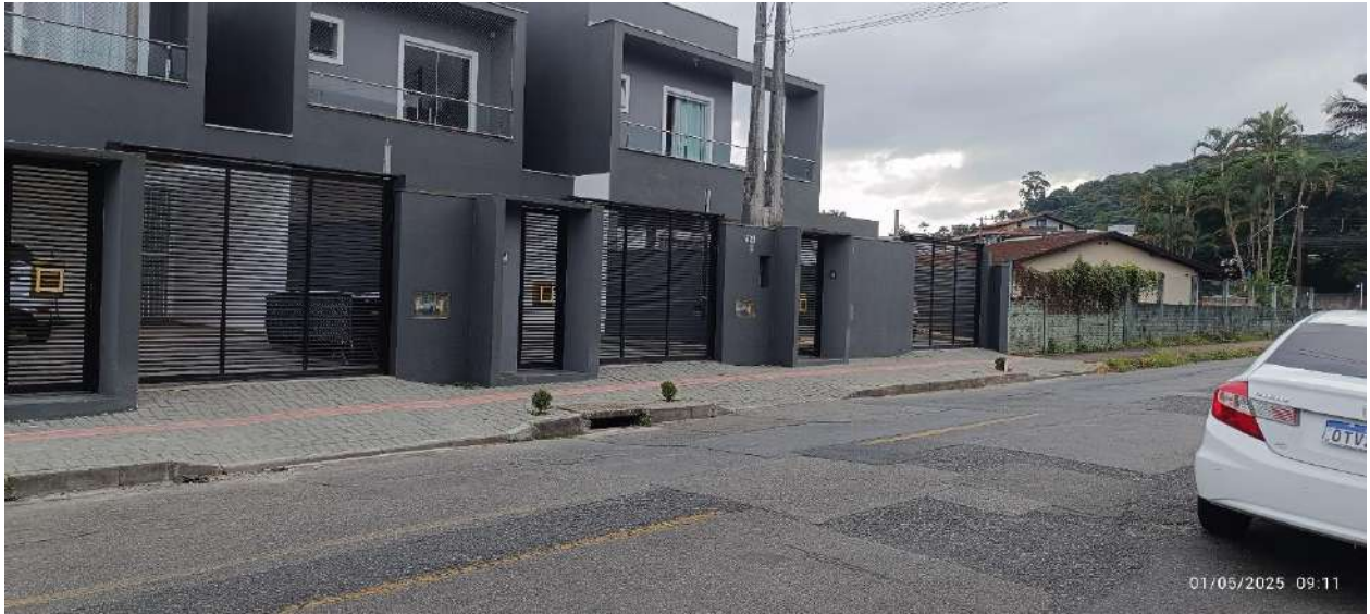
Figura 60: Aspecto calçada, Rua Saudades.
