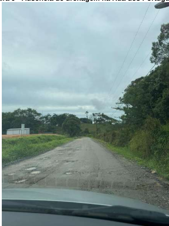
Figura 9 - Ausência de drenagem na Rua dos Portugueses
