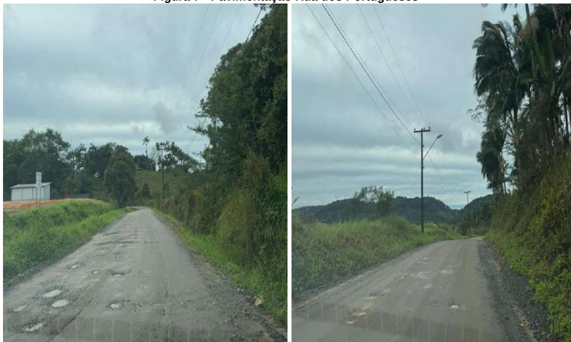
Figura 7 - Pavimentação Rua dos Portugueses
