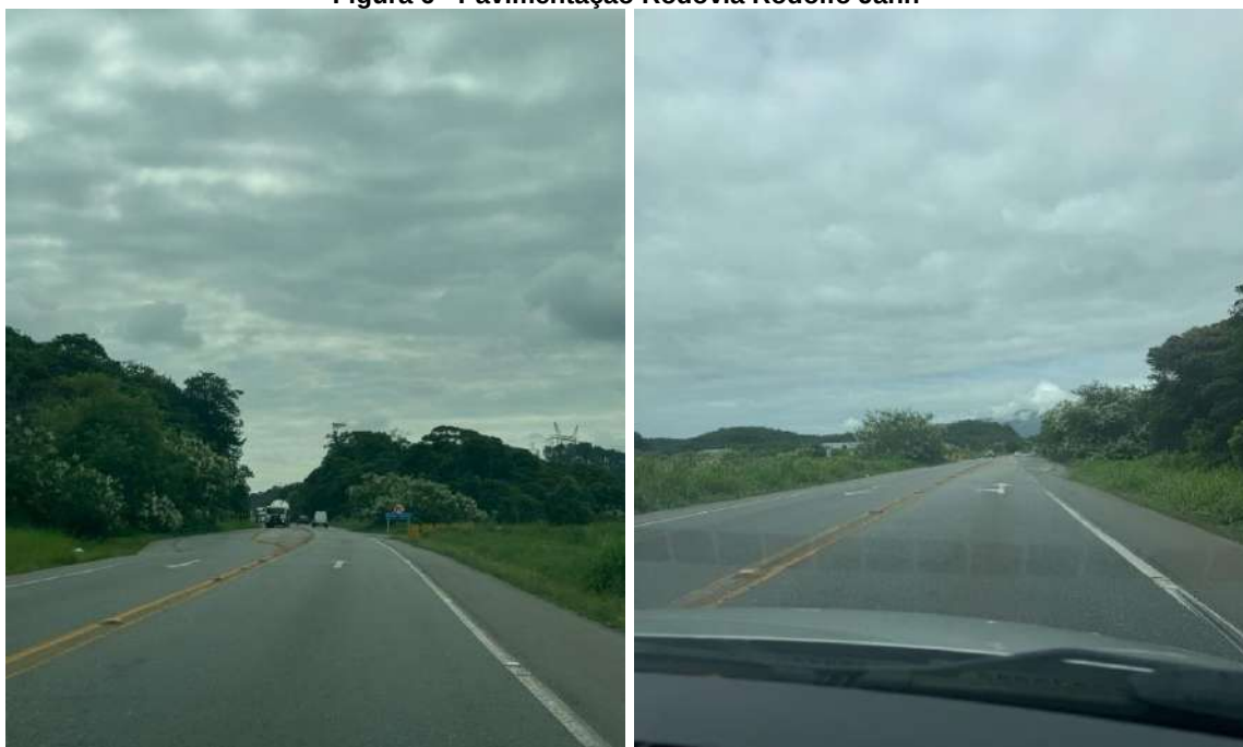
Figura 6 - Pavimentação Rodovia Rodolfo Jahn
