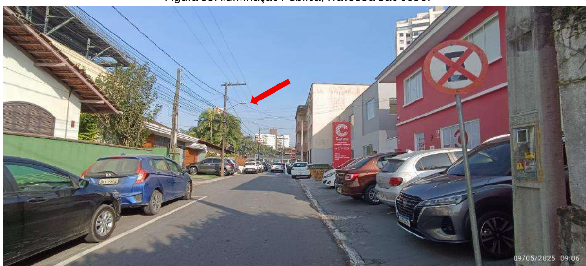
Figura 34: Iluminação Pública, Rua Dr. Carlos Lang.
