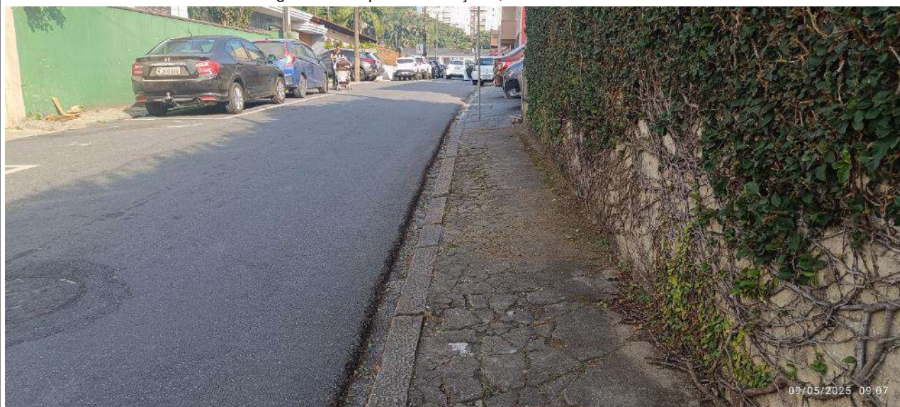
Figura 71: Aspecto da calçada, entorno do imóvel.
