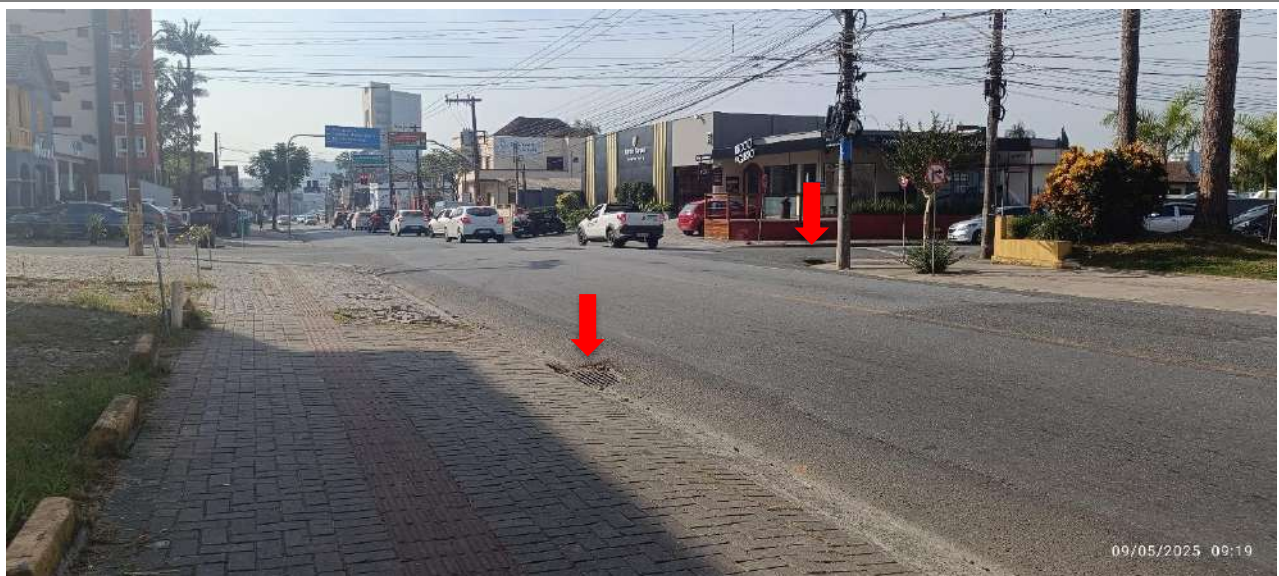
Ponto de Drenagem, Rua Ministro Calógeras.
