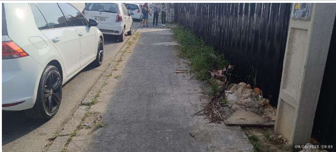
Figura 66: Aspecto da calçada, em frente ao imóvel.
