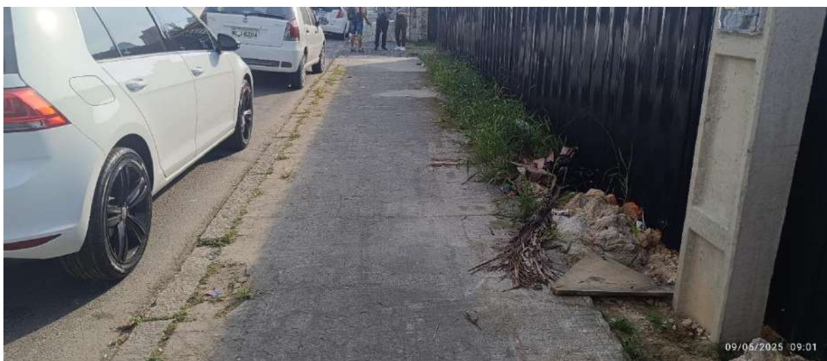
Figura 43: Calçada em frente ao imóvel em estudo.
