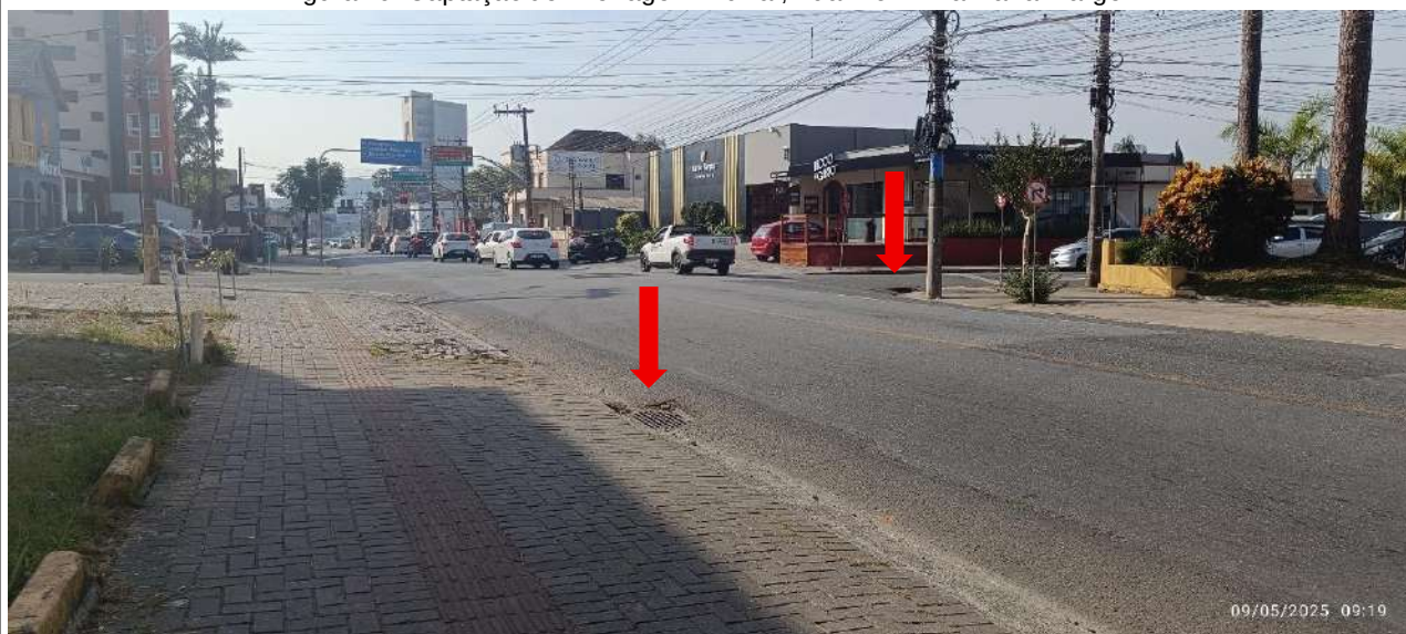
Figura 30: Captação de Drenagem Pluvial, Rua Ministro Calógeras.
