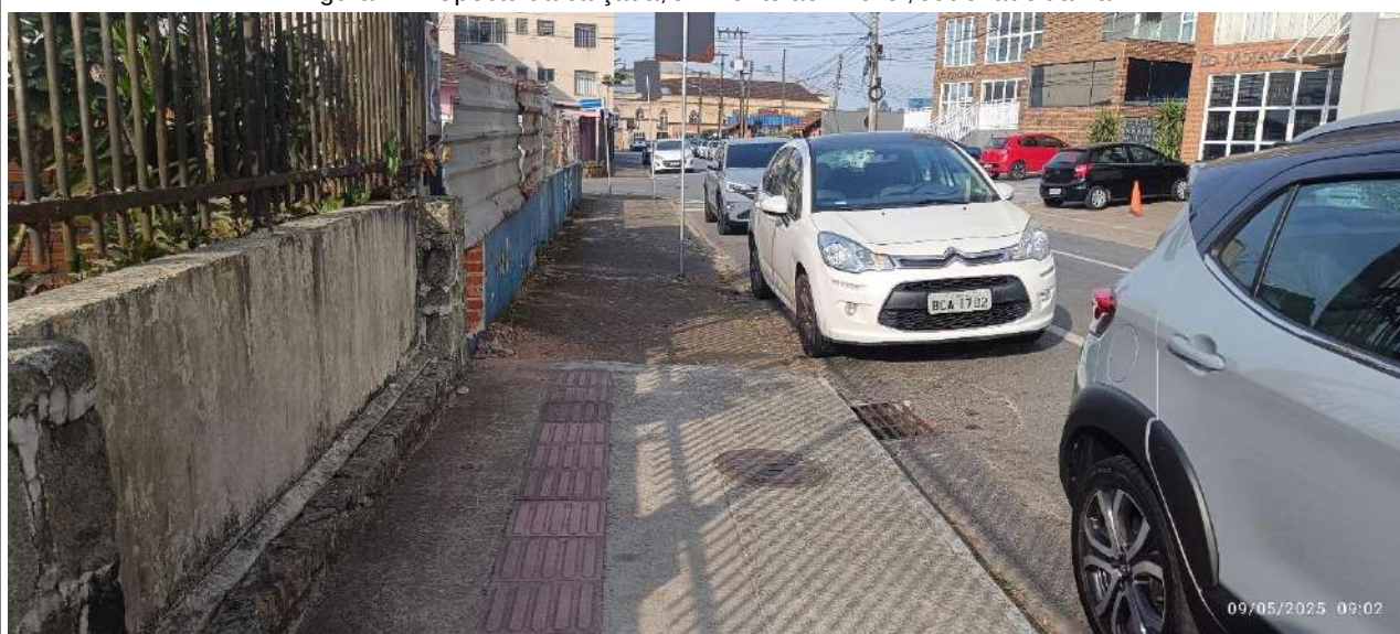
Figura 22: Aspecto da calçada, entorno do imóvel.
