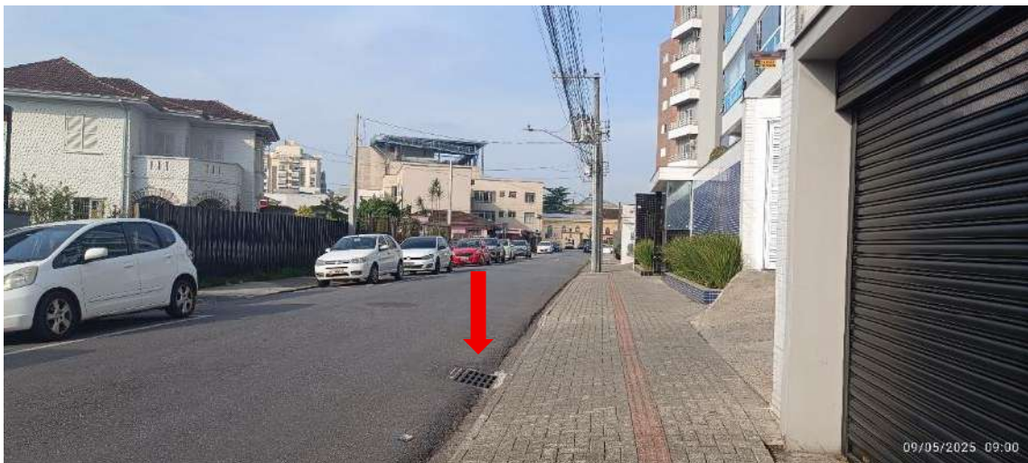
Figura 25: Captção de Drenagem Pluvial, em frente ao local de estudo.
