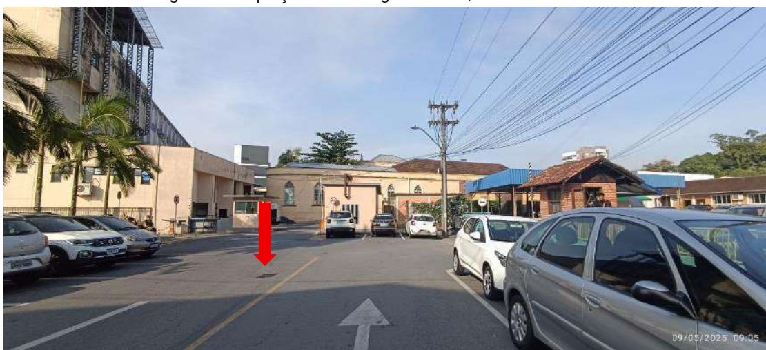
Figura 27: Captção de Drenagem Pluvial, Travessa São José.
