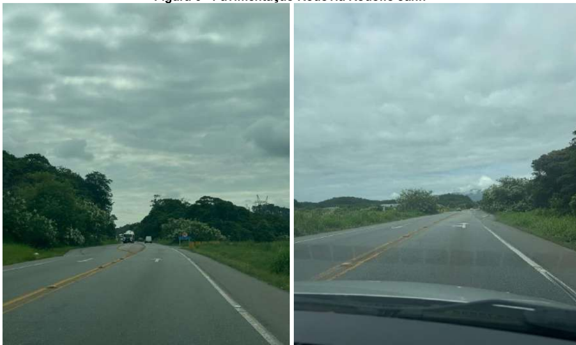
Figura 6 - Pavimentação Rodovia Rodolfo Jahn
