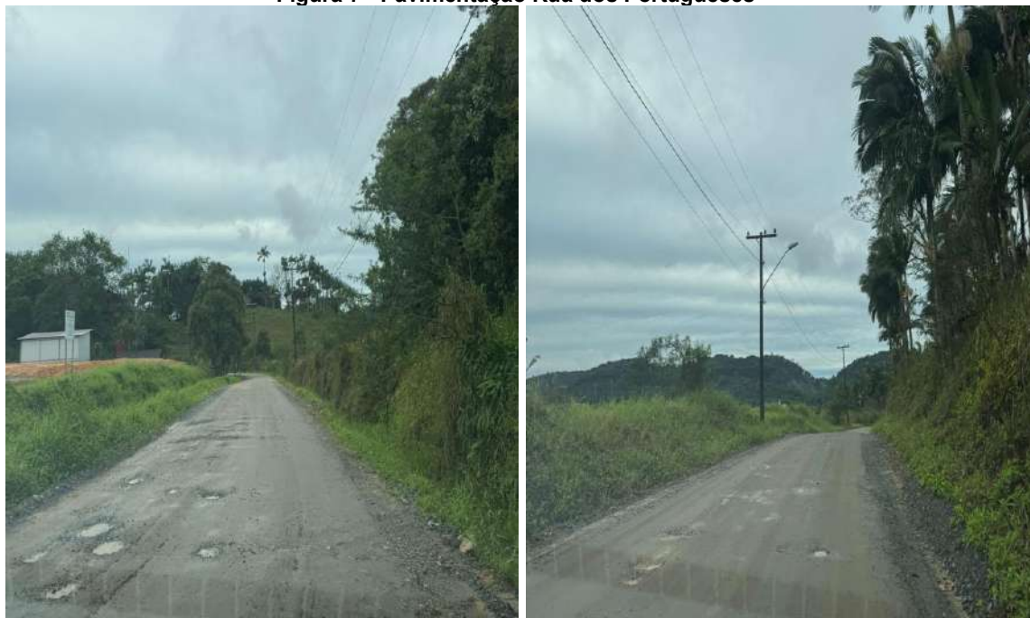
Figura 7 - Pavimentação Rua dos Portugueses
