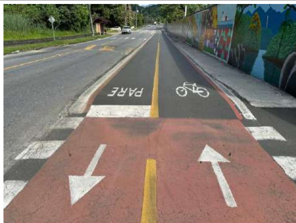
Sinalização das ciclofaixas na esquina com a Rua Amadus Jacob em bom estado de conservação
