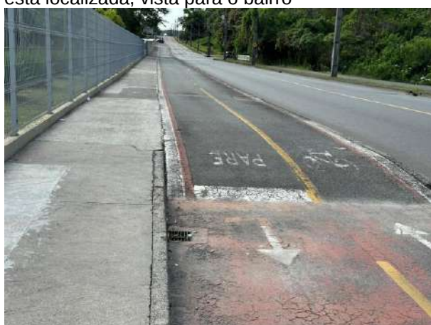
Ciclofaixas com sinalização apagada em frente ao acesso de pedestres e veículos da Krona
