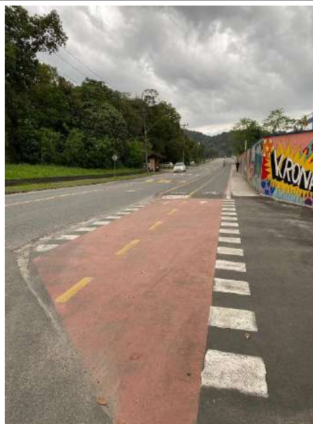
Ciclofaixa em bom estado de conservação
