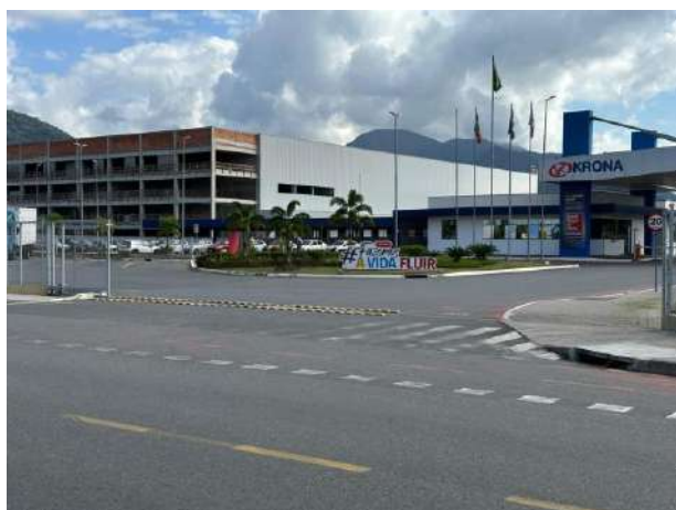
Vista da faixa de pedestres e ciclofaixas apagada com o novo centro de distribuição aos fundos
