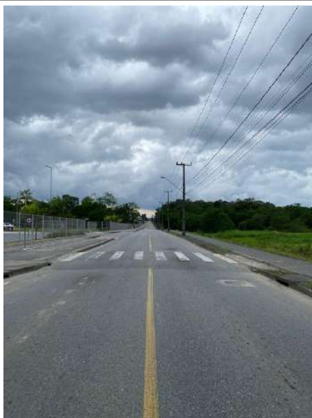
Lombada com faixa de pedestres
