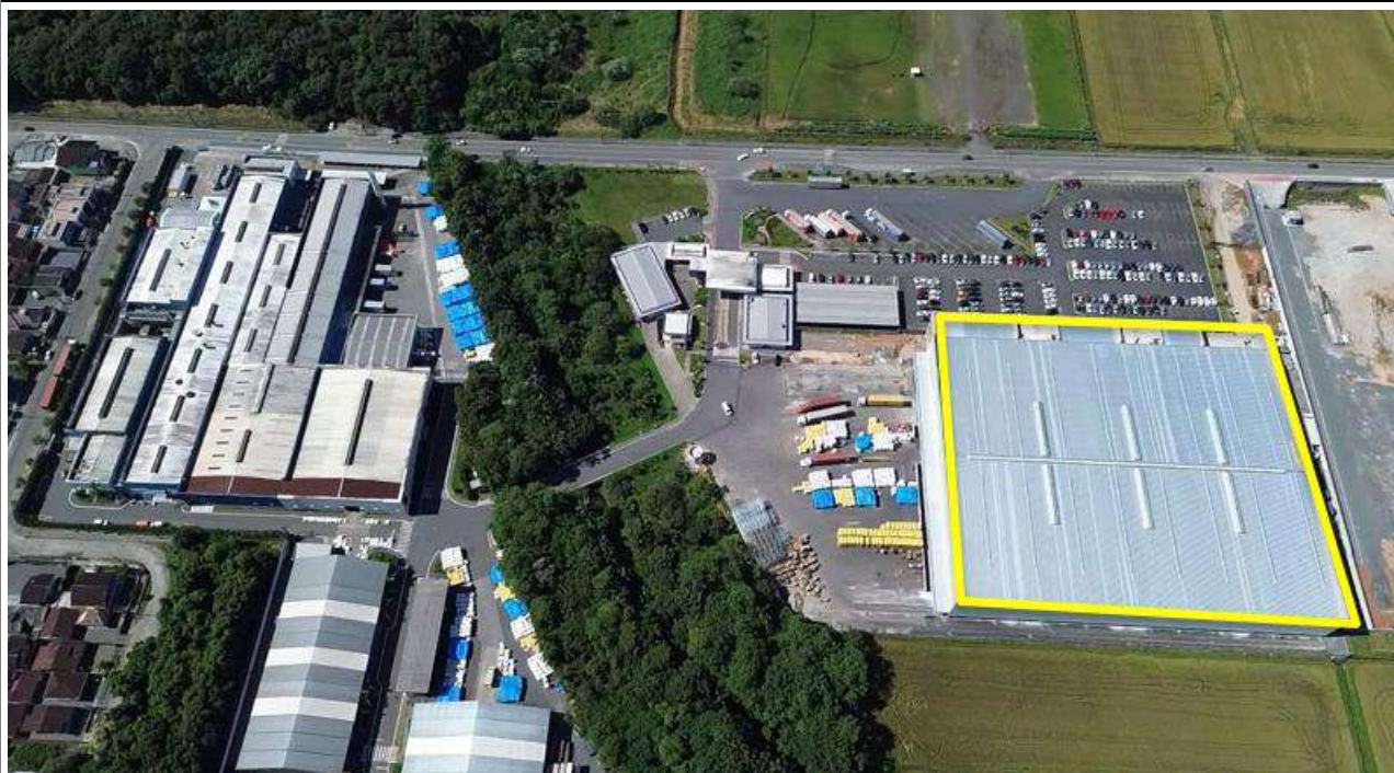
Galpão construído de 17.021,30 m²
