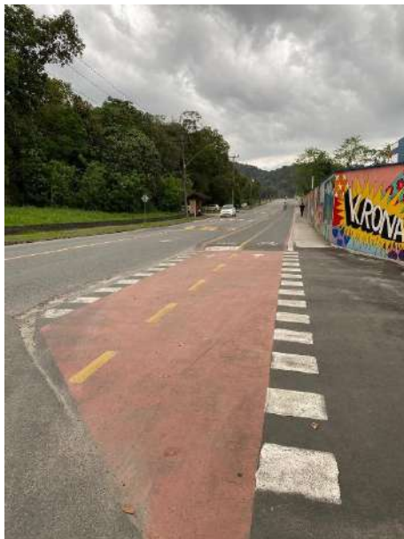
Ciclofaixa na Rua dos Suíços na esquina do empreendimento
