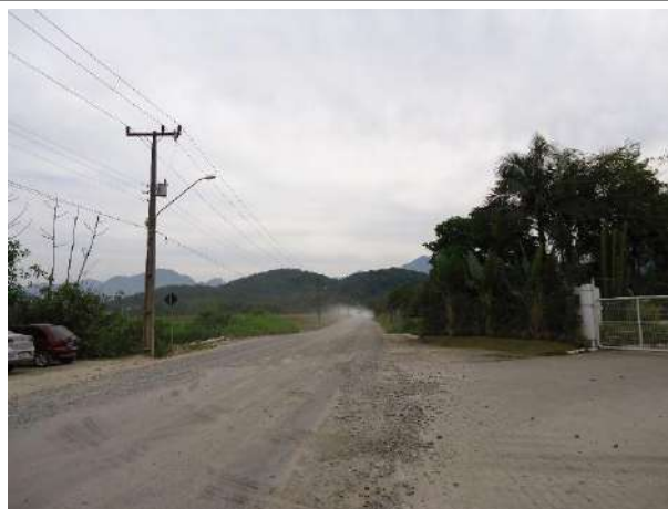
Rua dos Suíços em frente à Krona antes da pavimentação
