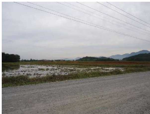
Ausência de pavimento na Rua dos Suíços em frente à Krona antes de 2016, sem calçada e ciclofaixa
