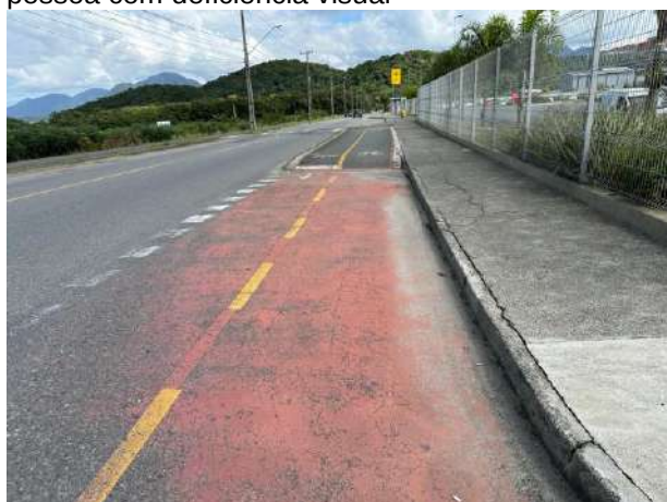
Ciclofaixa com pintura apagada em direção à Rodovia Rodolfo Jahn
