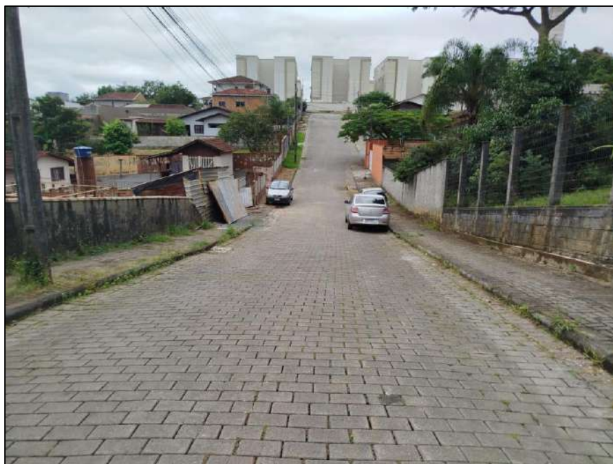
Figura 33 – Pavimentação da via em frente ao empreendimento.
