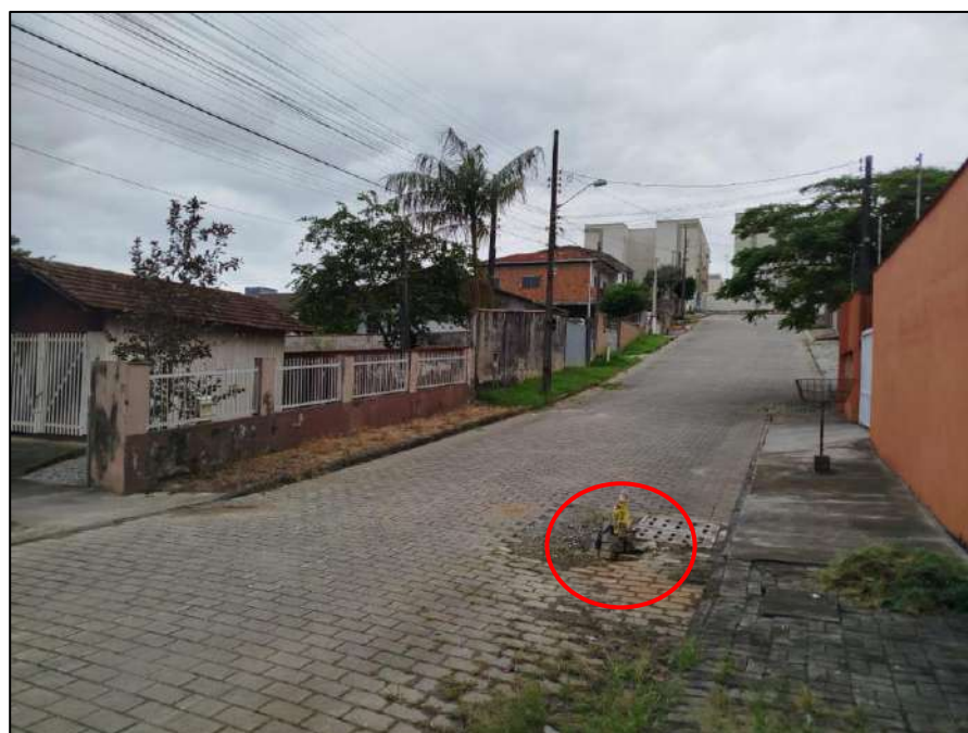
Figura 34 – Estado de conservação da via em um ponto próximo ao empreendimento.
