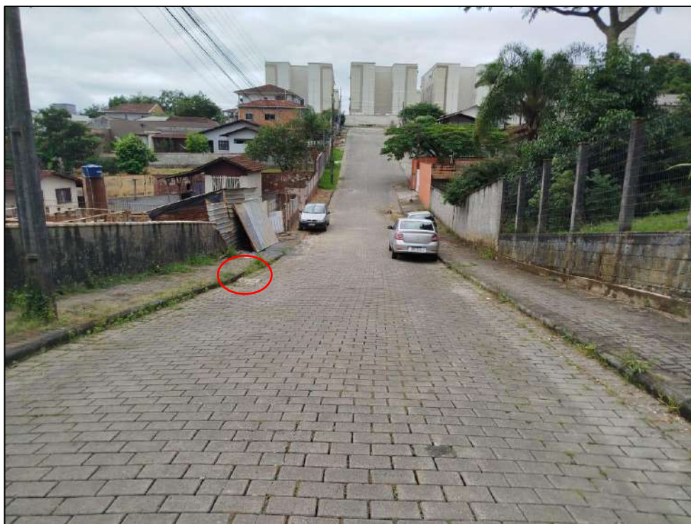
Figura 36 - Pontos de drenagem urbana próxima ao empreendimento.
