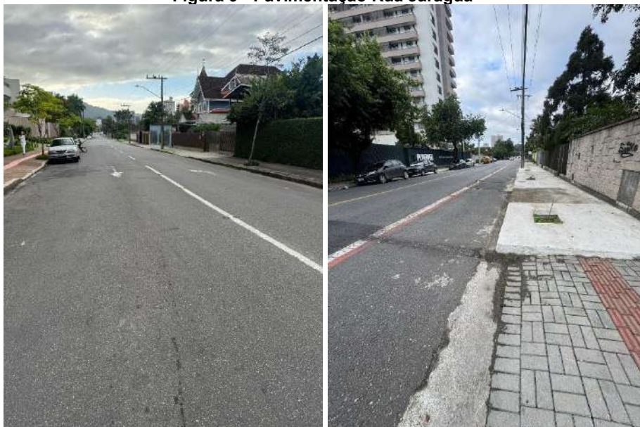
Figura 9 - Pavimentação Rua Jaraguá
