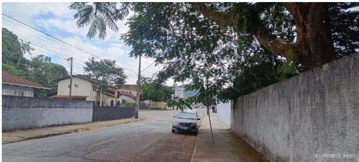
Figura 63: Aspecto calçada, Rua Herval do Oeste.
