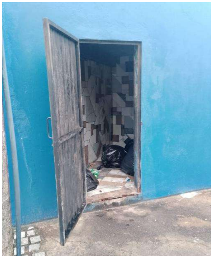
Figura 38: Lixeira para Armazenamento de Resíduo.
