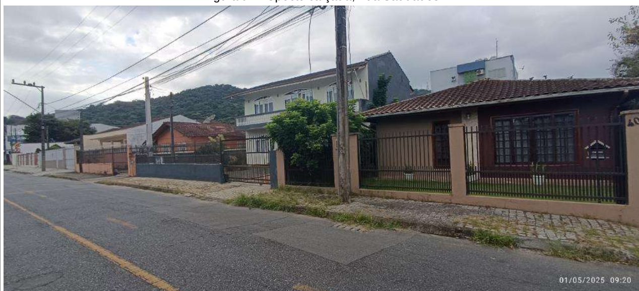
Figura 62: Aspecto calçada, Rua Guaramirim.
