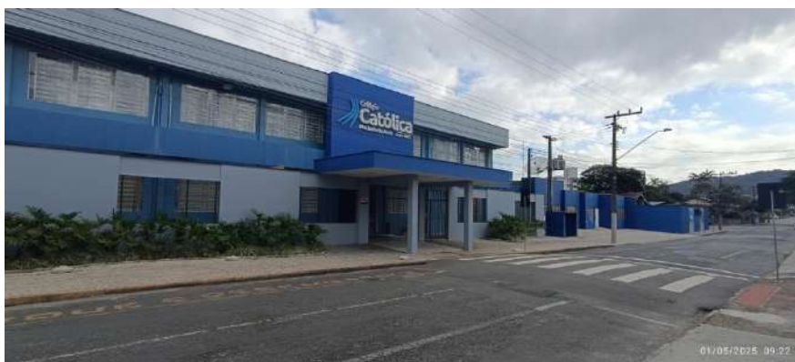
Figura 107: Fachada frontal, Unidade Educação Infantil.
