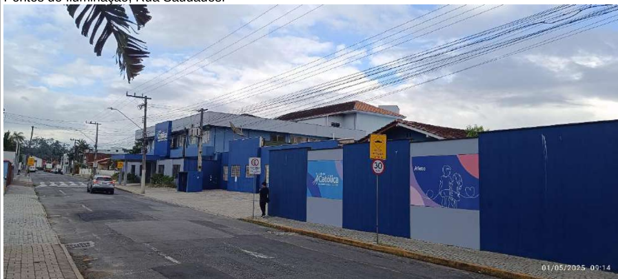
Pontos de Iluminação, Rua Herval do Oeste.
