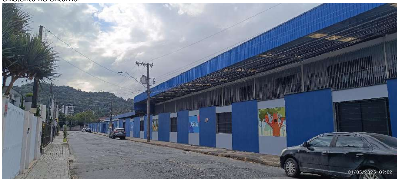
Pontos de Iluminação, Rua Saudades.
