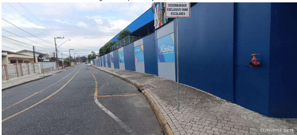
Figura 58: Aspecto calçada, Rua Guaramirim.
