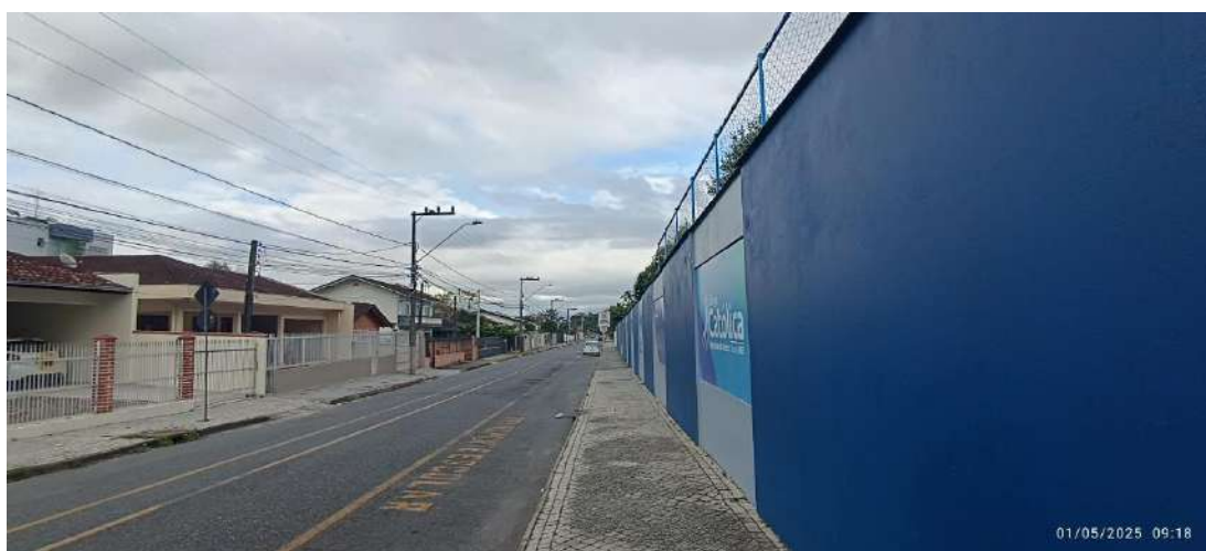
Figura 36: Iluminação Pública, Rua Guaramirim, sentido Dona Francisca.
