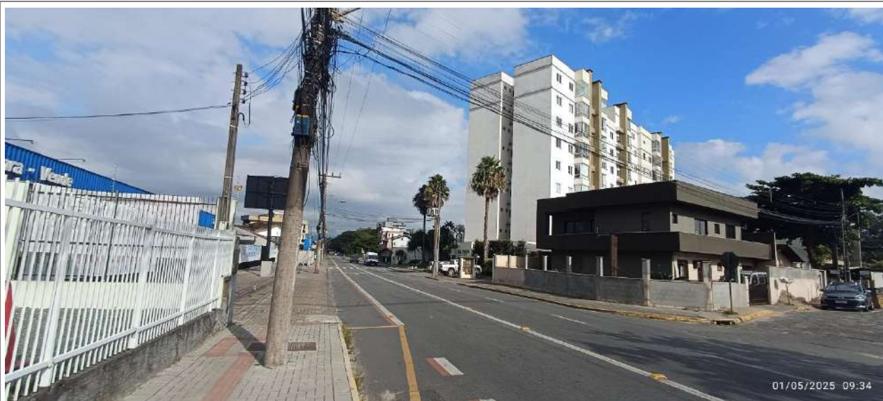
Figura 23: Aspecto das calçadas, Rua Carlos Benack.
