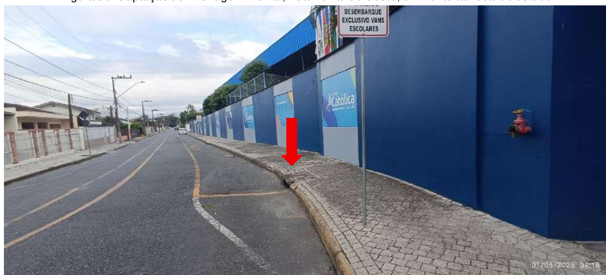
Figura 31: Captação de Drenagem Pluvial, Rua Guaramirim.
