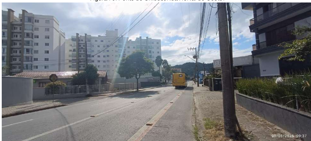
Figura 71: Faixa Exclusiva para Ônibus, Rua Carlos Benack.
