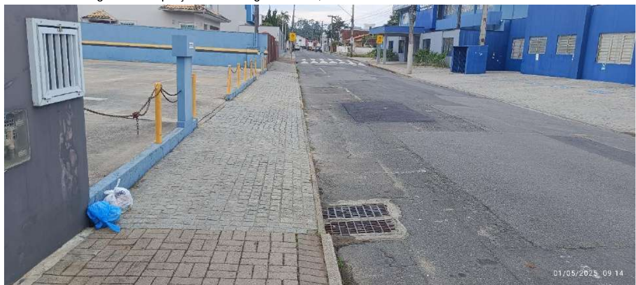
Figura 29: Captação de Drenagem Pluvial, Rua Herval do Oeste, em frente ao local de estudo.
