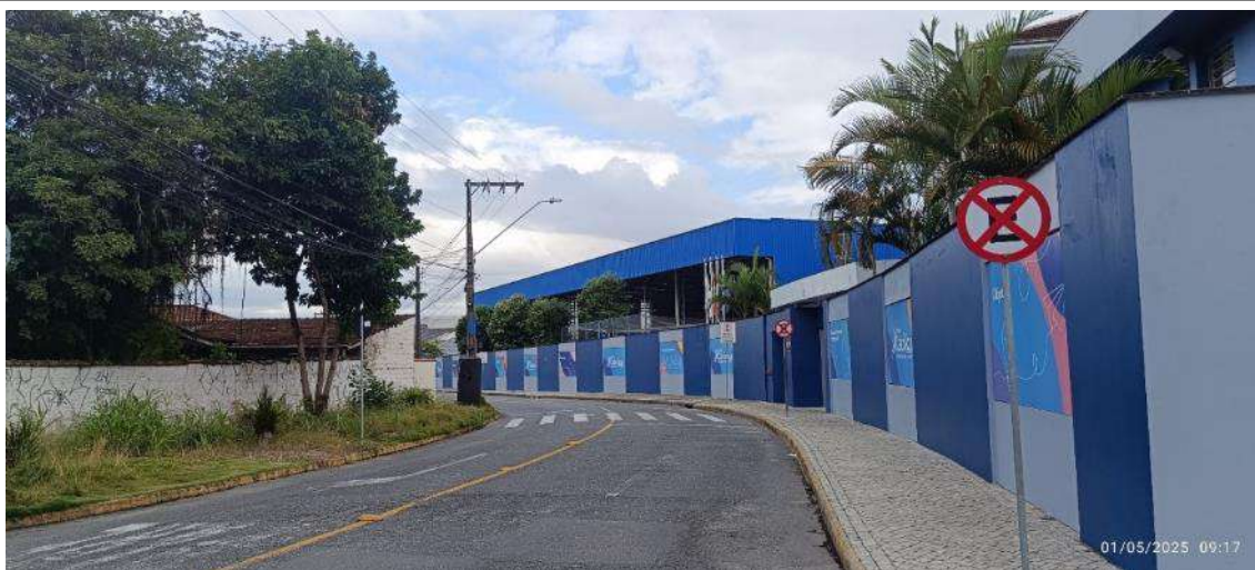
Figura 14: Rua Guaramirim, sentido Rua Dona Francisca.
