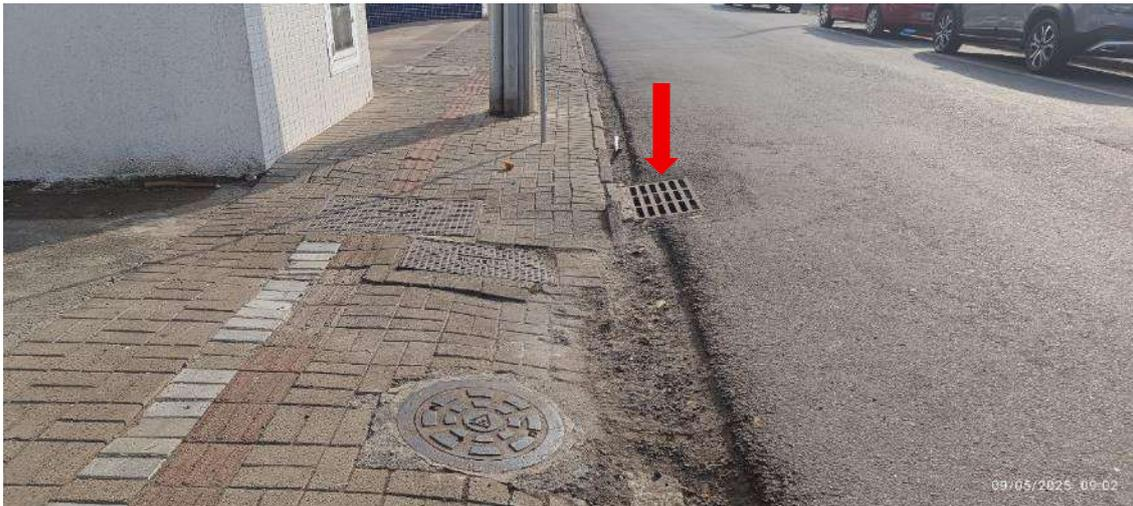
Figura 26: Captção de Drenagem Pluvial, Travessa São José.
