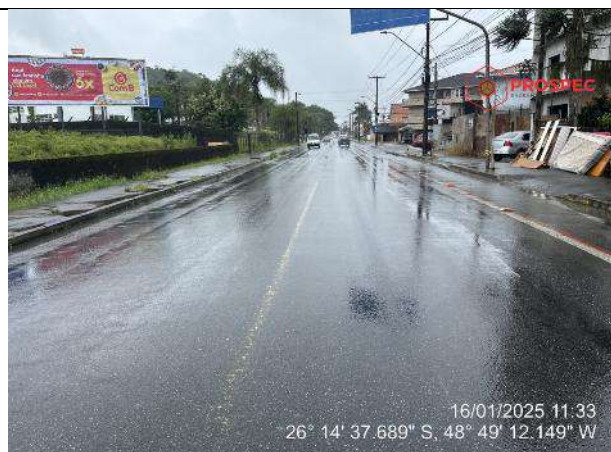
Figura 38: Condições da sinalização - Sinalização horizontal precária nas faixas de rolamento em frente ao imóvel.
