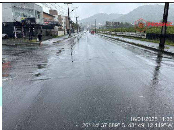
Figura 38: Condições da sinalização - Sinalização horizontal precária nas faixas de rolamento em frente ao imóvel.
