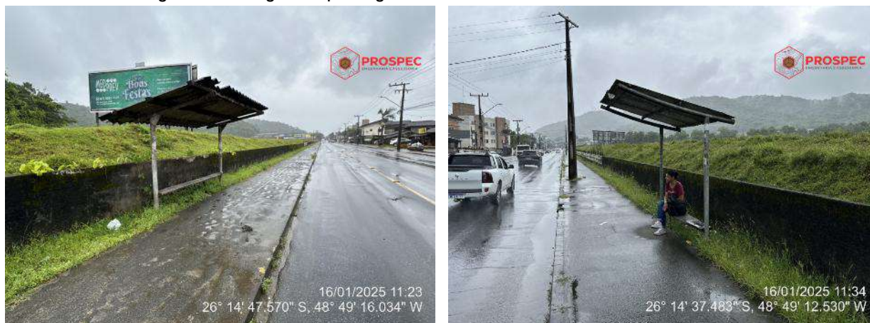
Figura 5 – Abrigos de passageiros em frente ao imóvel – Sentido Norte
