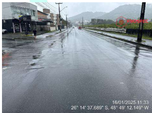
Figura 40: Condições da sinalização - Sinalização horiz. precária e/ou inexistente nas faixas de rolamento em frente ao imóvel.
