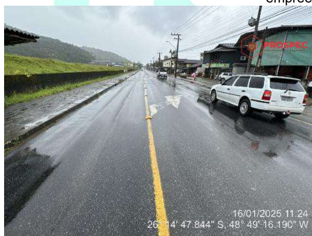
Figura 36: Condições da sinalização - sinalização horizontal no eixo da via.
