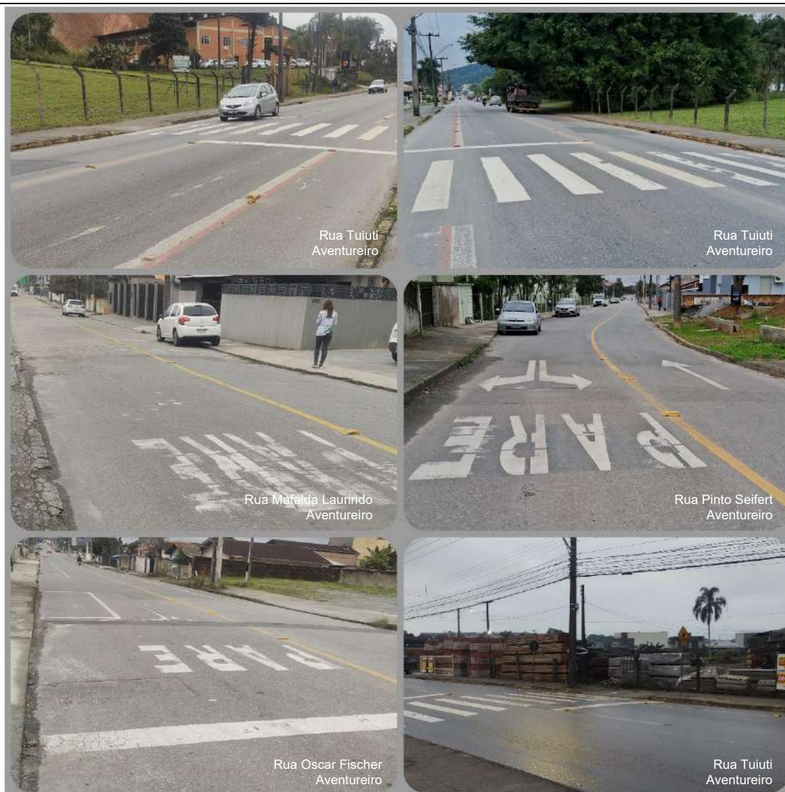
Figura 10: Vias principais de acesso ao empreendimento.
