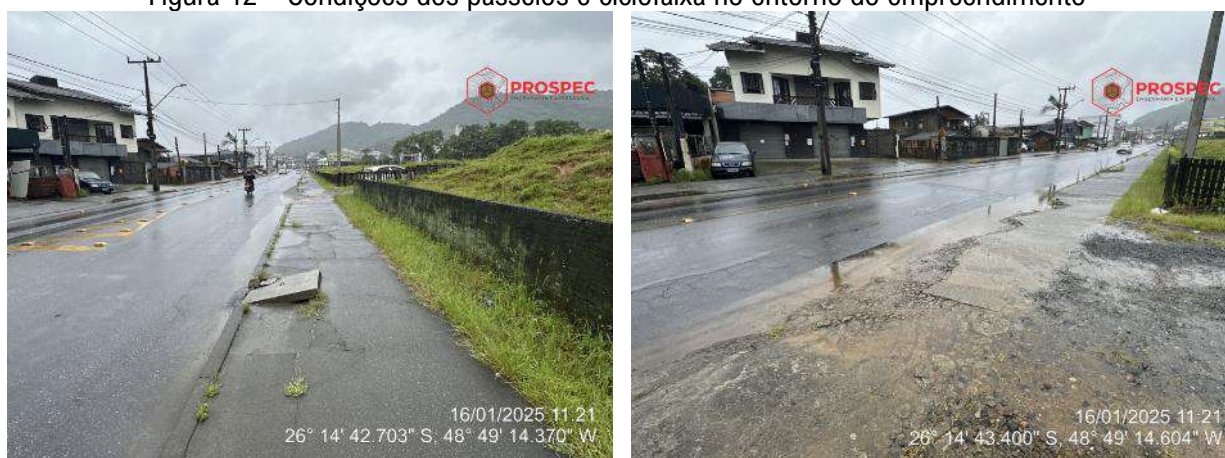
Figura 12 – Condições dos passeios e ciclofaixa no entorno do empreendimento
