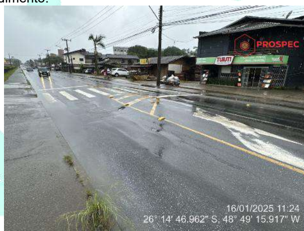
Figura 36: Condições da sinalização - sinalização horizontal no eixo da via.
