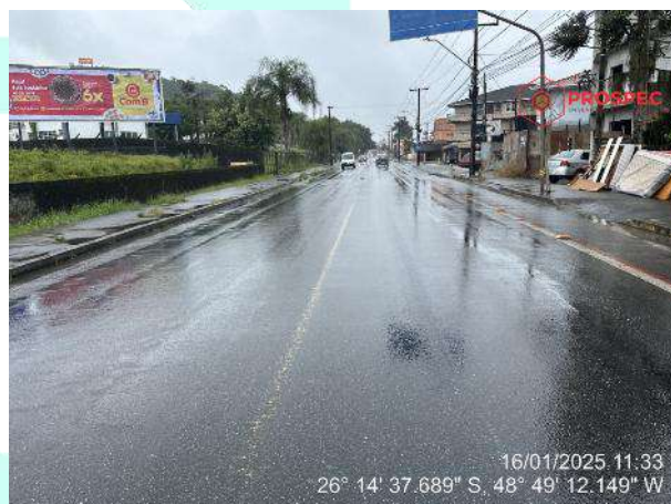
Figura 40: Condições da sinalização - Sinalização horiz. precária e/ou inexistente nas faixas de rolamento em frente ao imóvel.
