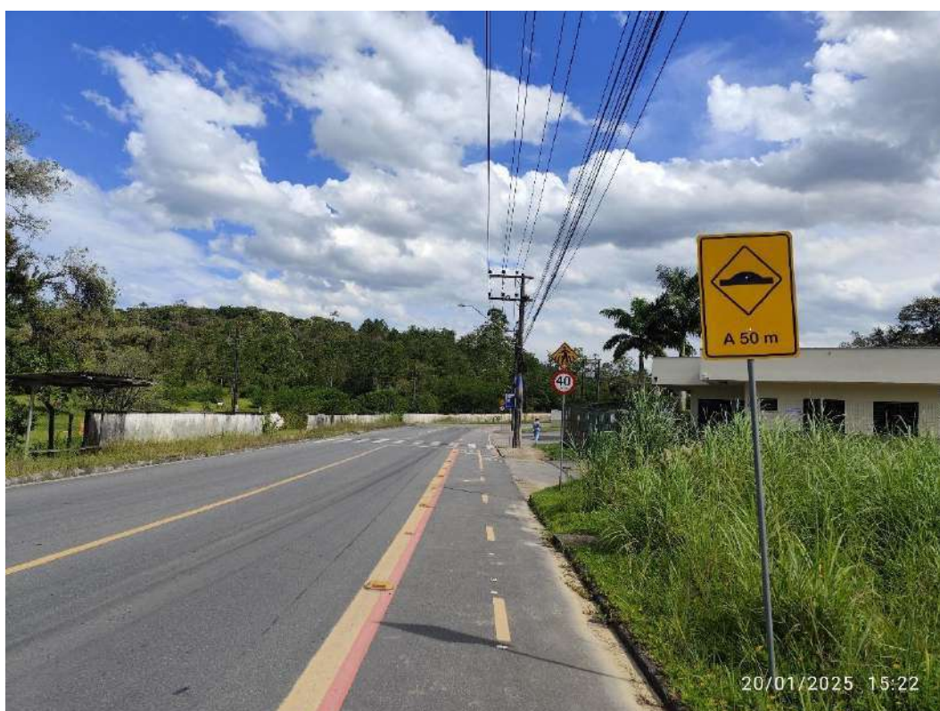
Figura 58: Sinalização vertical e horizontal na rua Santa Catarina, sentido sul.
