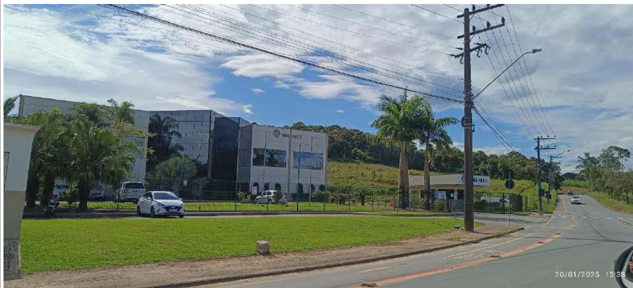
Figura 32: Iluminação Pública, em frente ao local de estudo.
