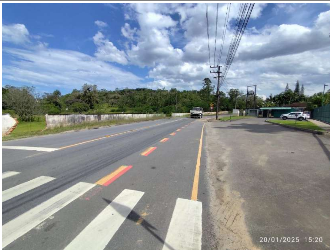
Figura 48: Rua Santa Catarina em frente ao imóvel, vista para sentido sul.
