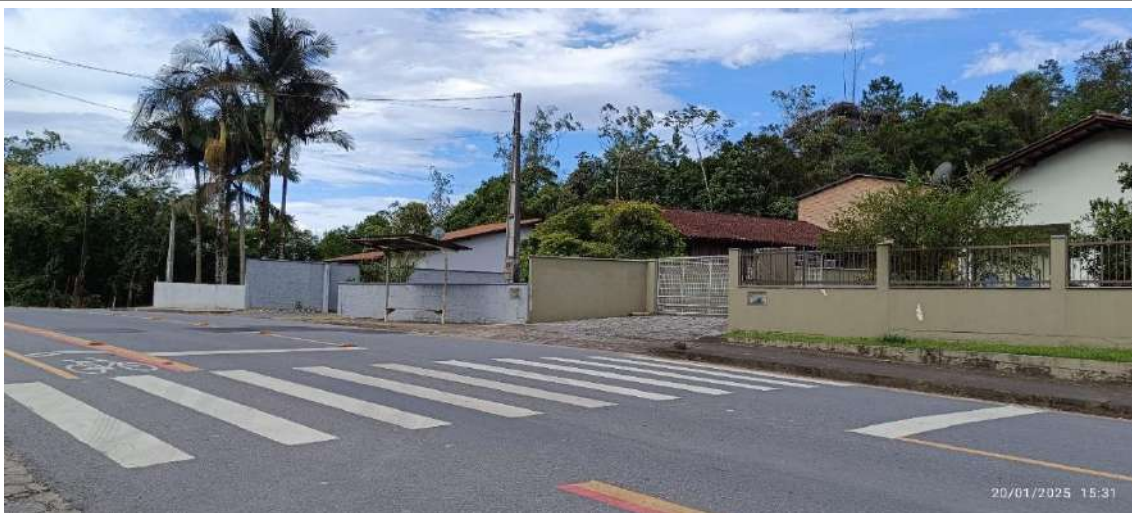
Figura 72: Aspecto calçadas pavimentadas em frente às residências.
