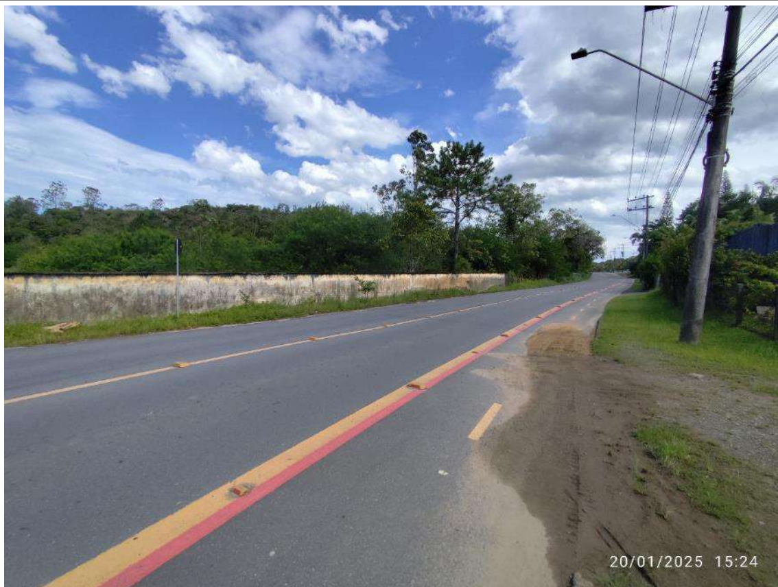
Figura 21: Rua Santa Catarina, sentido Eixo Sul.
