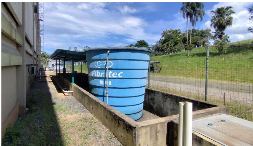
Figura 37: Cisterna de armazenamento de água subterrânea.
