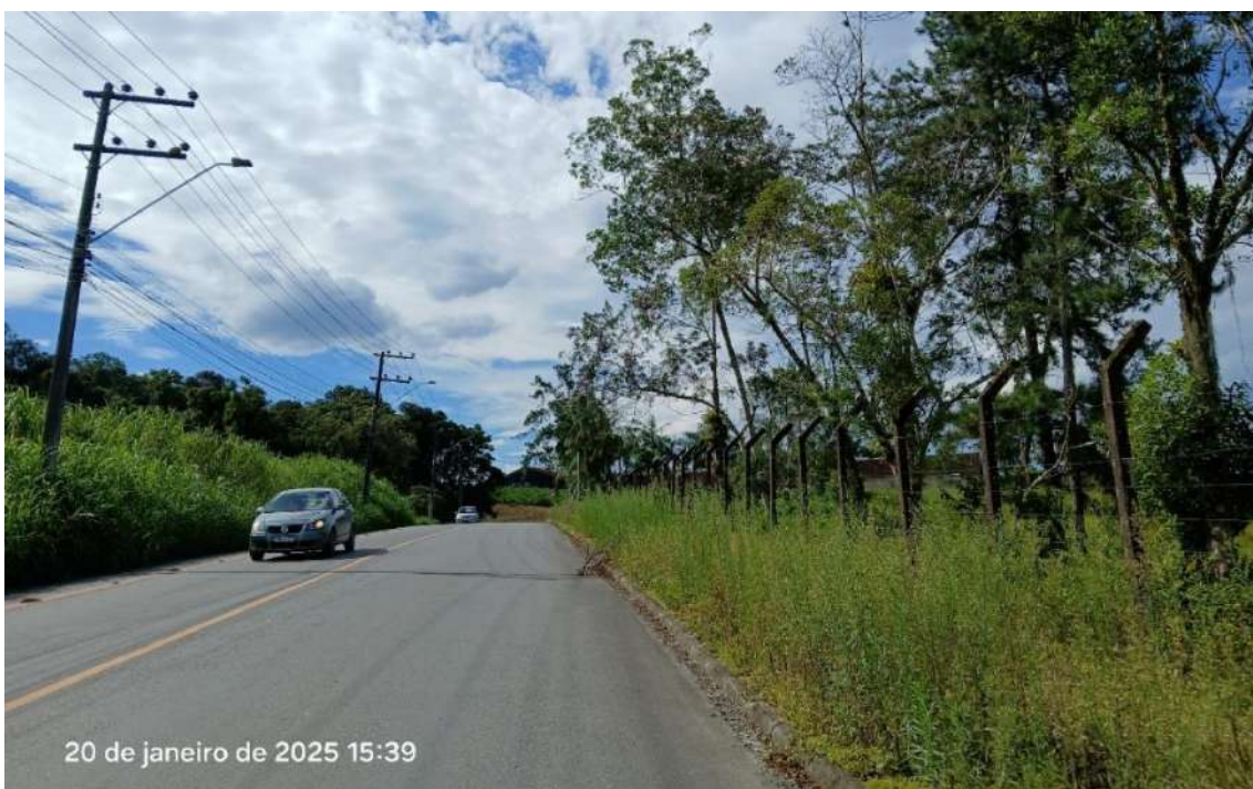
Figura 73: Aspecto calçada, sentido Bairro Santa Catarina.
