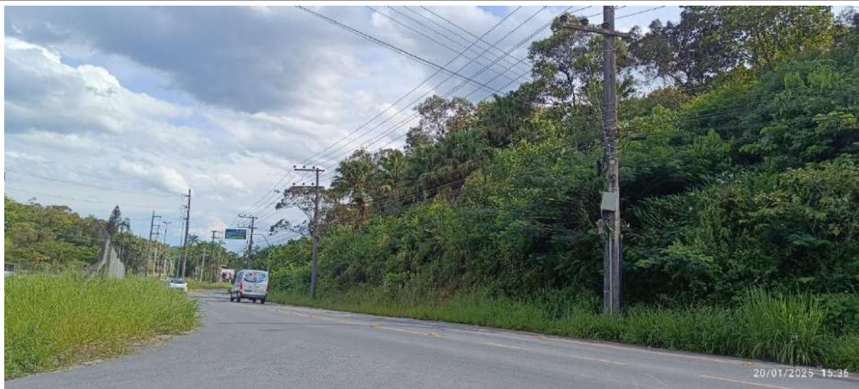
Figura 36: Iluminação Pública, vista para sentido Eixo Sul.
