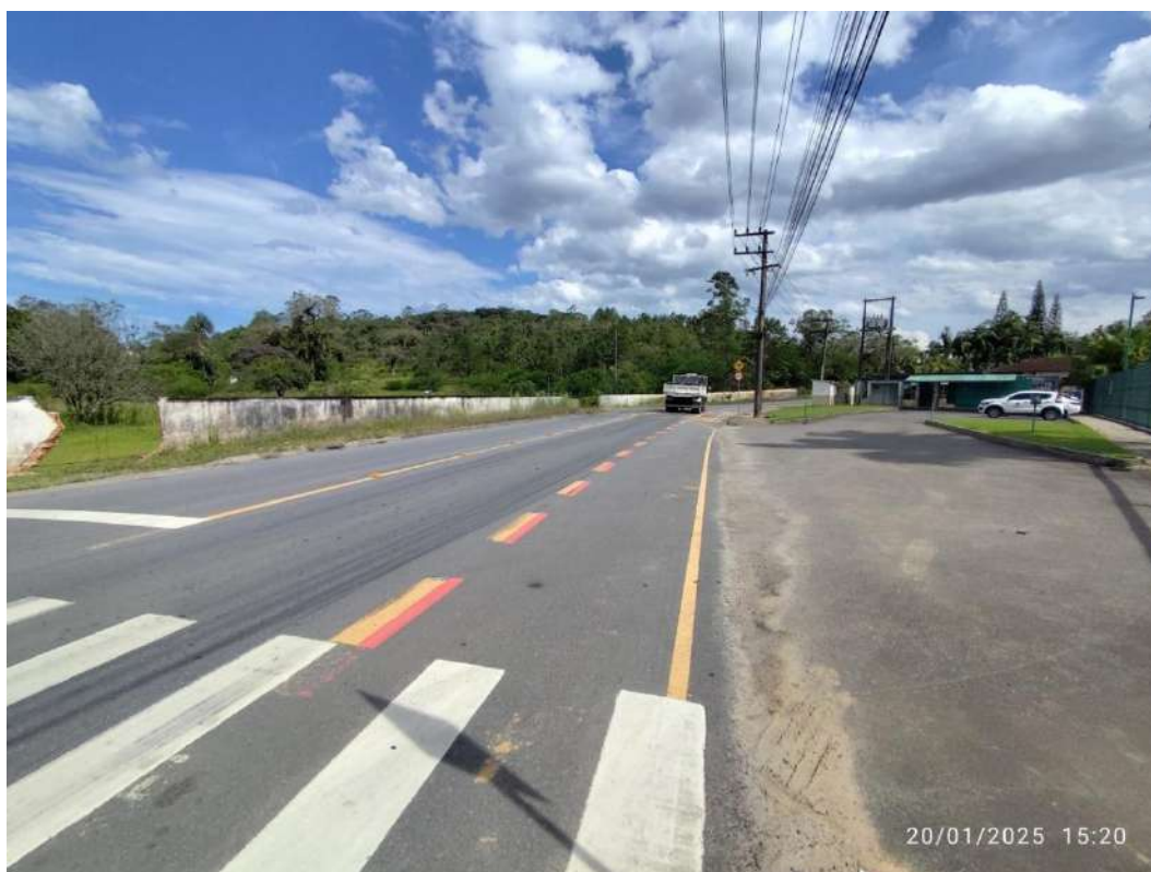
Figura 20: Rua Santa Catarina, em frente ao local de estudo, sentido Eixo Sul.
