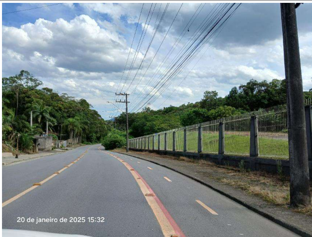
Figura 27: Aspecto da calçada, sentido Eixo Sul.
