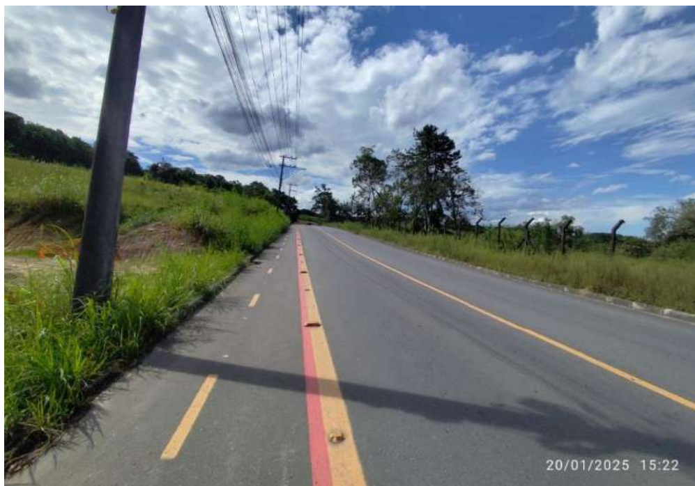
Figura 25: Aspecto da calçada, sentido Bairro Santa Catarina.
