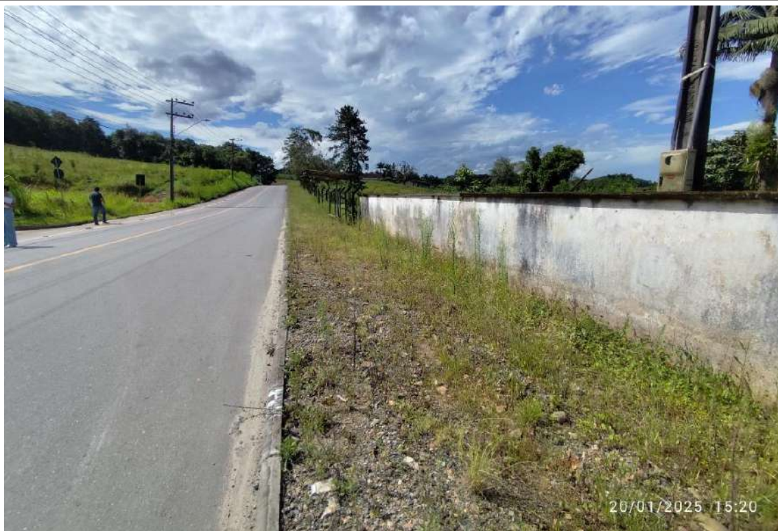
Figura 70: Aspecto calçada de imóvel em frente ao empreendimento, sentido Bairro Santa Catarina.
