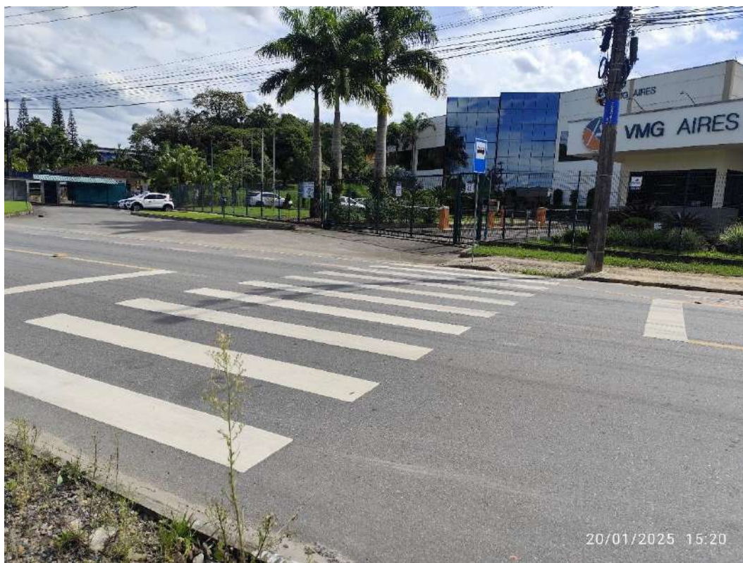
Figura 57: Sinalização horizontal para travessia de pedestres na rua Santa Catarina, em frente ao imóvel em estudo.
