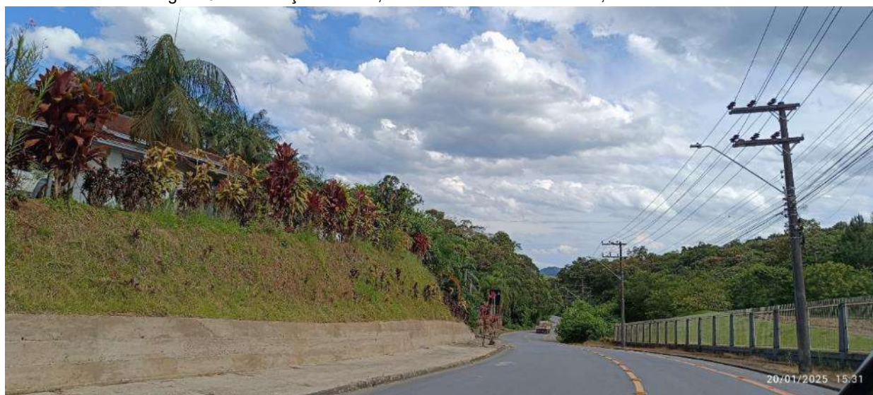
Figura 35: Iluminação Pública, vista para sentido Eixo Sul.
