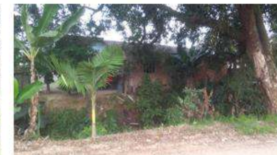
Fonte: WALM, 2020 Edificações construídas na beira do Rio Itaum Mirim (identificação 13-11-31-1-1470)
