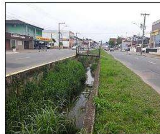
Assoreamento no rio Itaum-Açu (ponto 8)
