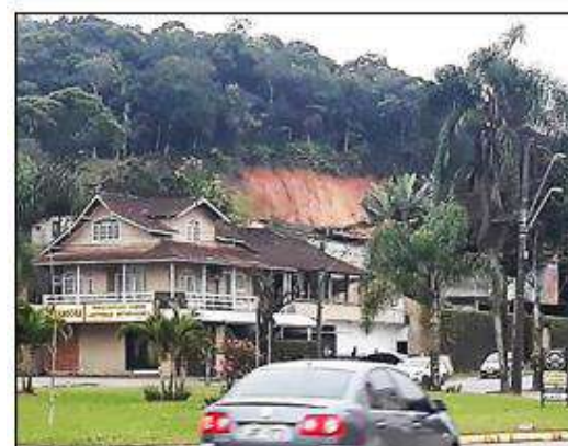
Escorregamento em corte recente de talude (ponto 4)
