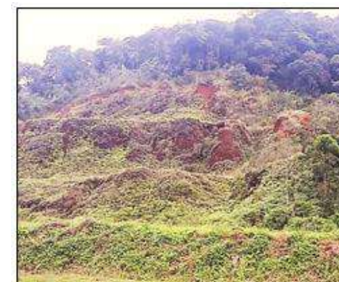
Escorregamentos em corte antigo de talude (ponto 5)
