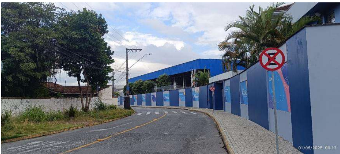
Figura 15: Rua Guaramirim, sentido Rua Dona Francisca.
