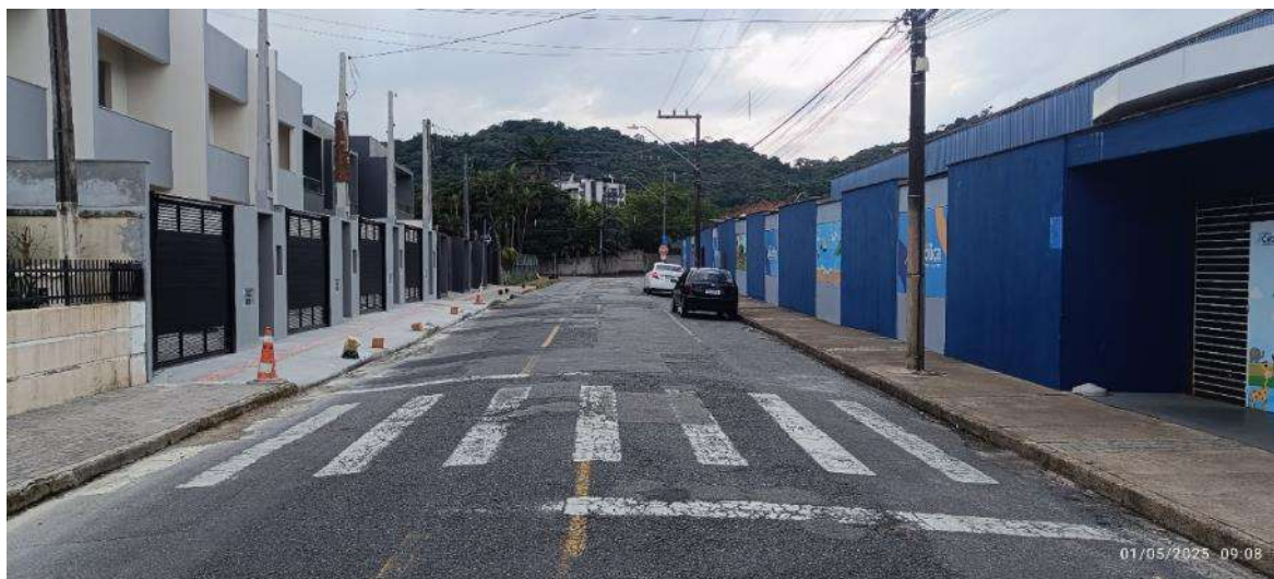
Figura 11: Rua Saudades, sentido Rua Herval do Oeste.
