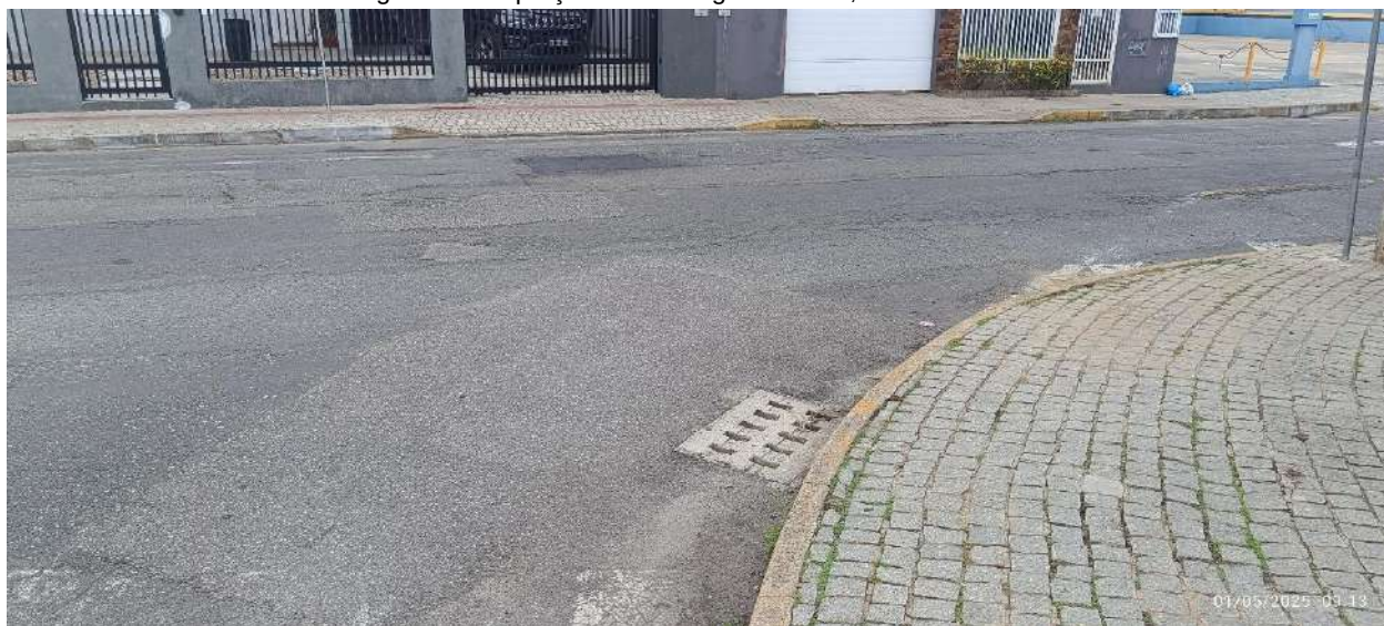
Figura 29: Captação de Drenagem Pluvial, Rua Saudades com Rua Herval do Oeste.
