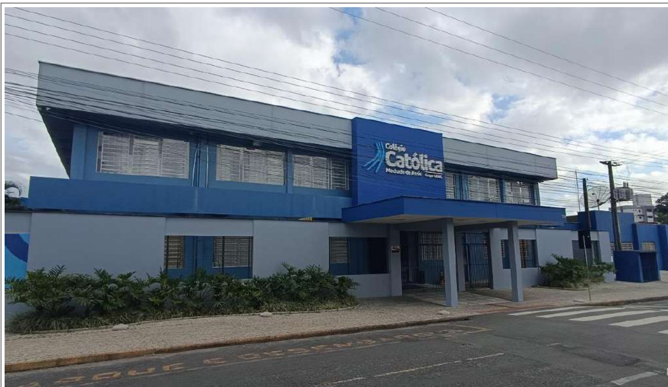
Figura 40: Fachada e entrada principal do colégio na Rua Herval do Oeste (Educação Infantil e Fundamental).
