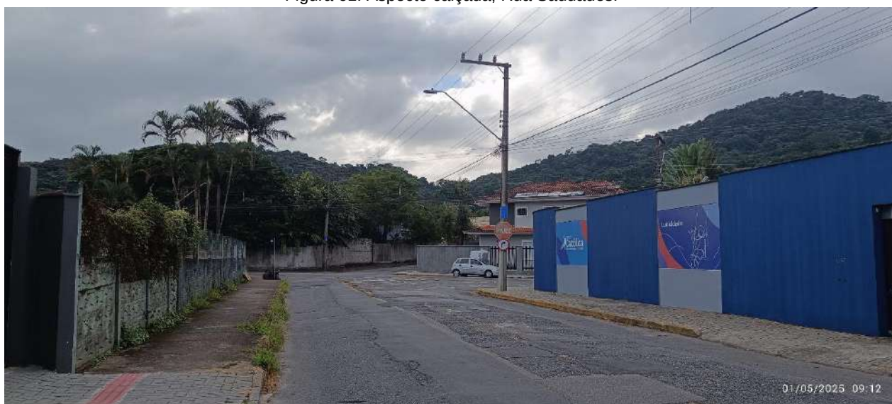
Figura 62: Aspecto calçada, Rua Saudades.
