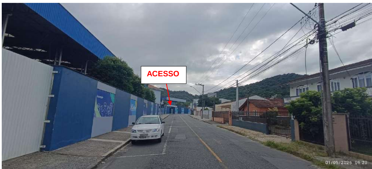
Figura 43: Fachada do colégio na Rua Guaramirim.
