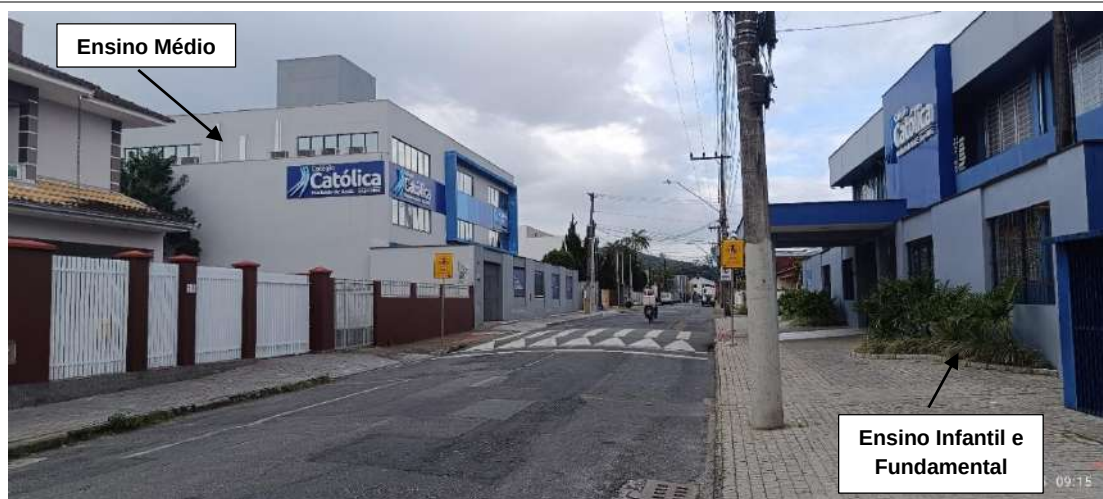
Figura 1: Prédios do Colégio Católica Machado de Assis.
