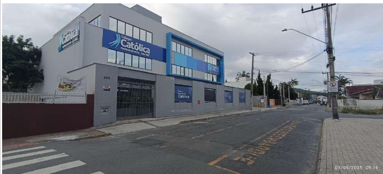
Figura 21: Aspecto da calçada, Unidade de Ensino Médio, lado esquerdo.
