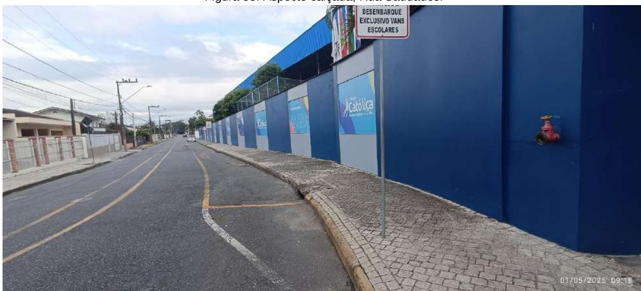
Figura 59: Aspecto calçada, Rua Guaramirim.
