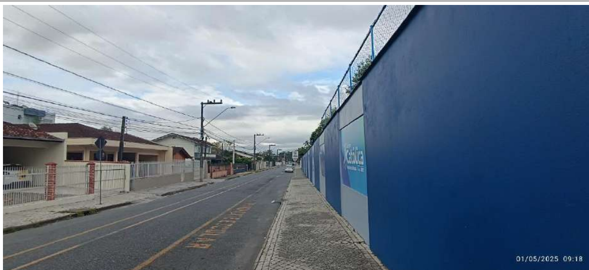
Figura 37: Iluminação Pública, Rua Guaramirim, sentido Dona Francisca.
