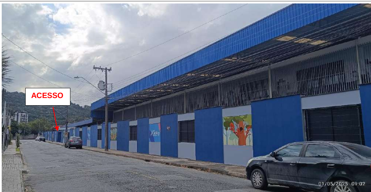
Figura 42: Fachada do colégio na Rua Saudades.
