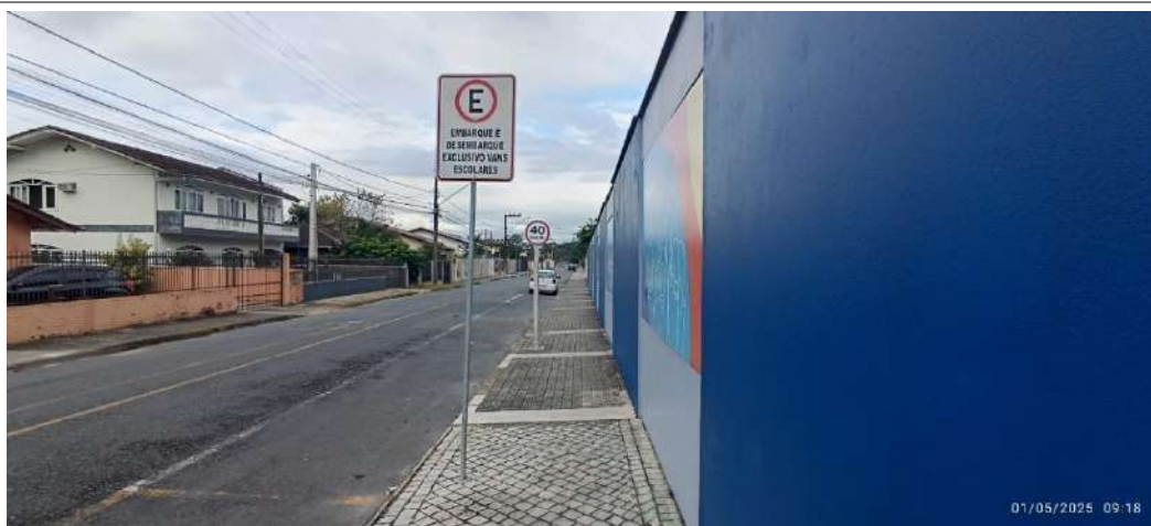
Figura 20: Aspecto da calçada, Rua Guaramirim, sentido Rua Dona Francisca.
