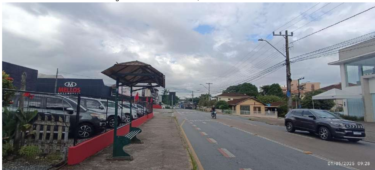
Figura 71: Ponto de Ônibus, Rua Herval do Oeste.
