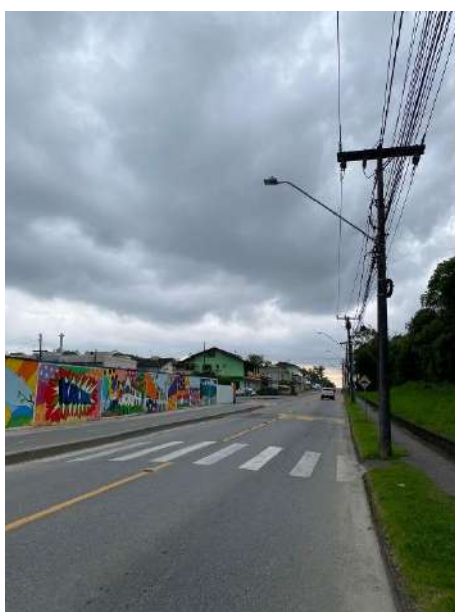
Faixa para travessia de pedestres, lombada física e sinalização de lombada
