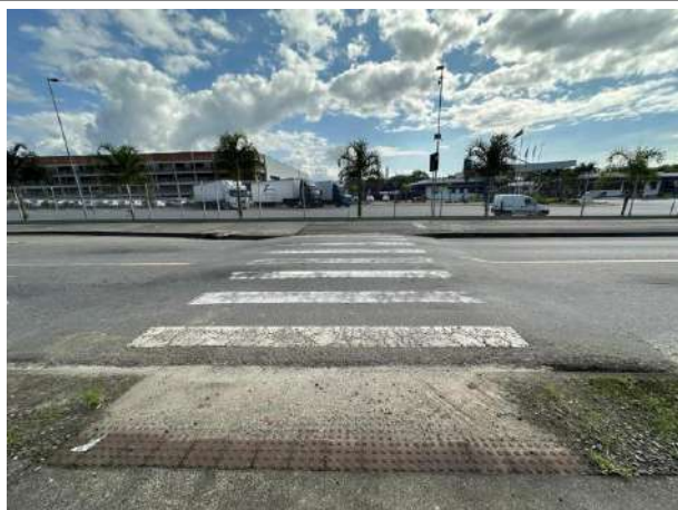
Calçada do outro lado da Krona com guia para pessoa com deficiência visual
