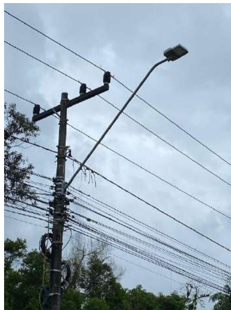
Rede de iluminação pública do lado oposto do empreendimento
