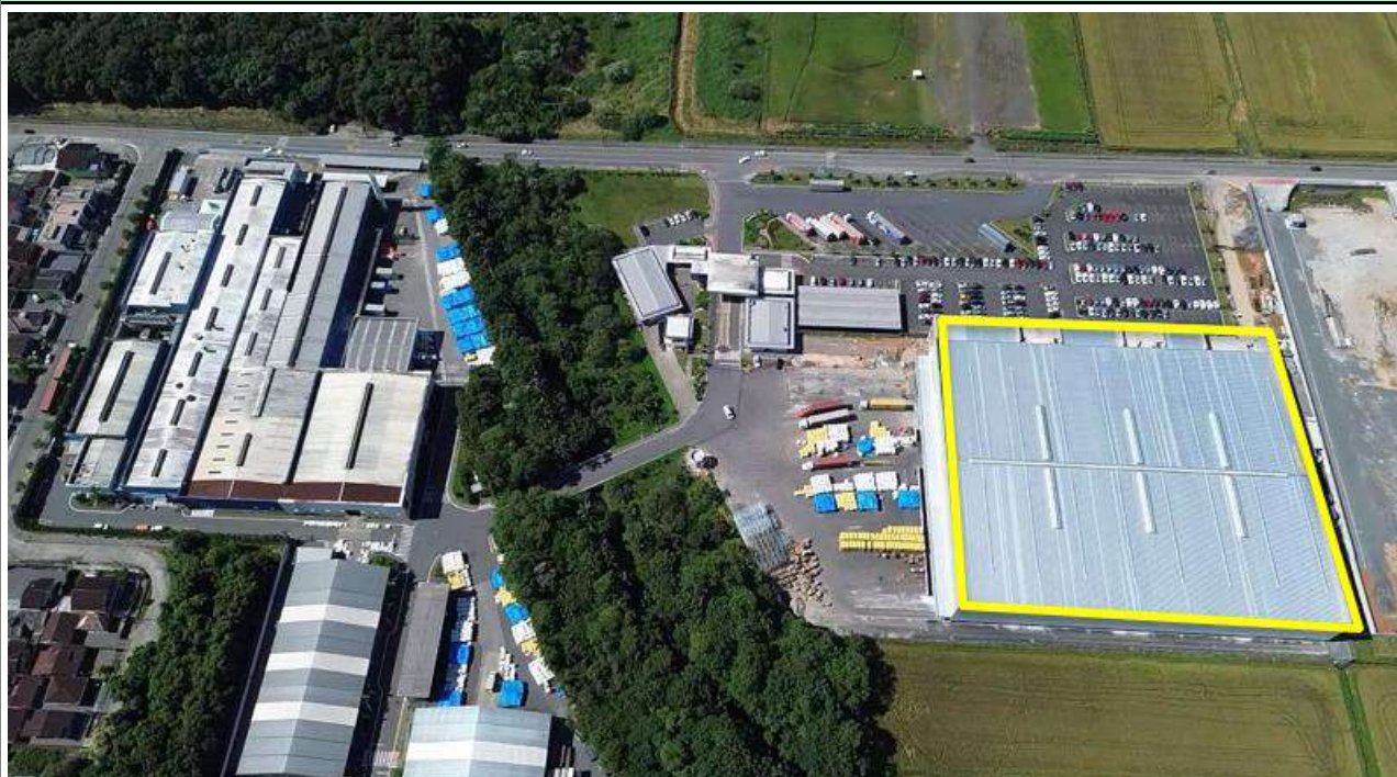
Galpão construído de 17.021,30 m 2
