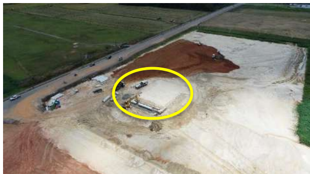
Bacia de retenção de águas pluviais – etapa 1
