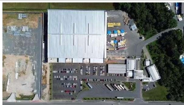
Empreendimento em obras ao lado da área diretamente afetada
