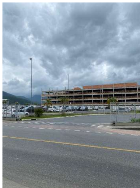
Iluminação do estacionamento da Krona
