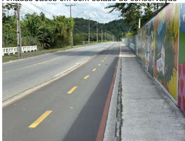
Calçada e ciclofaixas no mesmo lado onde a Krona está localizada, vista para a Rodovia Rodolfo Jahn
