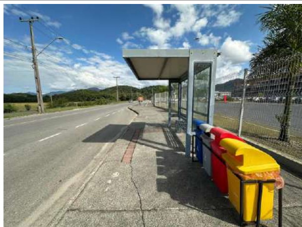
Abrigo de ônibus do mesmo lado da Krona, com guia no piso para pessoa com deficiência visual
