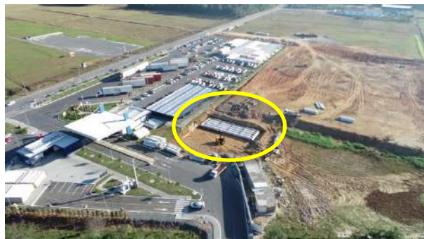
Bacia de retenção de águas pluviais – etapa 2
