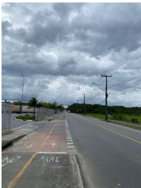
Faixa de pedestres e ciclofaixa com pintura apagada na entrada de caminhões do empreendimento
