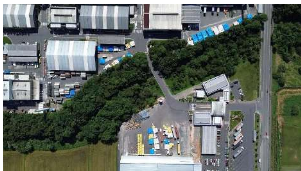
Área de Preservação Permanente na área de influência direta
