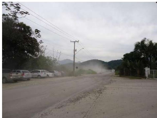
Poeira constante na Rua dos Suíços em frente à Krona antes da pavimentação
