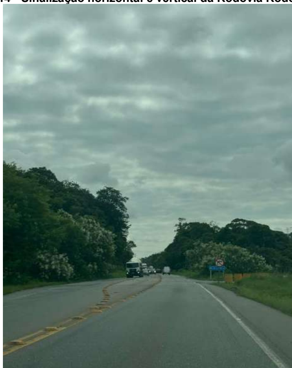
Figura 14 - Sinalização horizontal e vertical da Rodovia Rodolfo Jahn
