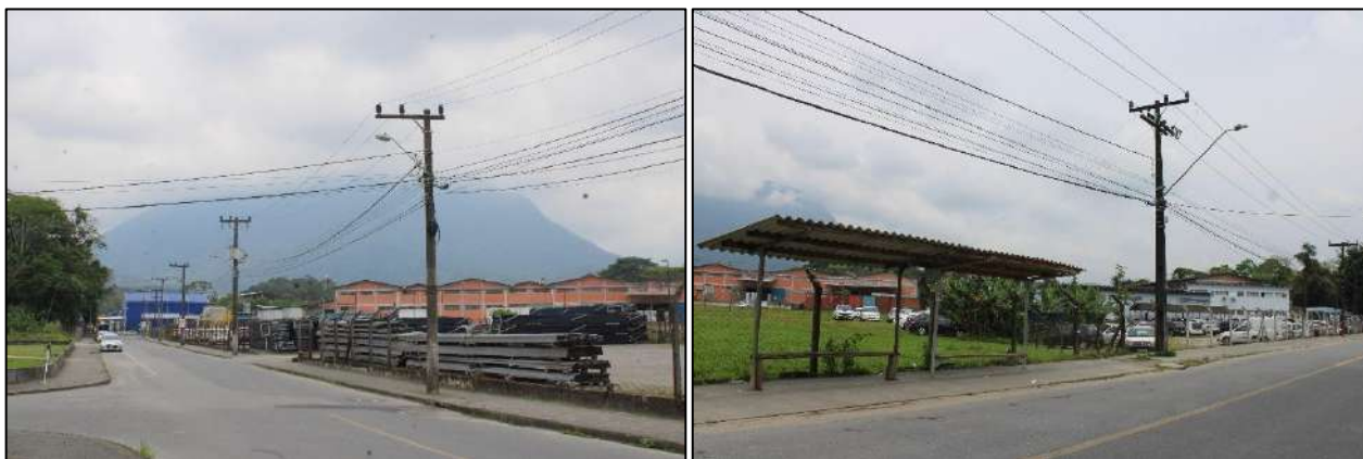
Figura 31 - Iluminação pública na via de acesso principal ao empreendimento. Fonte: Bioeco, 2024.
