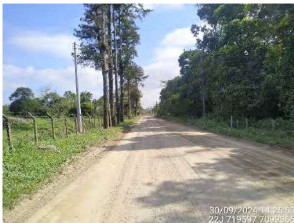
Figura 9 – Trecho da Estrada Timbé não pavimentado e situado na AID.
