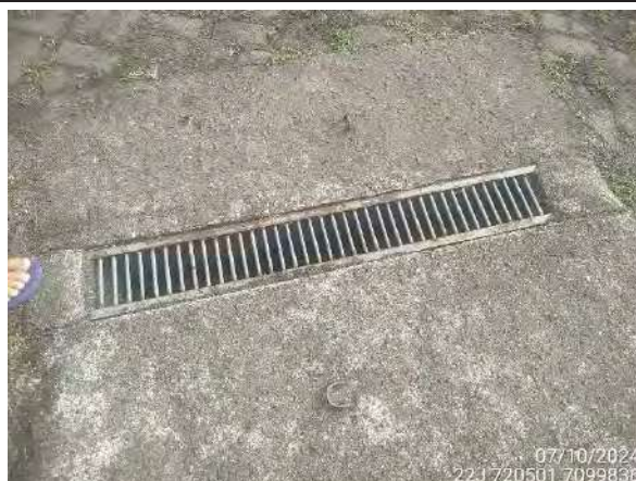
Figura 4: Grelha presente na área interno do empreendimento
