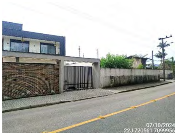
Figura 43 – Presença de calçada localizada posteriormente ao Centro Náutico Porto do Sol e anexa à Estrada Cubatão Grande.
