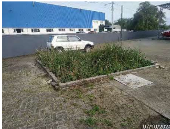
Figura 29 - Vista parcial do sistema de tratamento de efluentes do Centro Náutico Porto do Sol.
