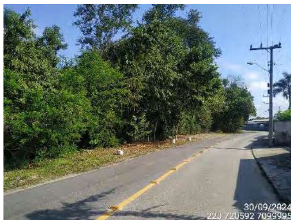
Figura 47 - Sinalização horizontal na Estrada Cubatão Grande.
