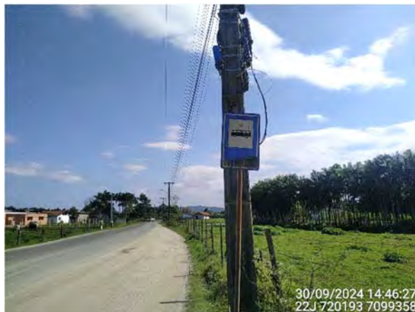
Figura 49 - Sinalização vertical na Estrada Cubatão Grande.
