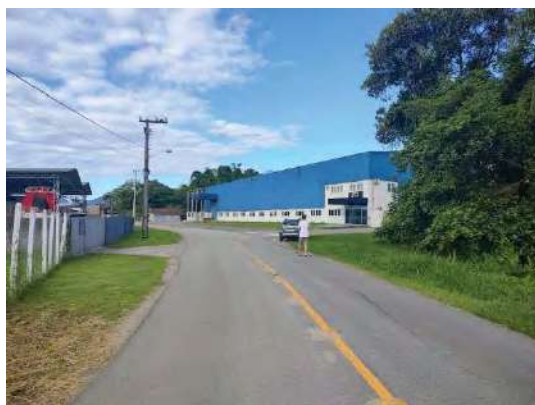
Fig. 04: Rua Cubatão Grande – sentido Norte
