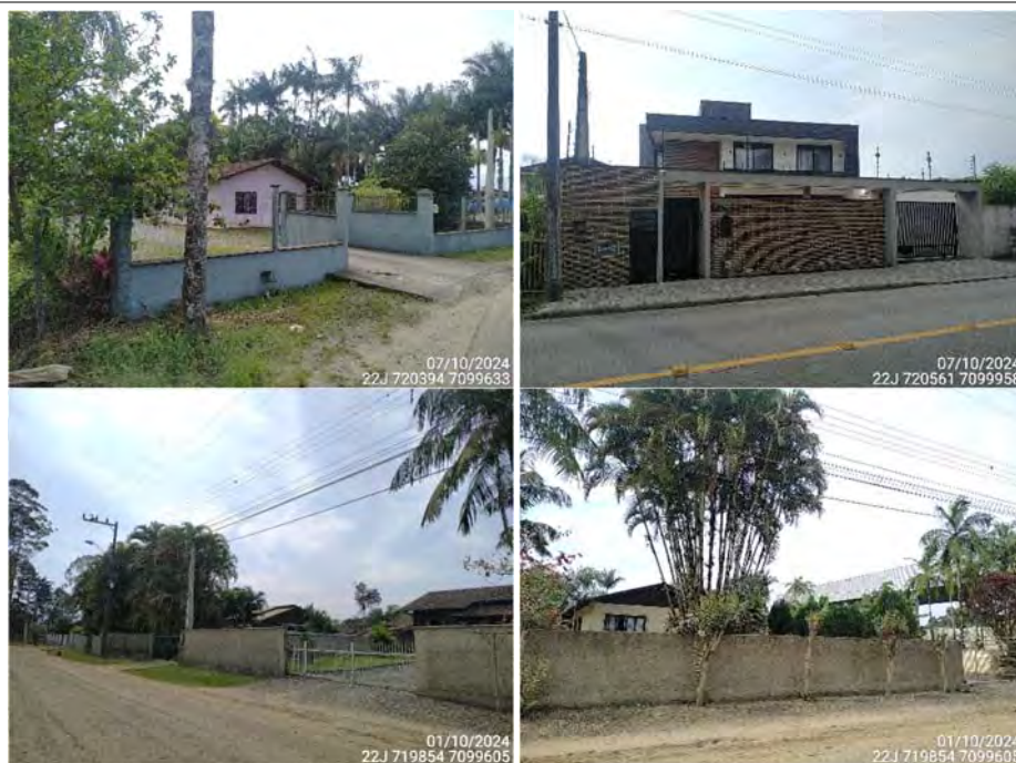
Figura 4 - Residências situadas na AID.
