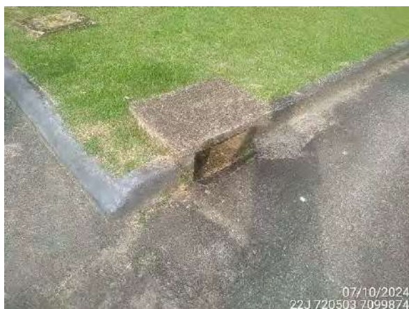
Figura 15 – Boca de lobo na área interna do empreendimento
