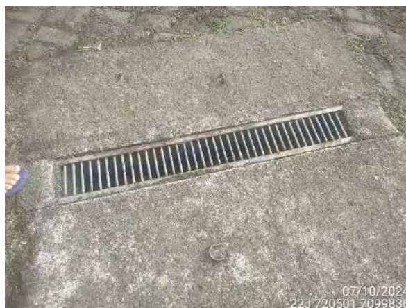
Figura 16 – Grelha presente na área interna do empreendimento
