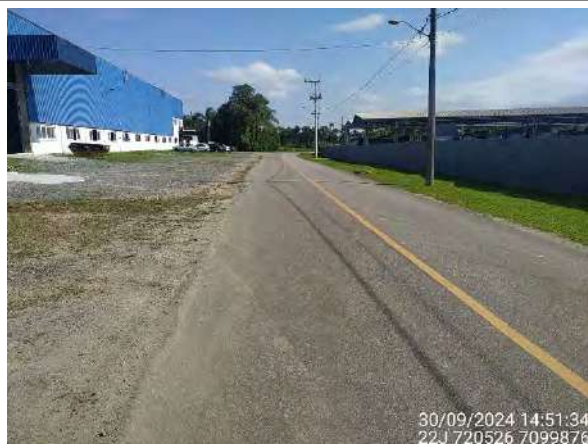
Figura 12 – Trecho da Estrada Cubatão Grande com pavimentação asfáltica e situado adjacente ao empreendimento.
