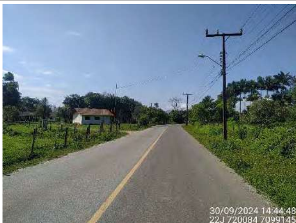
Figura 11 – Trecho da Estrada Cubatão Grande com pavimentação asfáltica e situado na AID.
