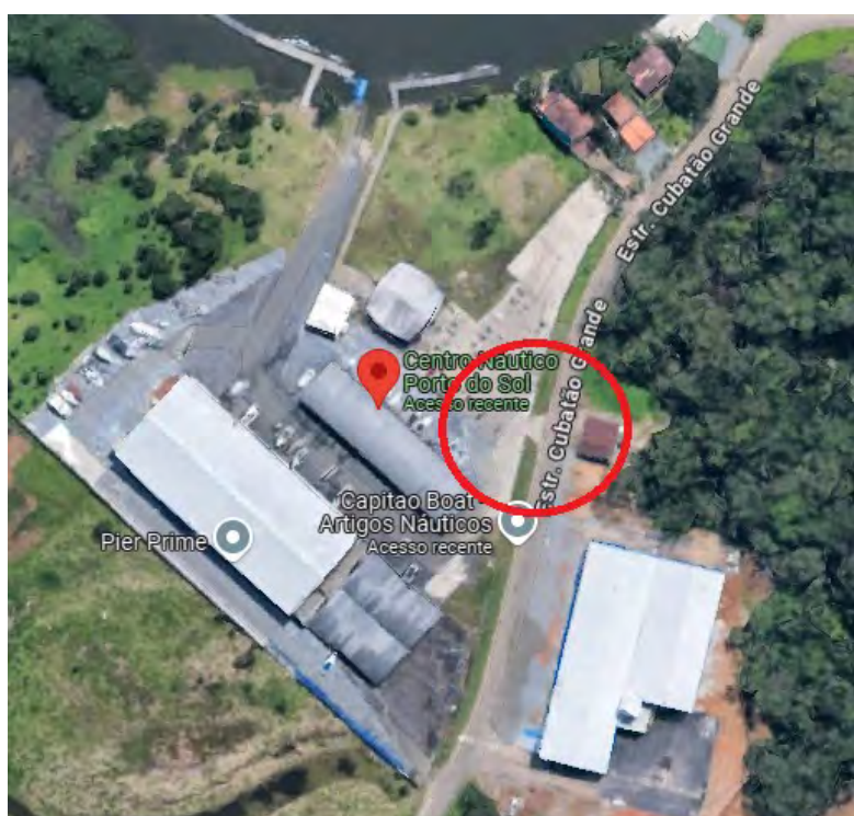
Figura 4 - Ponto 2: Estrada Cubatão Grande nº 1897.
