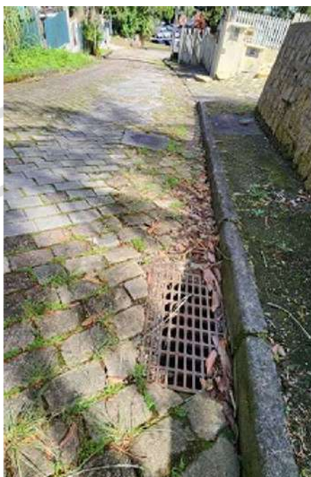
Figura 1 – Boca de lobo existente na Rua Otto Eduardo Lepper, nas proximidades do imóvel.
