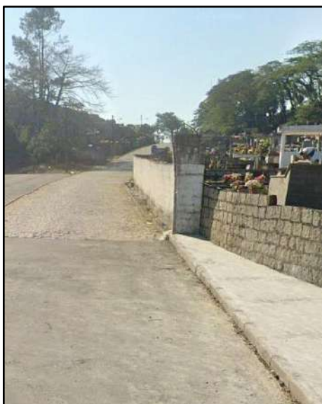
Figura 19: Sarjeta na Rua Iguapé. Fonte: Arquivo pessoal, 2025.
