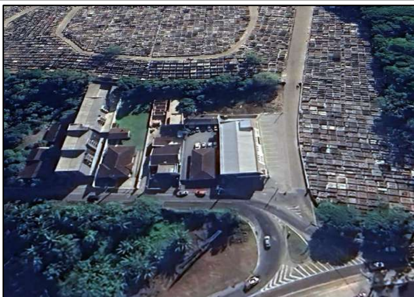
Figura 52: Elevação das edificações pelo Google Earth. Fonte: Google Earth, 2025.
