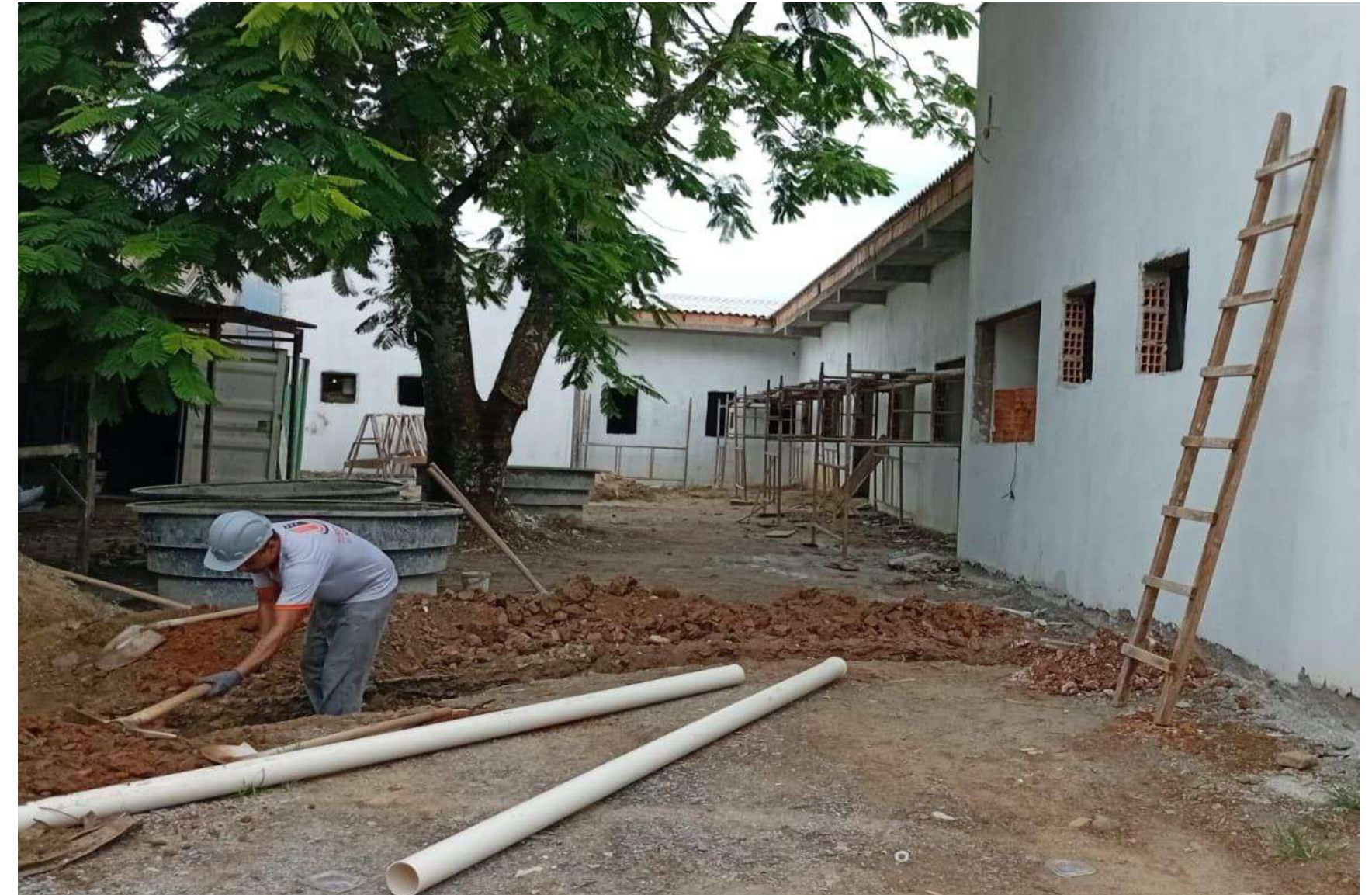
UBSF Parque Joinville EXECUÇÃO 3º QUAD. 47,96%
