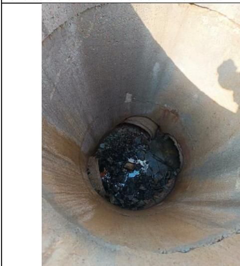
**Figura 03** – PV receptor dos PVs demonstrados nas figuras 01 e 02, profundidade de 2,20m com dois tubos de 60cm de entrada e um tubo de 80cm de saída.
