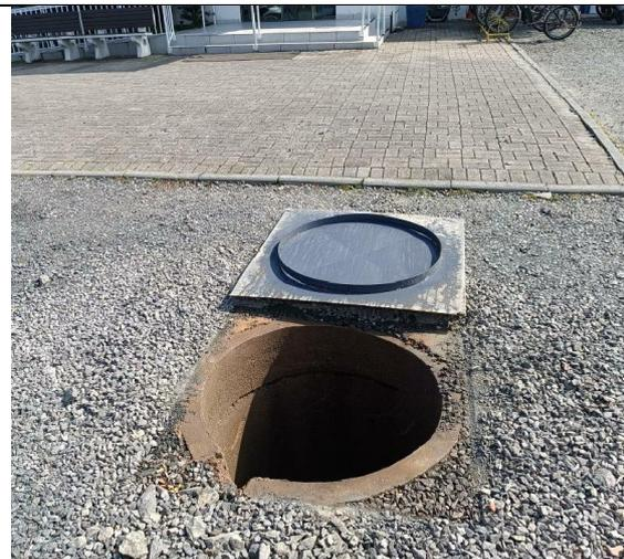
**Figura 02** - PV Drenagem em Pátio: 1,75 m de profundidade com um tubo de 60cm de entrada e um tubo de 60cm de saída.
