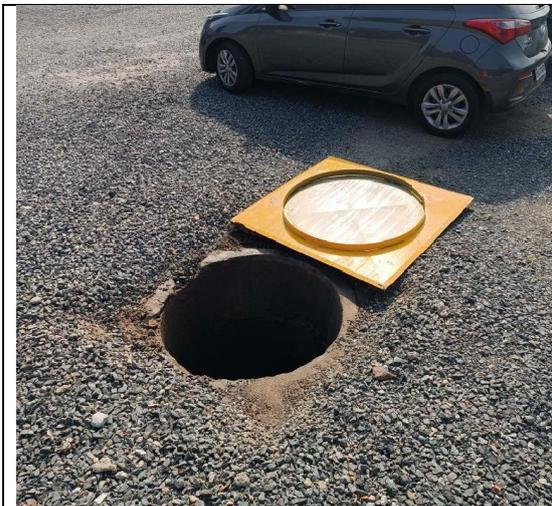
**Figura 01** - PV Drenagem em Pátio: 1,20 m de profundidade com um tubo de 60cm de entrada e um tubo de 60cm de saída.
