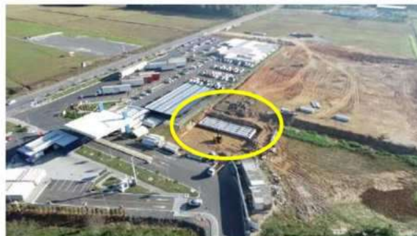
Bacia de retenção de águas pluviais – etapa 2
