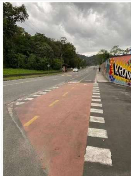
Ciclofaixa em bom estado de conservação
