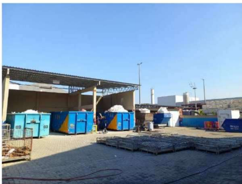
Central de resíduos
