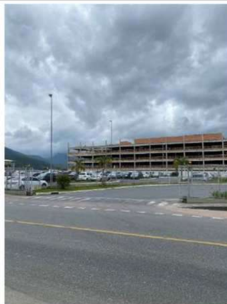
Iluminação do estacionamento da Krona
