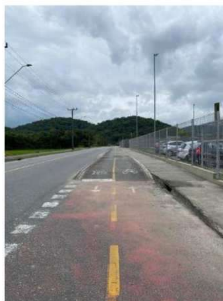
Ciclofaixa na Rua dos Suíços em frente ao empreendimento
