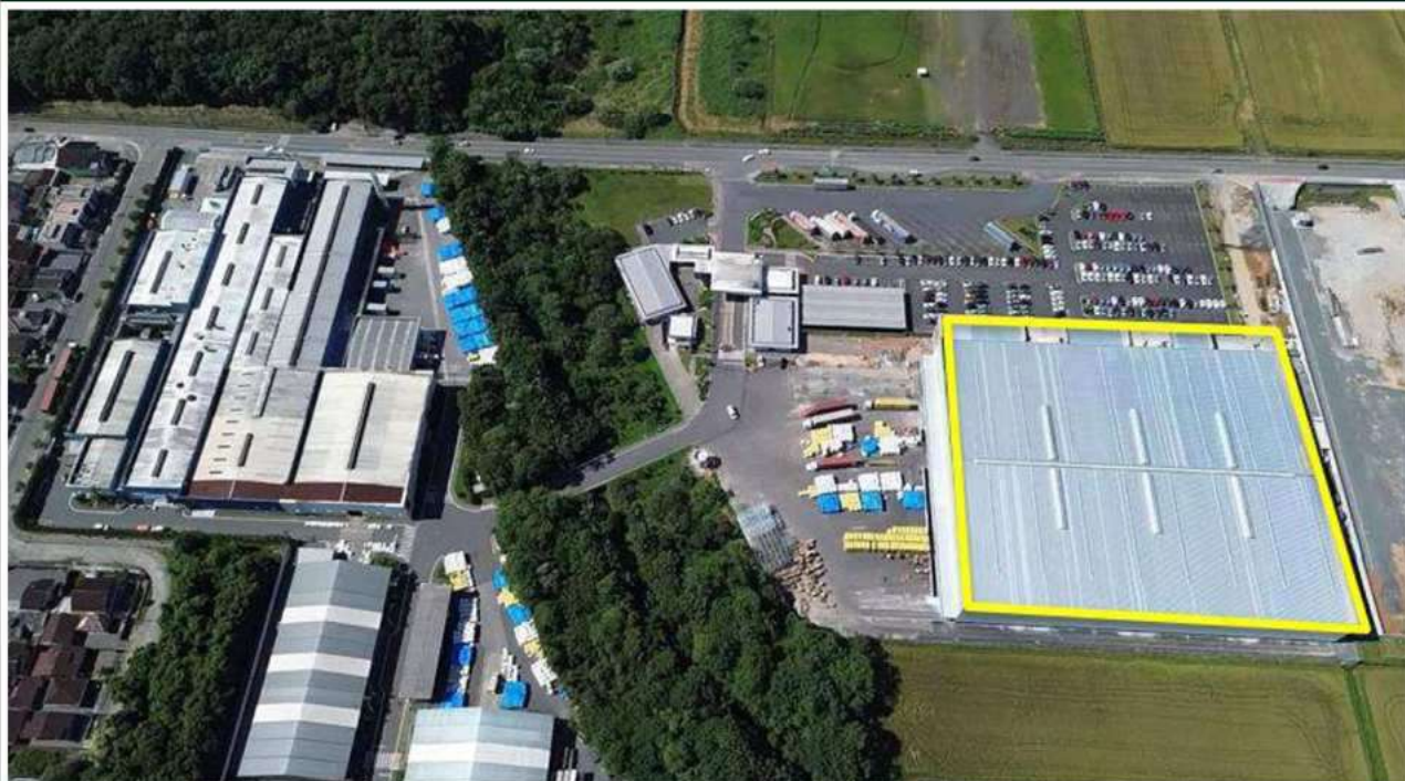
Galpão construído de 17.021,30 m²
