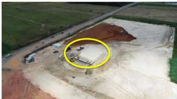
Bacia de retenção de águas pluviais – etapa 1
