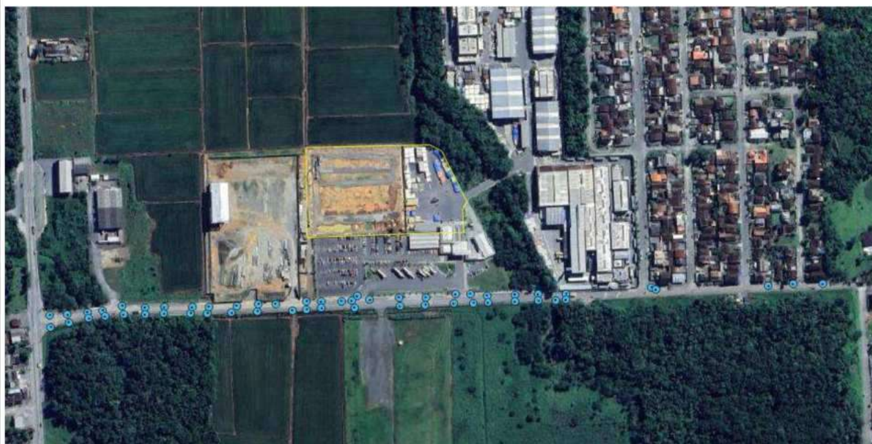
Dispositivos de drenagem.
