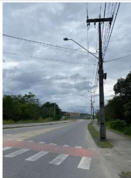
Faixa de pedestres e acessibilidade na Rua dos Suíços, esquina com a Rodovia Rodolfo Jahn
