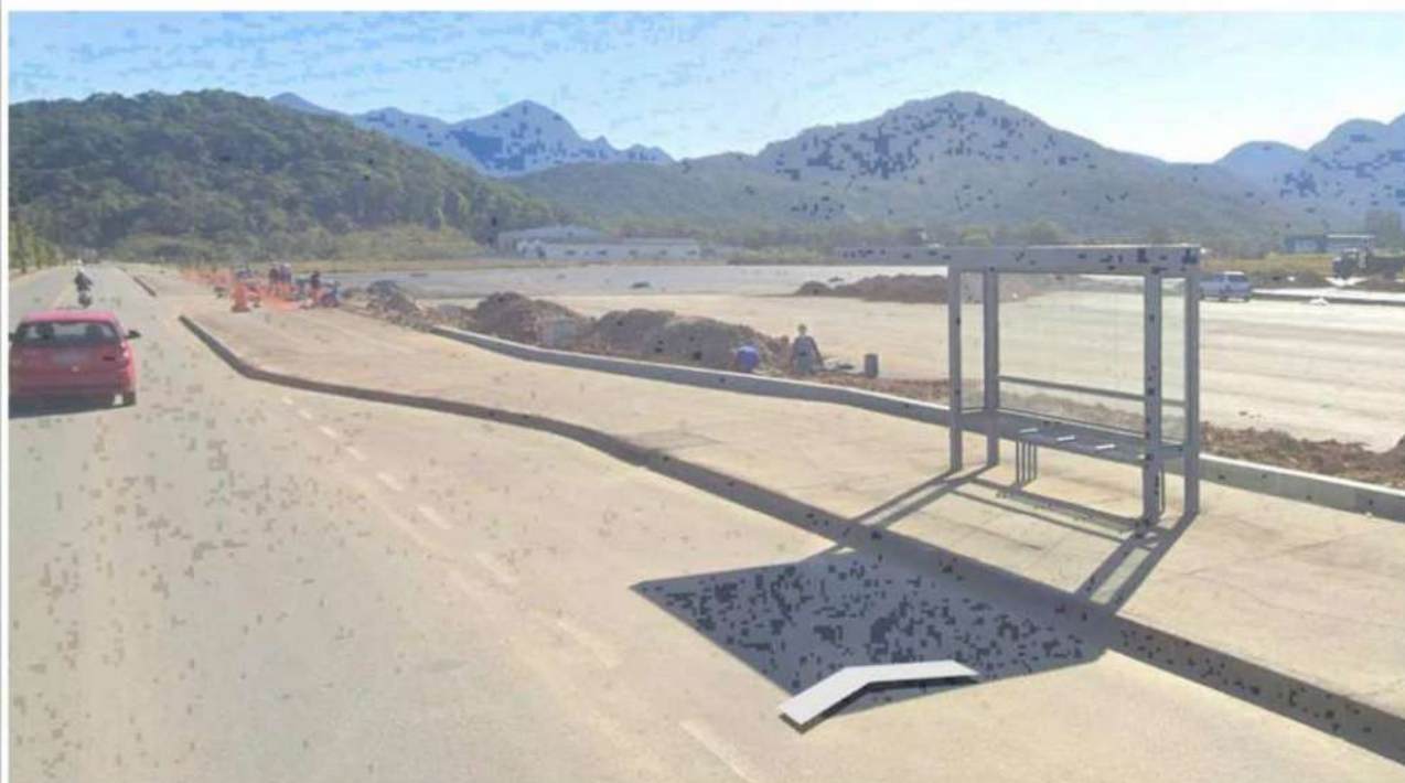
Localização ponto de ônibus Rua dos Suíços (com abrigo em bom estado de conservação). Coordenadas Geográficas 26°16'40.58"S 48°55'07.62"O
