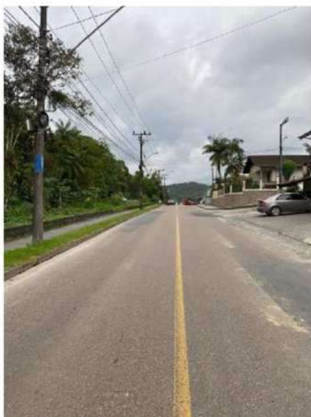
Faixa amarela dividindo as pistas de tráfego em bom estado de conservação
