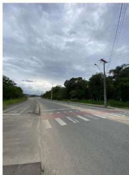
Calçada com acessibilidade e faixa de pedestres
