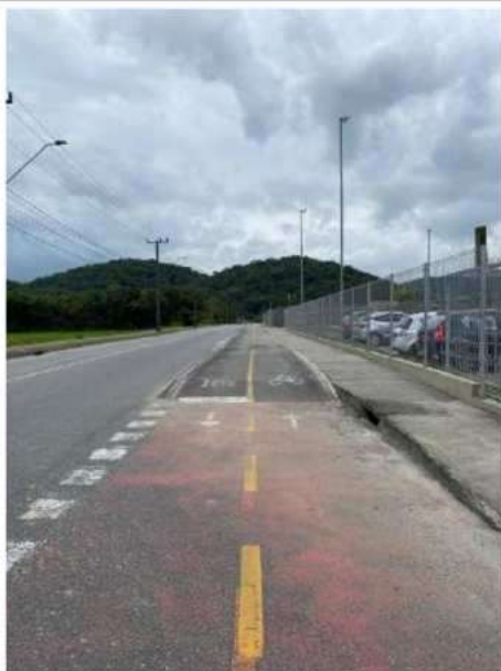
Iluminação do estacionamento da Krona
