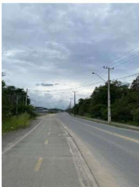
Calçada e ciclofaixa
