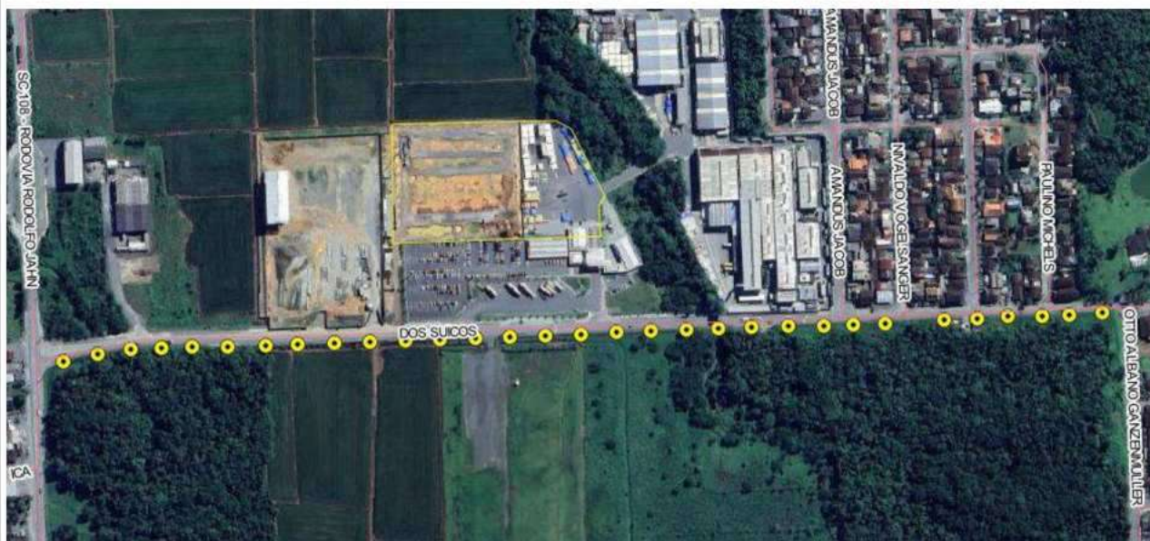
Postes de iluminação pública.
