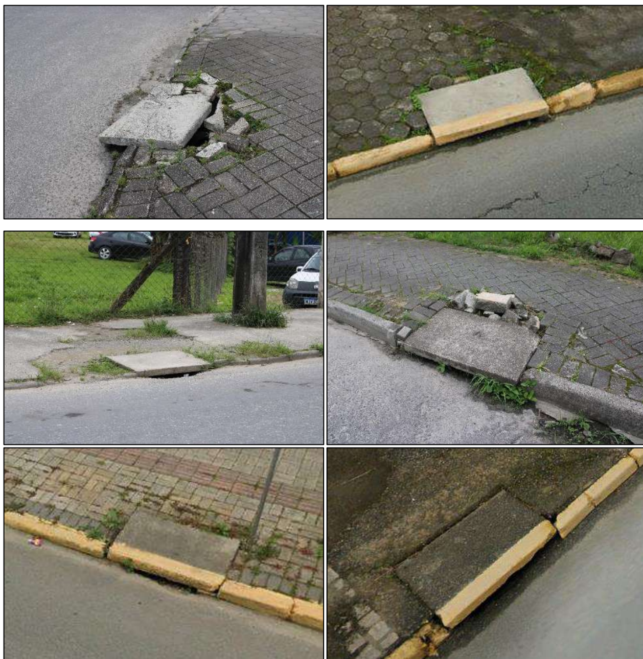
Figura 30 - Bocas de lobo nas ruas de acesso ao empreendimento. Fonte: Bioeco, 2024.
