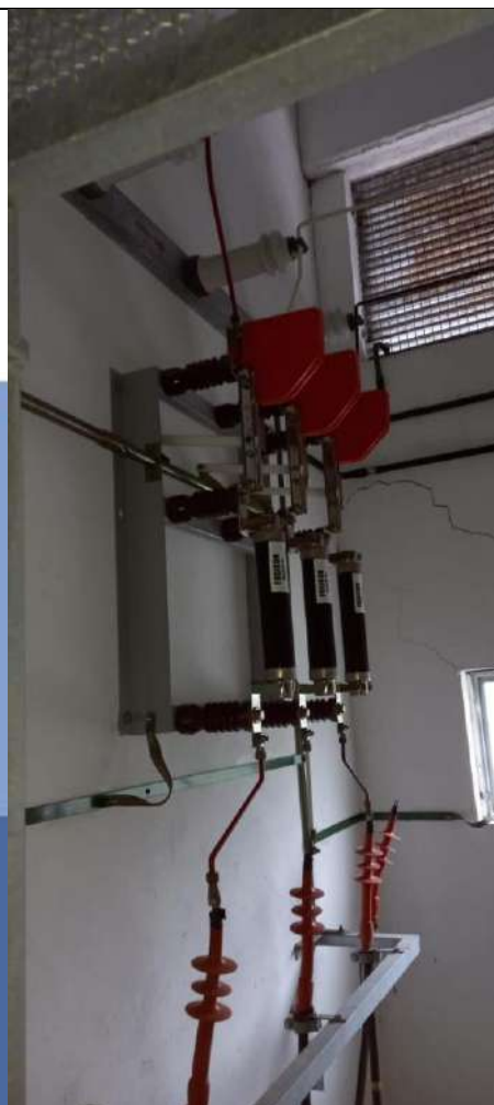
Chave Seccionadora
