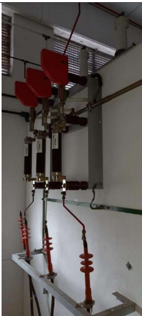
Chave Seccionadora
