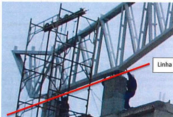
Foto 32- Alinhamento Banzo durante montagem
