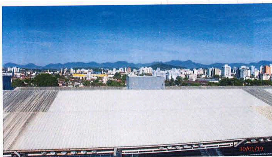
Foto 29 – Pintura de proteção da telha
