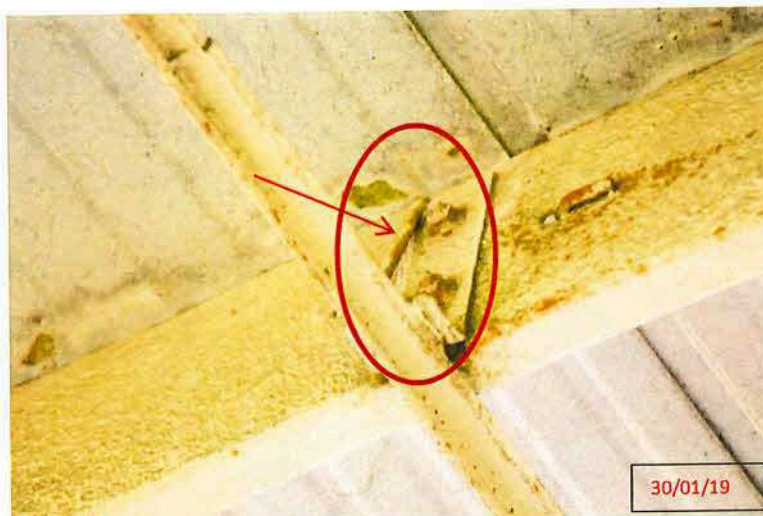
Foto 21- Suporte das LC e terças em desacordo com o Projeto
