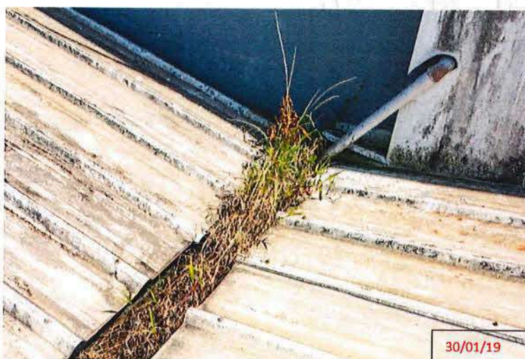
Foto 27 – Calha com matéria orgânica
