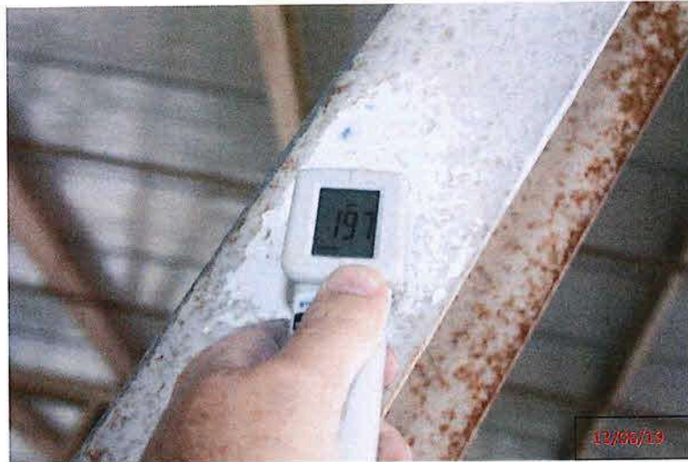
Foto 2 – Medição de espessura de Tinta
