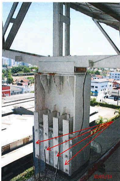
Foto 15- Aparelho de Apoio
