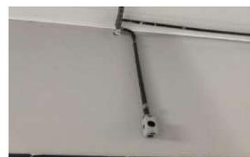
Foto 13 - Eletrocalhas sem tampa nas prumadas das Salas de Painéis dos pavimentos - 11/12/2024
