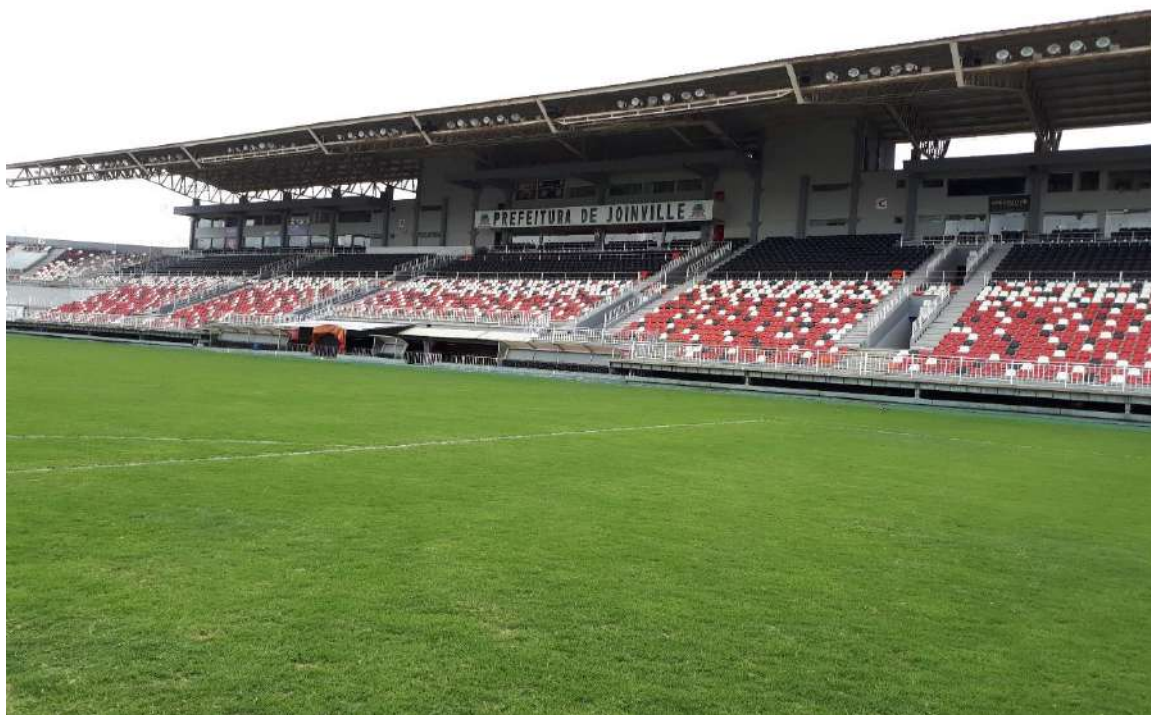
Foto 21 – vista geral do setor da sociais com cobertura metálica no Estádio
