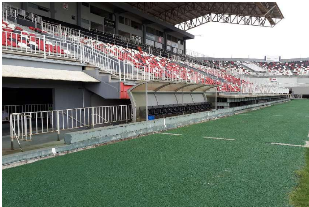
Foto 5 – Vista dos setores do Estádio
