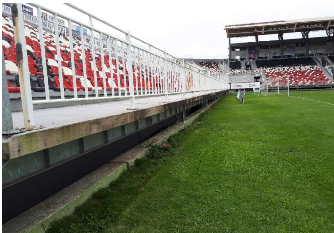
Foto 7 – Vista dos setores do Estádio
