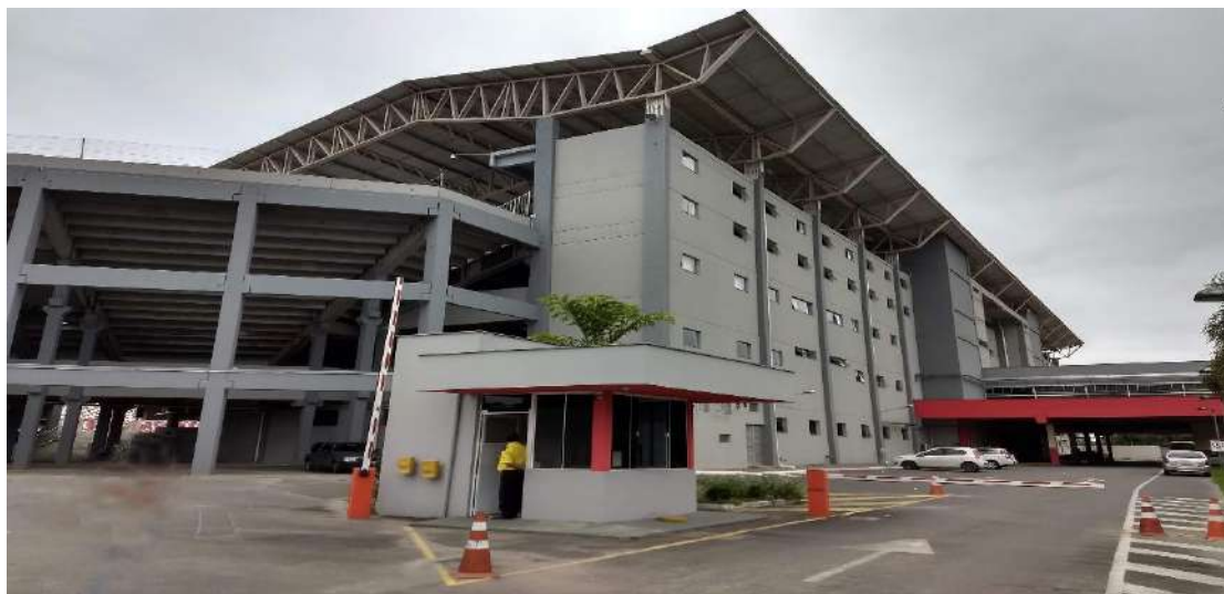
Foto 11 – Administradores do Estádio
