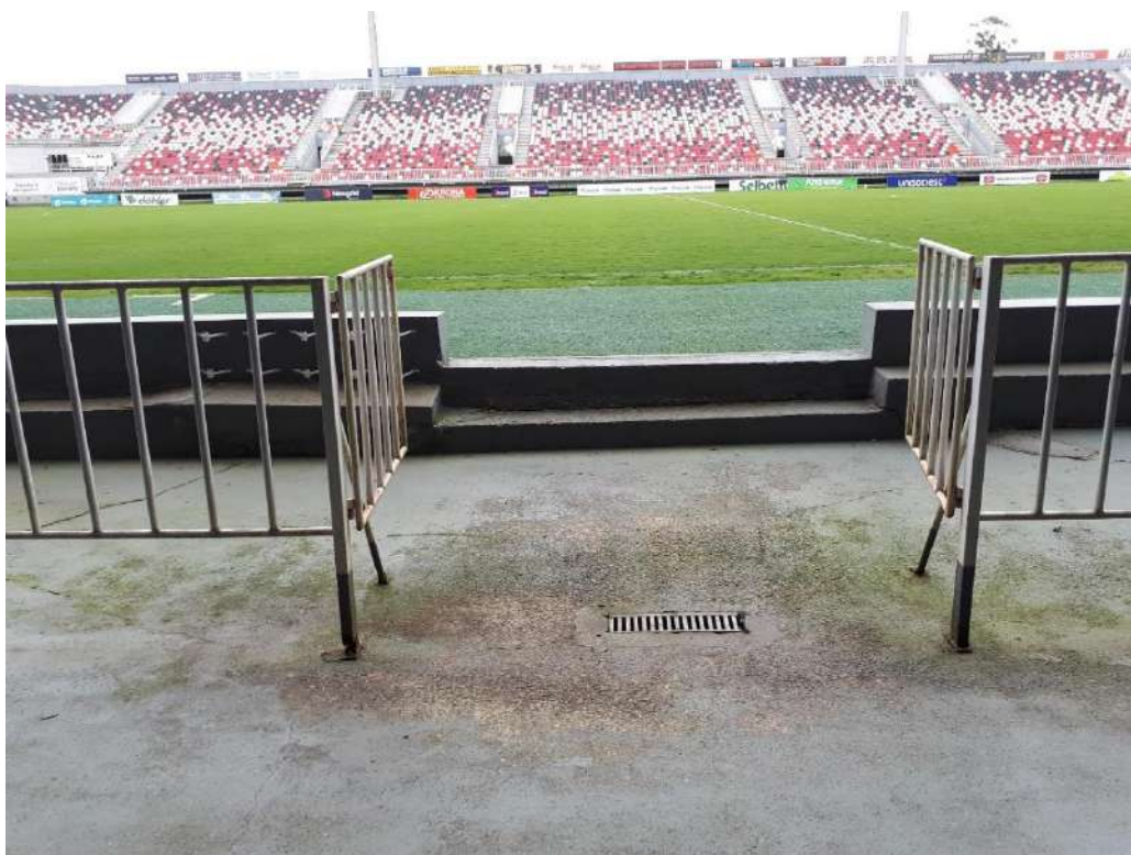
Foto 6 – Vista dos setores do Estádio
