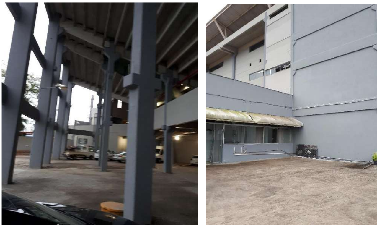
Foto 15 – Elementos estruturais do estádio recuperados
