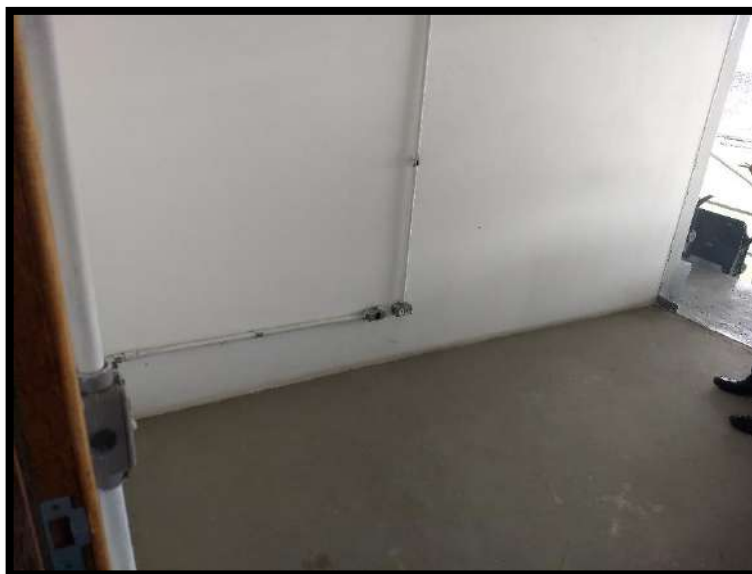
FOTO 12. Parede oeste camarote 8.
