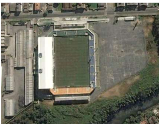
Figura 03 – Arena Joinville antes da ampliação.
