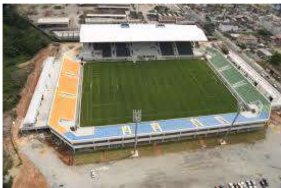
Figura 01 – Arena Joinville antes da ampliação.
