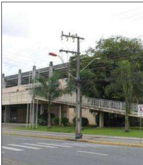
Figura 25: Entrada de energia para o empreendimento.
