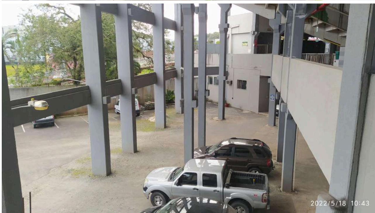
Área com esperas para ampliação
