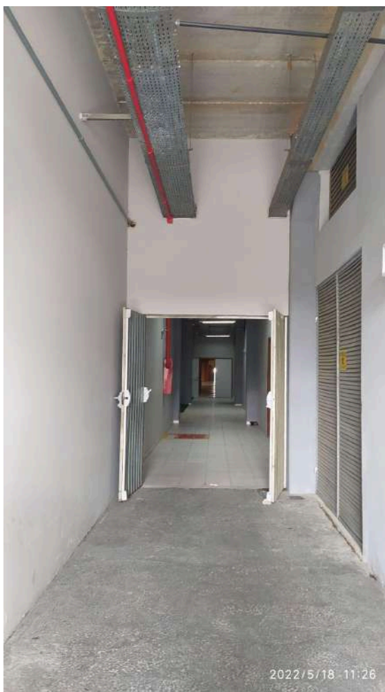
Corredor de acesso ao vestiário 1
