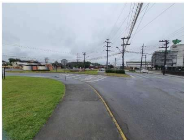
Figura 37 - Rótula próxima ao empreendimento
