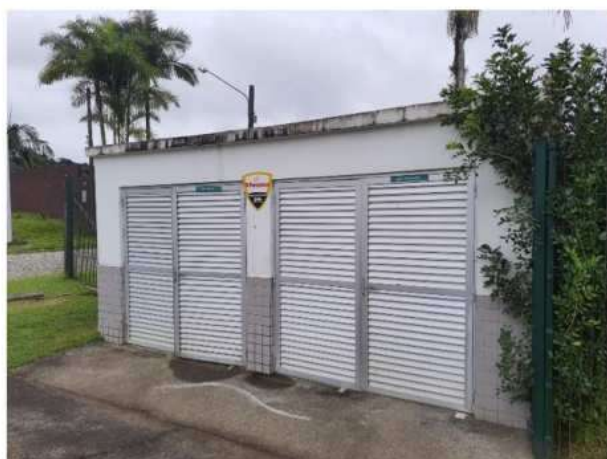
Figura 27 - Abrigo de rejeitos e recicláveis para coleta pública
