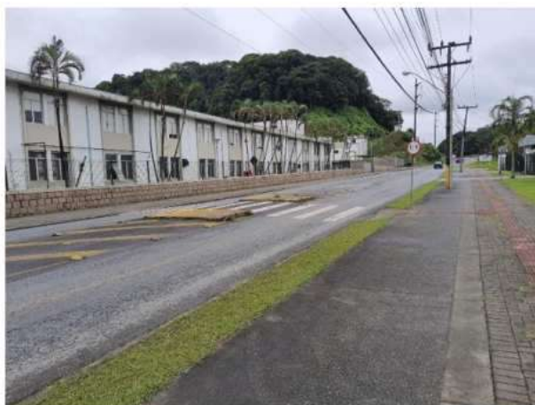
Figura 42 - Sinalização horizontal na rua do empreendimento e em faixa de pedestres
