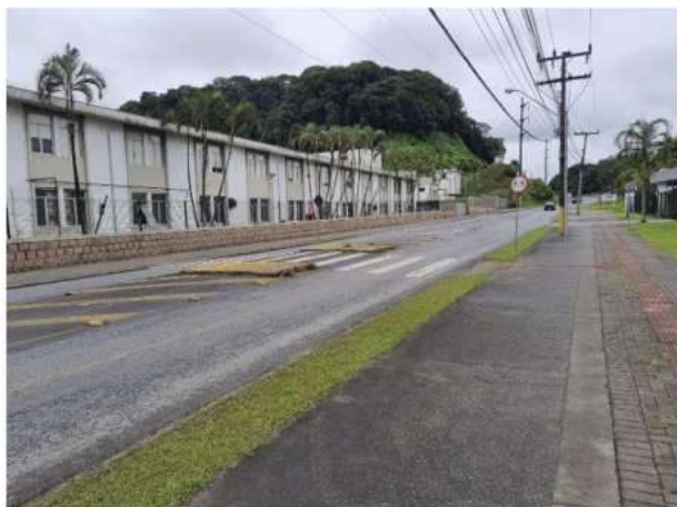
Figura 15 - Situação da pavimentação, faixa de pedestres, acessibilidade na transição da via para calçada
