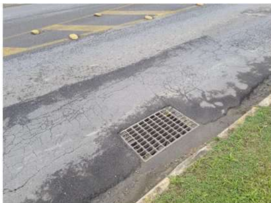
Figura 17 - Boca de lobo em frente ao empreendimento
