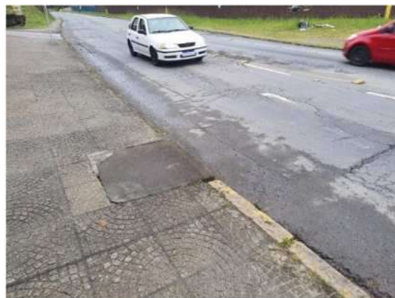
Figura 18 - Boca de lobo próximo ao empreendimento
