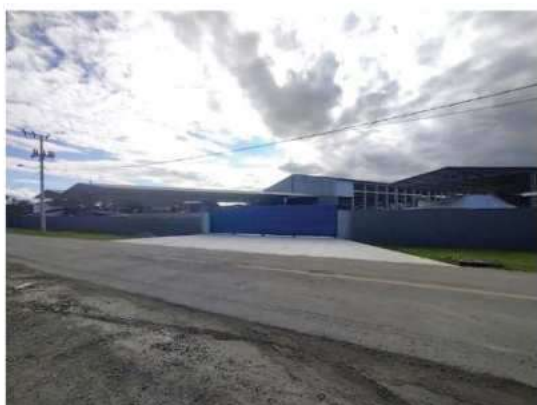
Fig. 03: Vista frontal do imóvel – Rua Cubatão Grande
