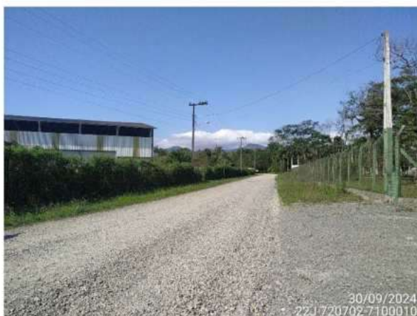
Figura 13 – Trecho da Estrada Cubatão Grande sem pavimentação asfáltica e situado na AID.
