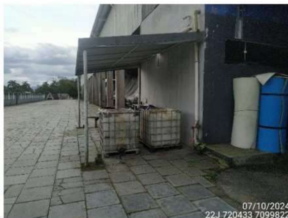
Figura 40 – Central de armazenamento temporário de resíduos recicláveis.
