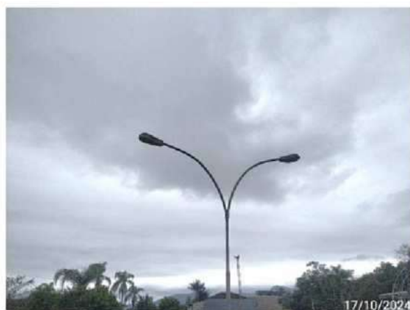
Figura 22 – Poste de iluminação localizada no empreendimento.
