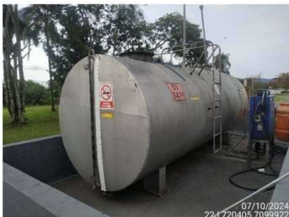
Figura 37 - Tanque de abastecimento de embarcações
