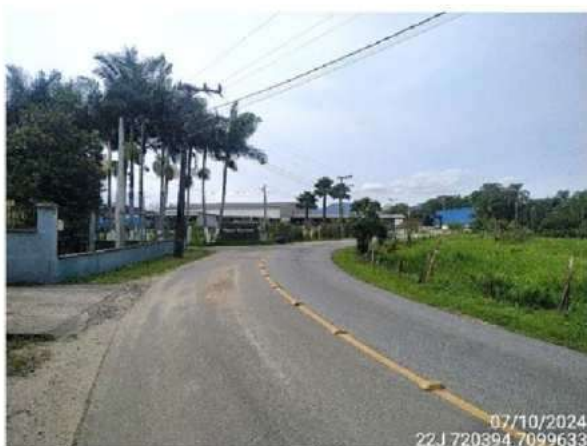
Figura 42 – Vista parcial da Estrada Cubatão Grande.
