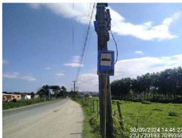
Figura 49 - Sinalização vertical na Estrada Cubatão Grande.
