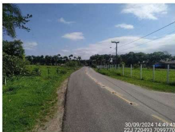
Figura 46 – Sinalização horizontal na Estrada Cubatão Grande.
