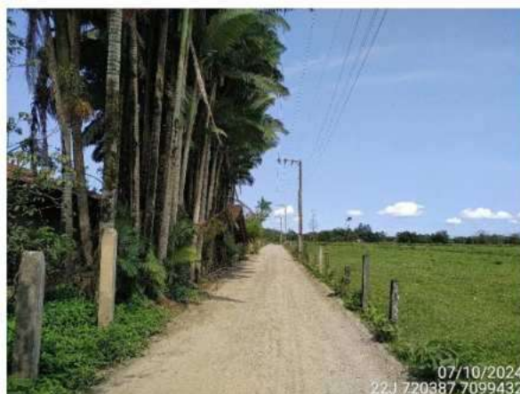
Figura 14 – Trecho da Servidão Willebaldo de Oliveira sem pavimentação asfáltica e situado na AID.
