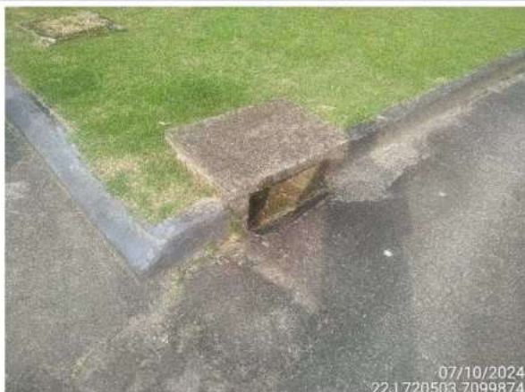
Figura 3: Boca de lobo na área interna do empreendimento
