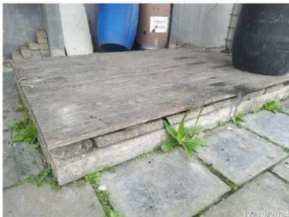
Figura 35 - Caixa de sedimentação de partículas e separador de água e óleo anexa ao Galpão 1.
