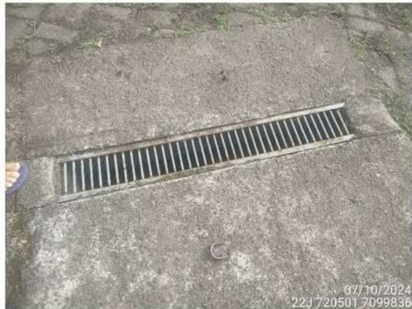
Figura 16 – Grelha presente na área interna do empreendimento
