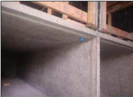
**Figura 17.** Impermeabilização dos lóculos (Cemitério Vertical de Maringá)
