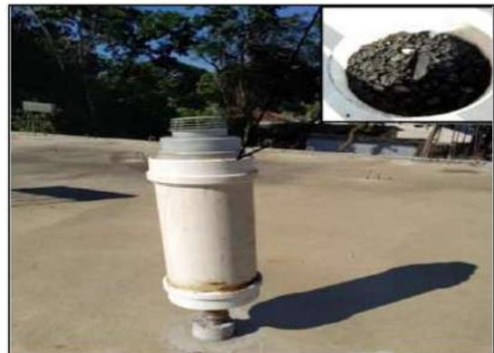
**Figura 20.** Parte superior do sistema de Filtração de e gases (Cemitério Vertical de Maringá)
