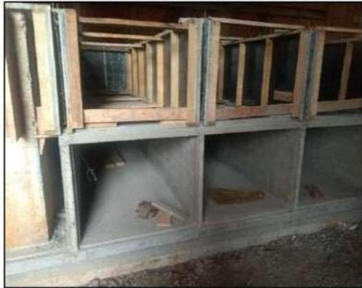
**Figura 15.** Lóculos em construção (modelo Cemitério Vertical de Maringá)
