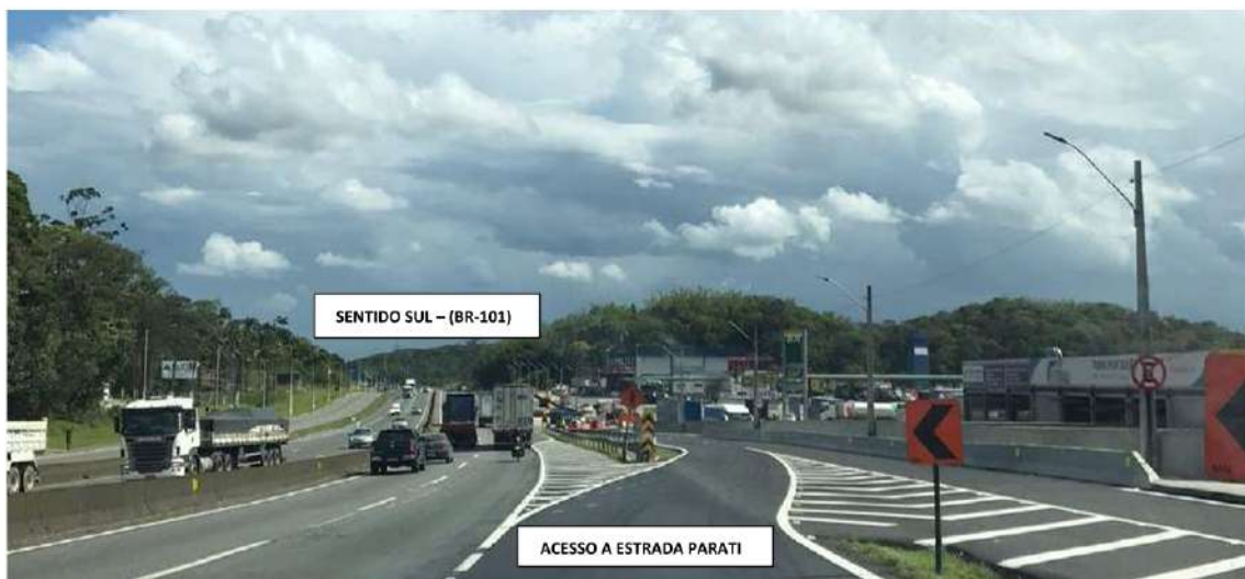
Foto 39 – Principal acesso pela (BR-101).
