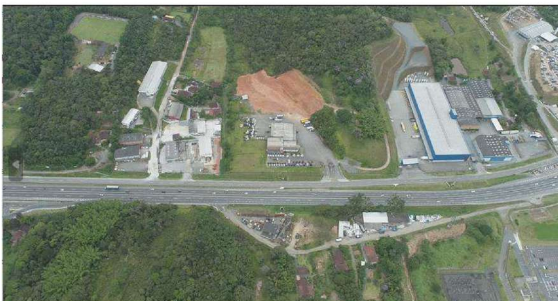
Foto 36 Vista edificações sentido Leste
