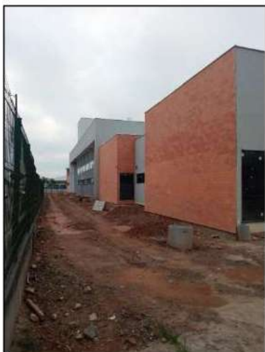
Figura 25. Capela – área lateral
