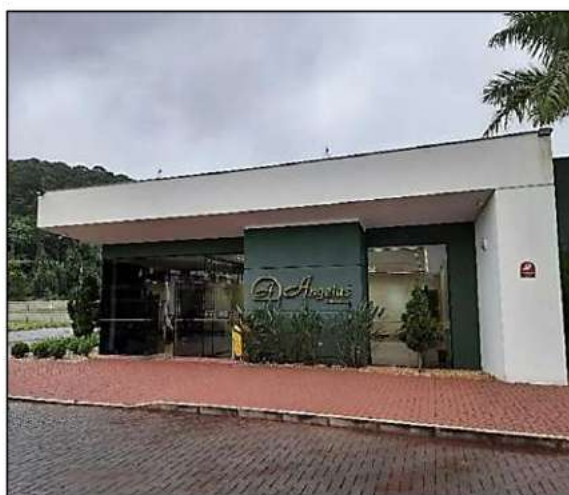
Figura 3. Entrada do Crematório Fonte: Doré Engenharia, 2022.
