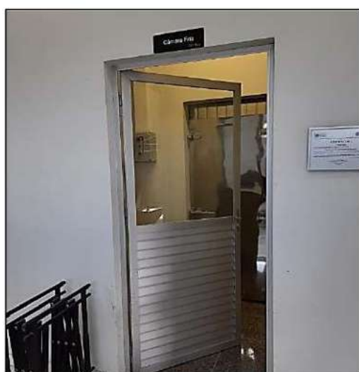
Figura 7. Câmara Fria Fonte: Doré Engenharia, 2022.
