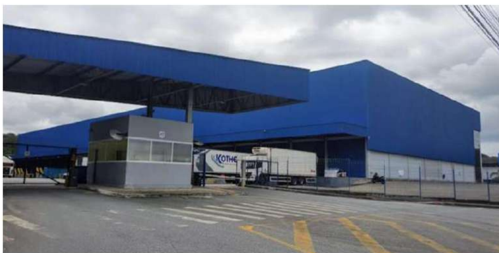
Foto 07: Terminal de carga em frente ao empreendimento
