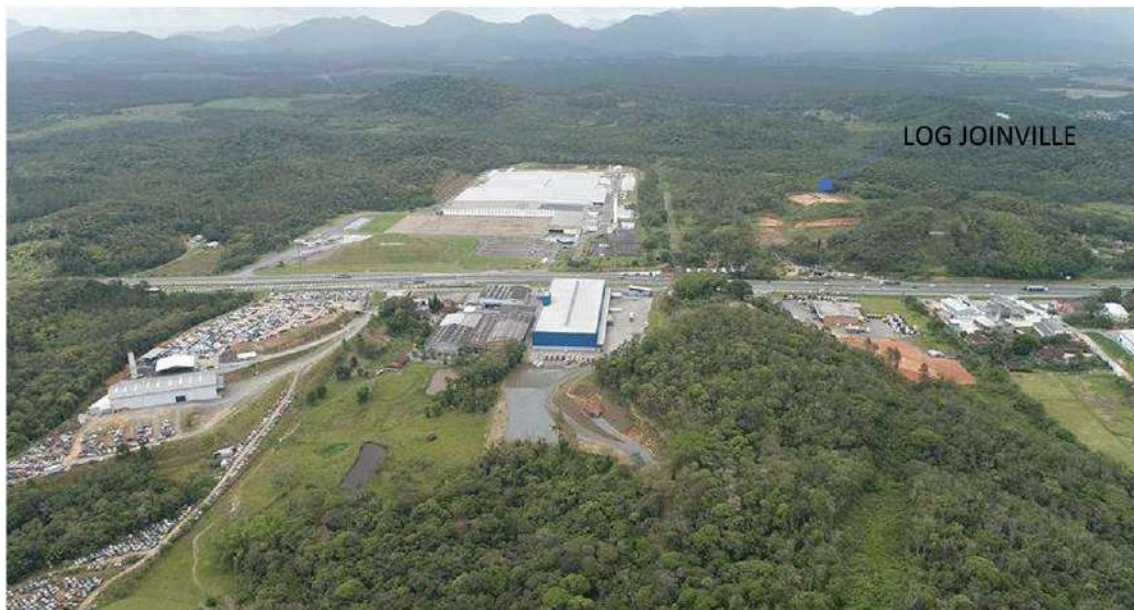
Foto 38: Vista geral de frente do imóvel
