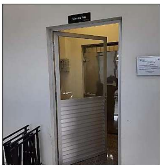
Figura 7. Câmara Fria Fonte: Doré Engenharia, 2022.
