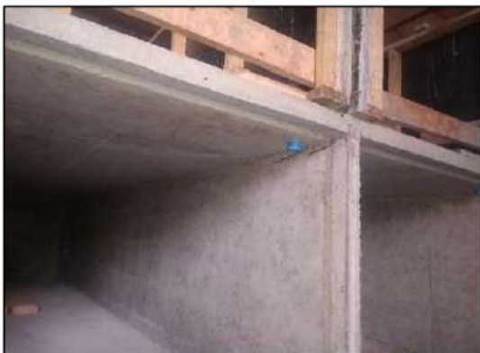
Figura 17. Impermeabilização dos lócúlos (Cemitério Vertical de Maringá) Fonte: Doré Engenharia, 2020
