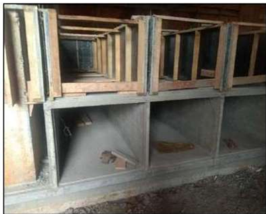
Figura 15. Lócúlos em construção (modelo Cemitério Vertical de Maringá) Fonte: Doré Engenharia, 2022
