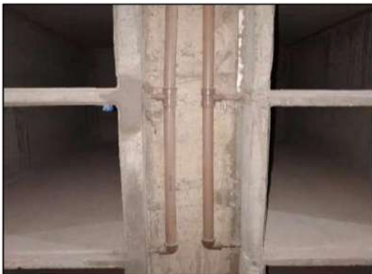
Figura 19. Sistema de filtração de gases (Cemitério Vertical de Maringá) Fonte: Doré Engenharia, 2020
