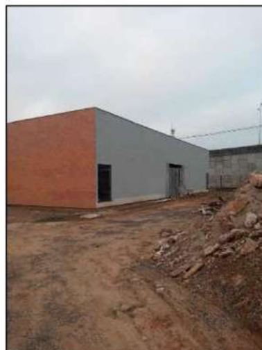
Figura 26. Capela – área de trás
