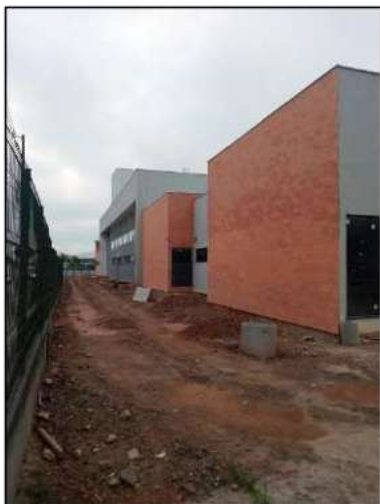
Figura 25. Capela – área lateral
