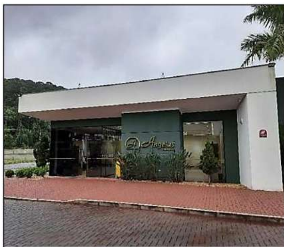
Figura 3. Entrada do Crematório Fonte: Doré Engenharia, 2022.
