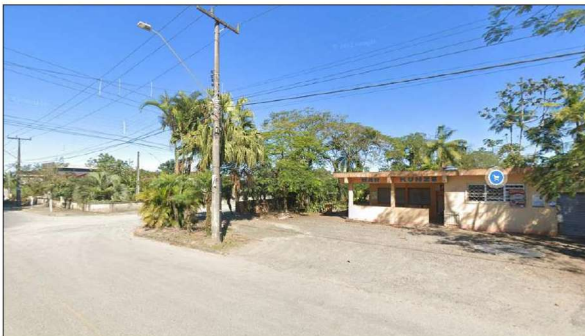
Figura 42: Visão geral do entorno do empreendimento – rede de energia elétrica, iluminação pública rua asfaltada, comércio. Fonte: Arquivo pessoal, 2021.
