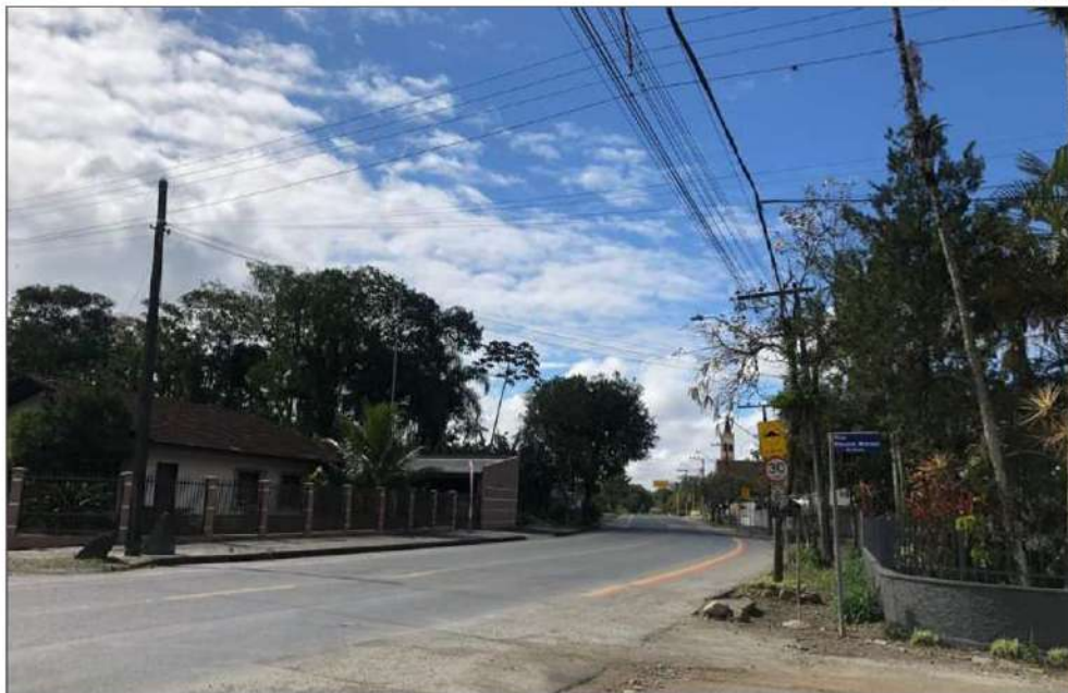
Figura 54: Acesso ao empreendimento pela Estrada de Oeste com sinalização viária.
