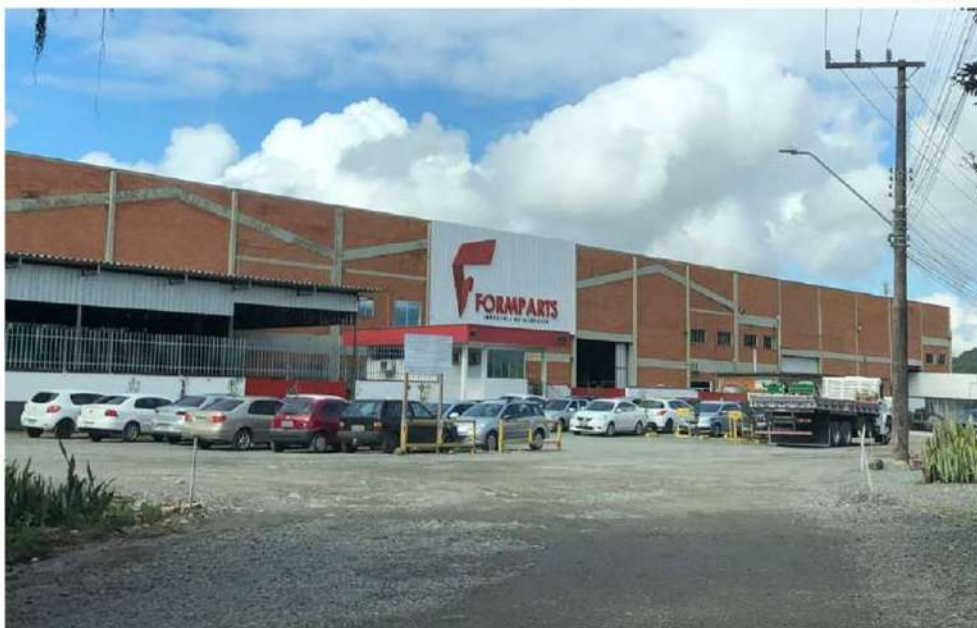
Figura 62: Estacionamento existente dentro da área do imóvel. Fonte: Arquivo pessoal, 2022.
