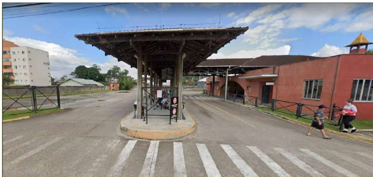
Figura 60: Terminal Pirabeiraba, localizado na All do empreendimento.
