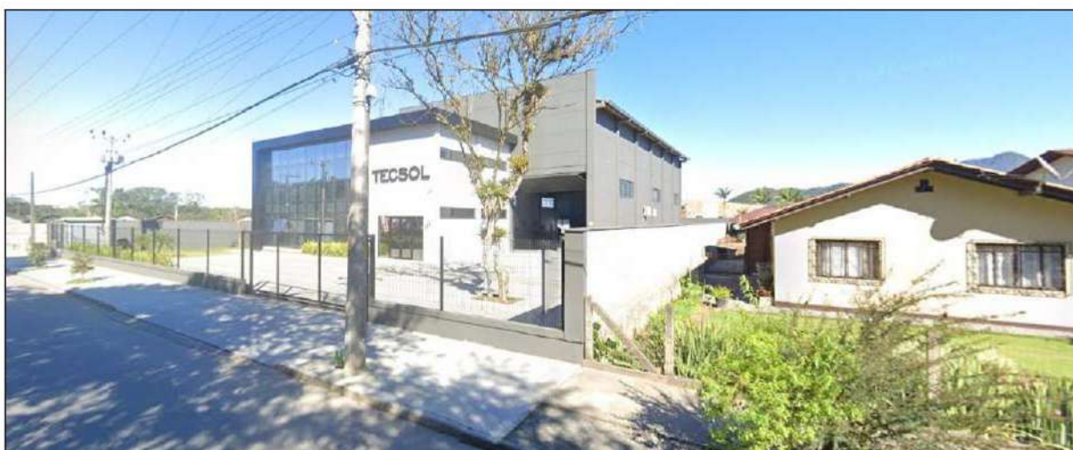
Figura 46: Visão geral da AID empreendimento – Comércio, residência, rede de energia elétrica, rua asfaltada, calçada.
