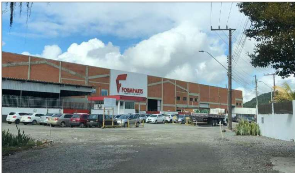
Figura 29: Acesso ao empreendimento pela Rua Quinze de Outubro, não pavimentada. Fonte: Acervo pessoal 2022.
