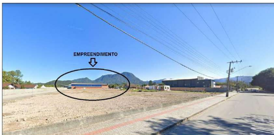
Figura 70: Vista da Estrada do Oeste para o entorno do empreendimento. Fonte: Google Maps, 2022.
