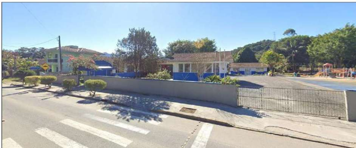
Figura 47: Visão geral da AID empreendimento – rede de energia elétrica, rua asfaltada, escola, calçada, sinalização viária.
