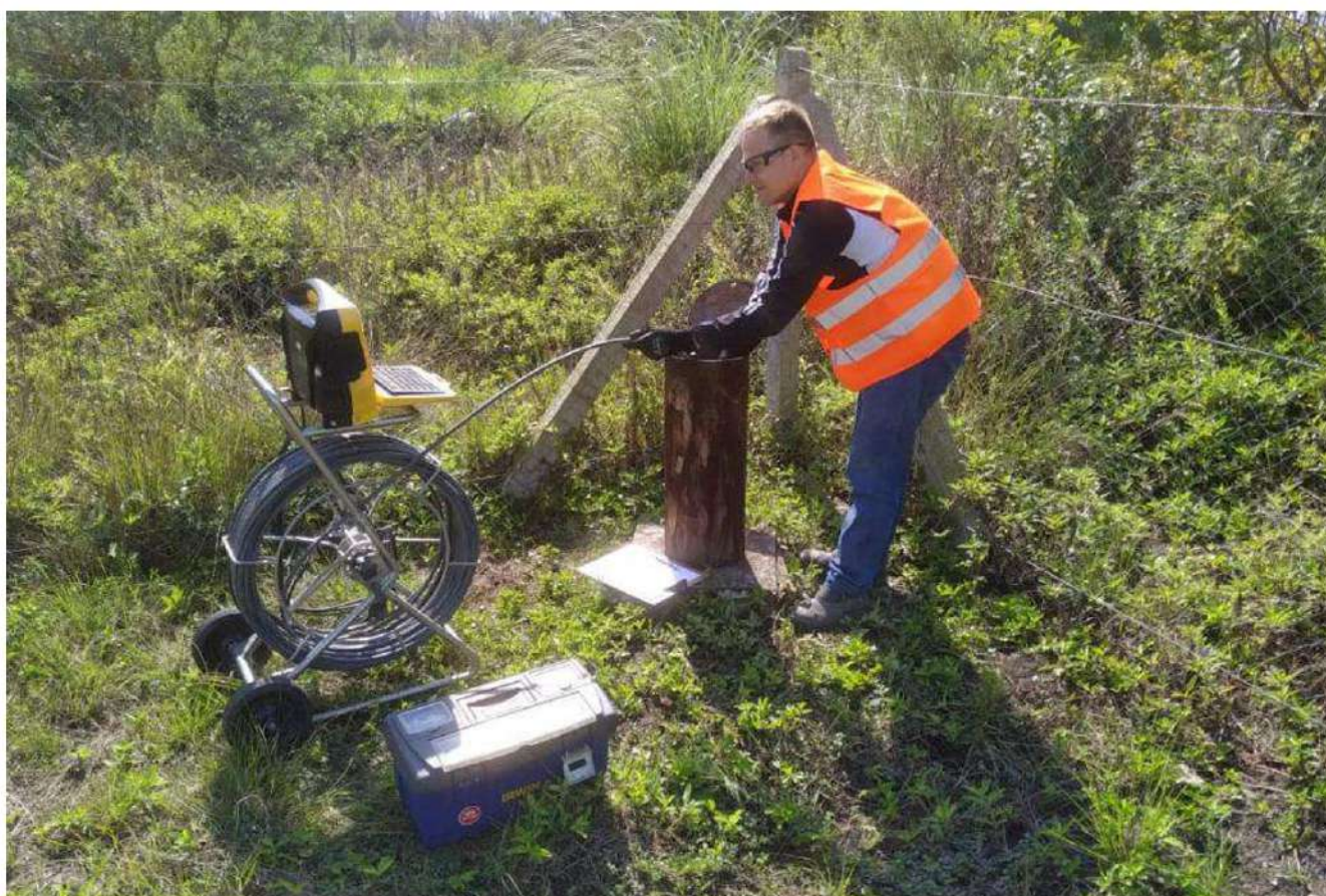
Figura 2: Local de trabalho para inspeção
