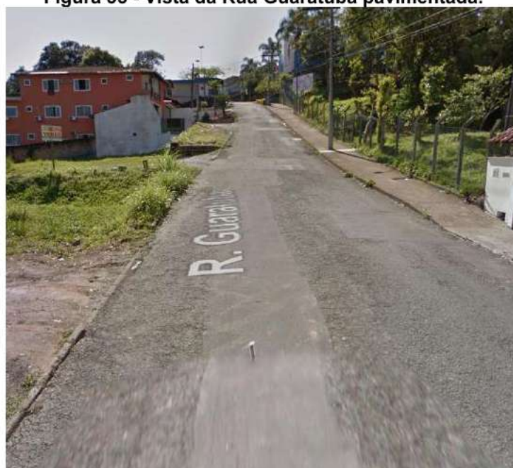
Figura 35 - Vista da Rua Guaratuba pavimentada.
